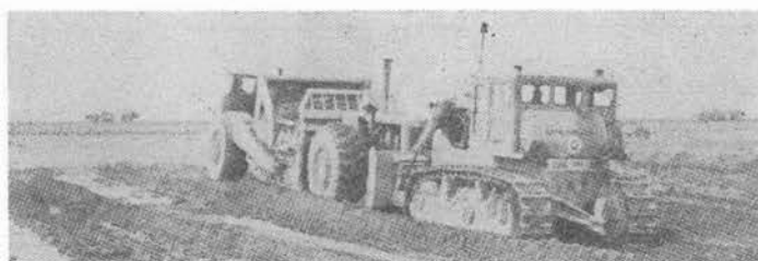
写真-2 プッシュドーザに信号灯を装備し、スクレーパの積込時間を 10~15 sec の短縮化
