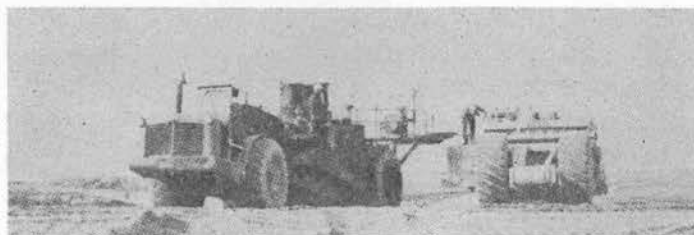
写真-3 スクレーパのボウルを給油タンクに改造し、建設機械部隊への給油時間の迅速化
