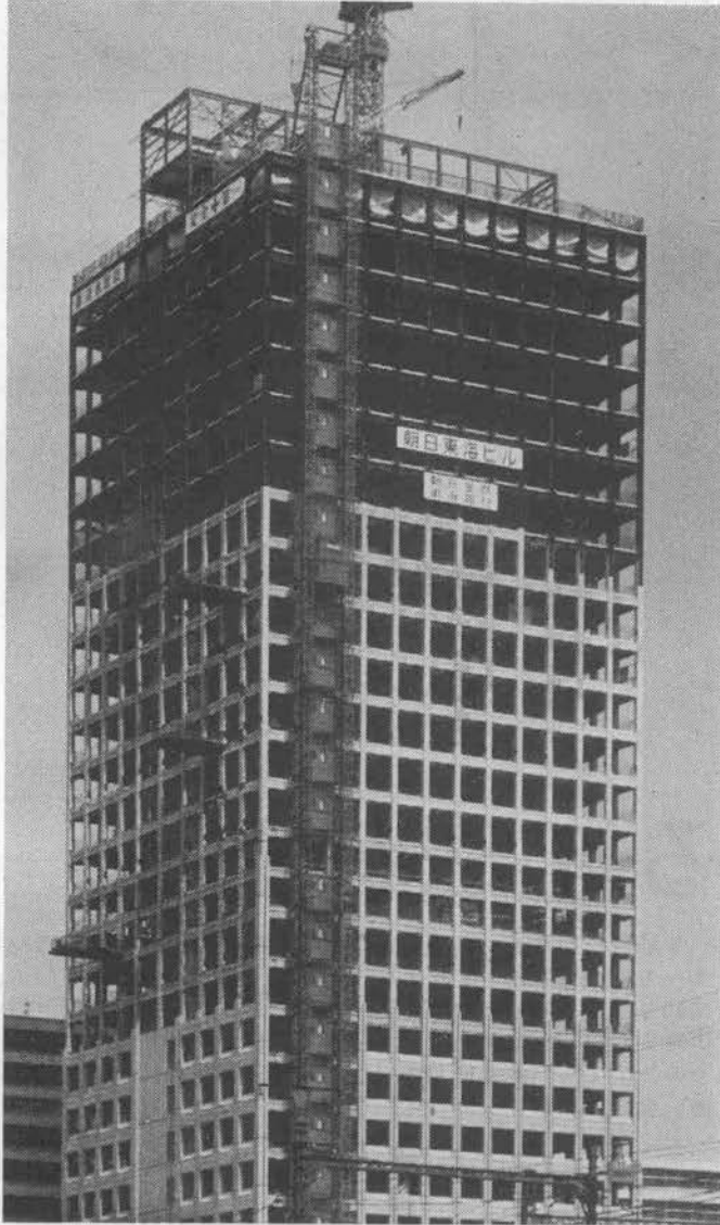
丸ノ内朝日東海ビル作業所
