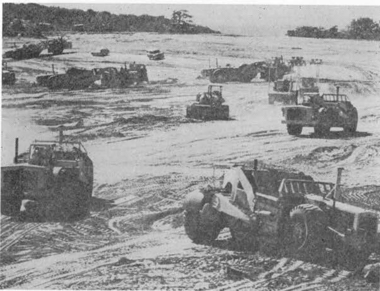
← 写真一 綿密な計画で平均 1 日当り 13.6 万 m^3 の土量を運搬した大スクレーパ部隊
