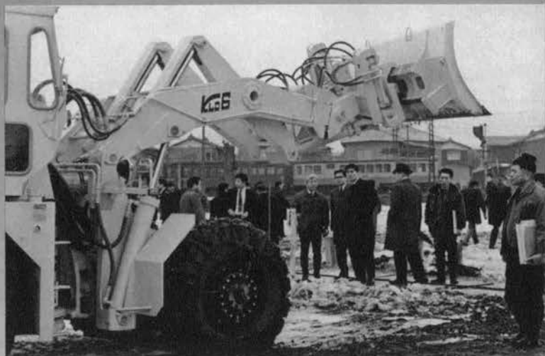
▲除雪ドーザ KLD 6 ブラウ付 (9 t・川崎重工業)
