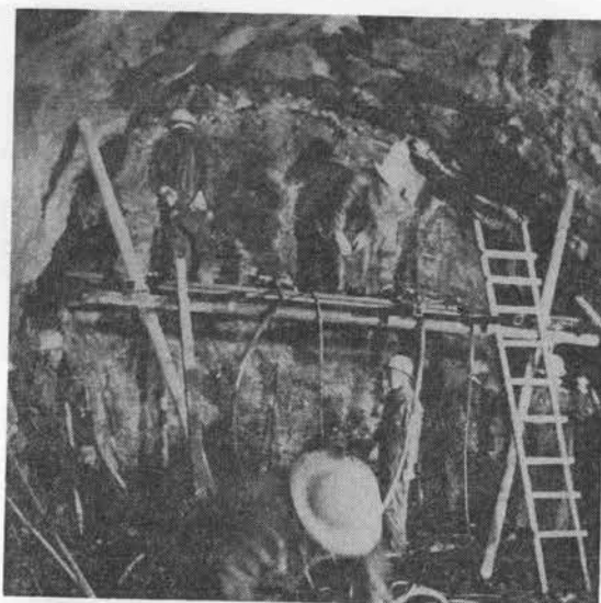
写真-3 斜坑の全断面掘削
