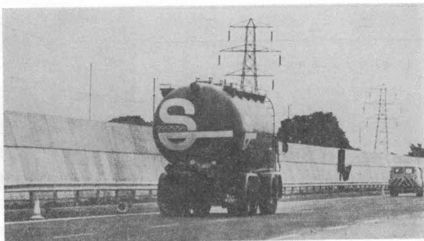
自動車専用道路におけるしゃ音壁の状況
