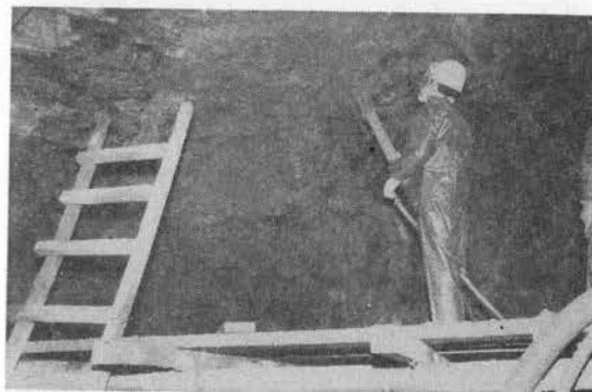
写真-4 吹付作業状況
