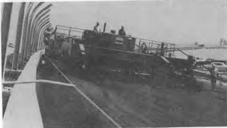
1台の機械で路盤からアスファルト舗設まで施工した機械
