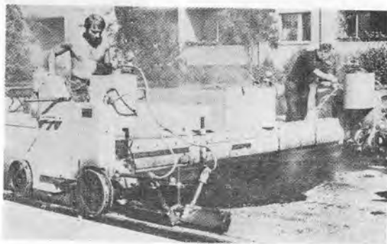
↓写真-11 せまい作業幅用のグースア スファルトフィニッシャ
