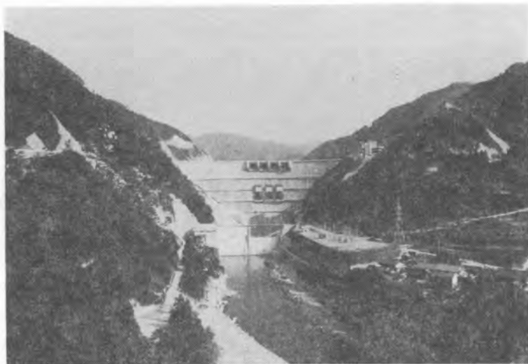
写真-1 竣工した矢作ダム
