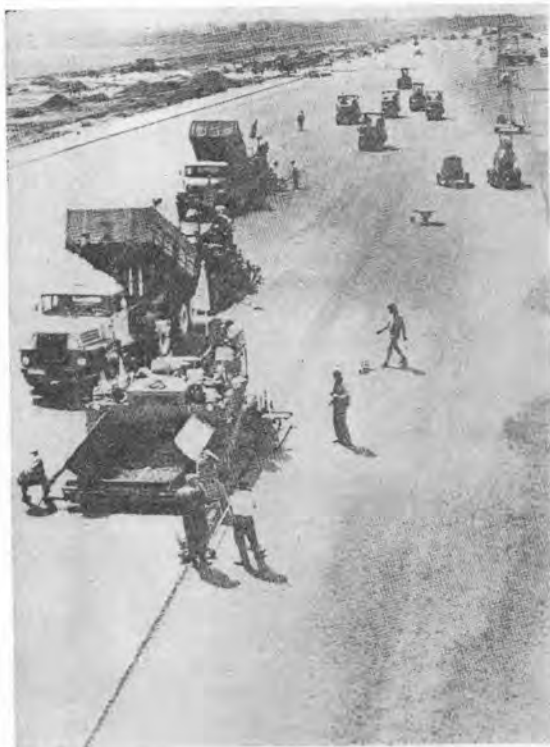
←写真-7 ミュンヘン・リーム空港におけるフィンリッシュ群の施工状況
