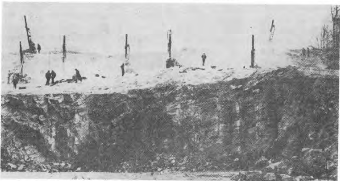
5台のドリル(手前)で7.6cm径の発破孔が、また2台の補助機械(後方)で6.4cm径のプレスプリット孔がせん孔されている。
