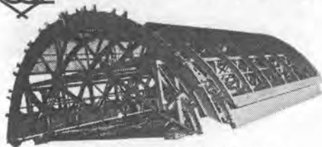
山陽新幹線上半スライドセントル
