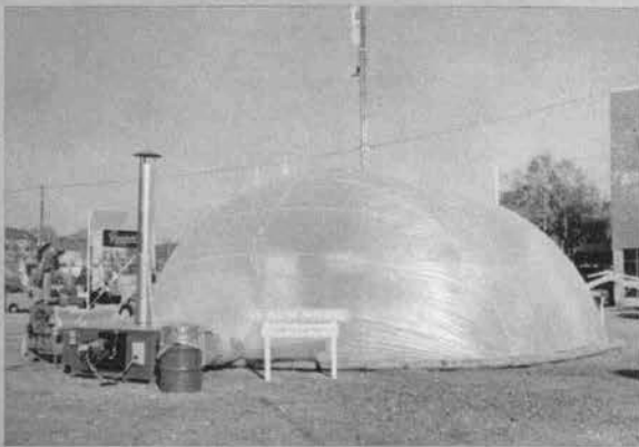
▲暖房可能な空気圧によるビニール製上屋 (トロンドハイム)
