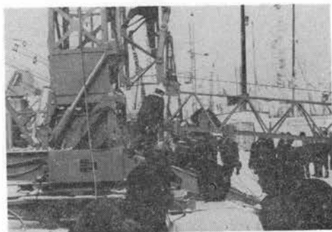
写真-2 フェーストエレクションクレーンの組立実演
