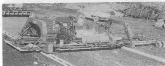
写真-22 前方より見たボックススプレッド
