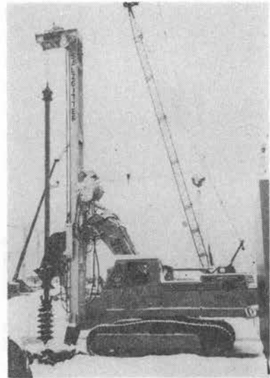
写真-9 アースオーガを取付けた油圧ショベル (Liebherr 961 油圧ショベル, Salzgitter アースドリル)
