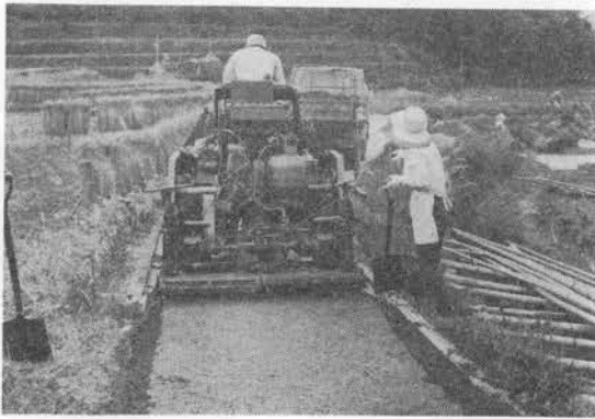
写真-18 後方より見た狭幅道路用アスファルトフィニッシャ（舗設幅 1.5 m）
