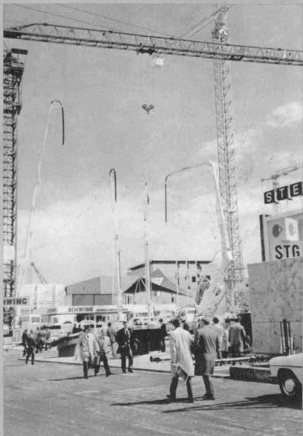
▲タワークレーンとコンクリートポンプ (ハノーバー)
