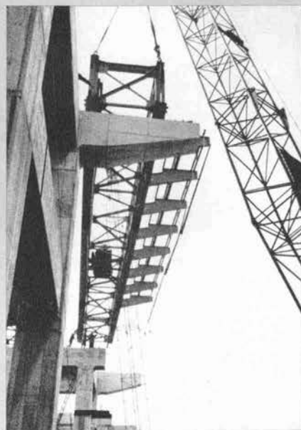
▲2台のトラッククレーンによる合成げたの架設
