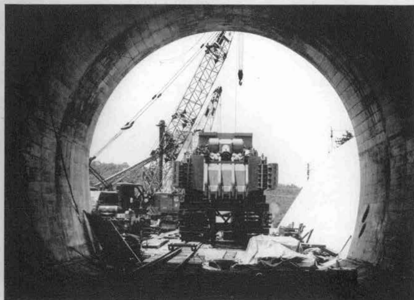
◀高塚山トンネルの全断面掘削用に採用されたメムコ社製ビッグジョントンネル掘削機を岡山方坑口において組立中
