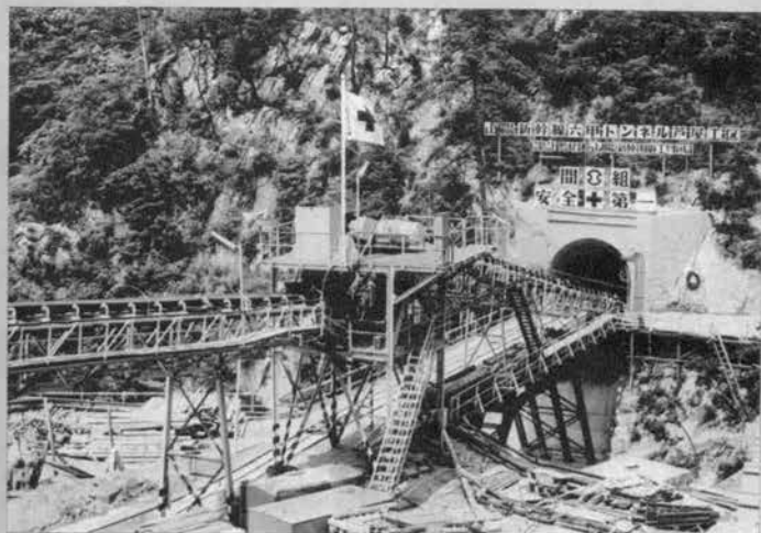
▲六甲トンネル芦屋工区の斜坑入口と坑外設備
