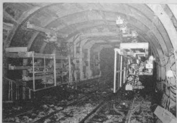
▲新関門トンネル 金山工区の導坑で活躍中の 6ブーム装備したジャンボ
