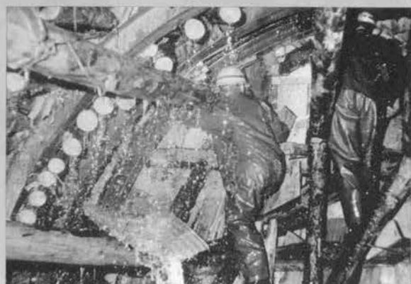
▲芦屋工区の導坑掘削中、おびただしい湧水に遭遇したため鏡止めの作業中
