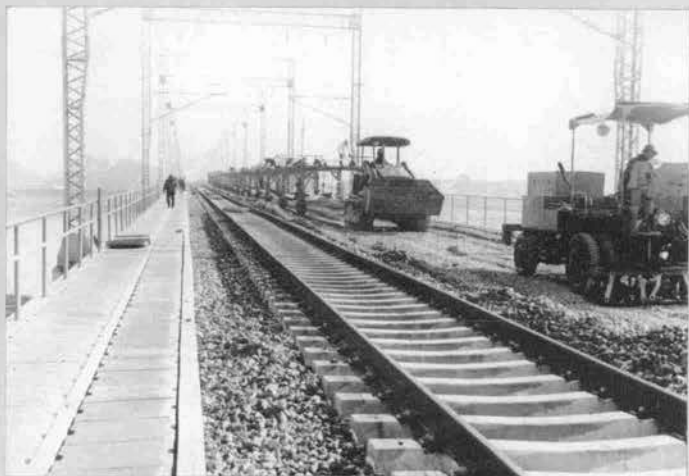
▲完成した橋りょう上に下部バラストを敷設して長さ150 mの軌きょうの敷設作業
