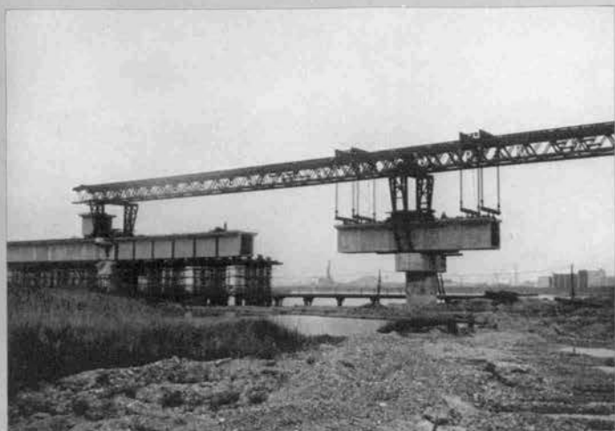
▲ブロックカンチレバー工法による加古川橋りょう (PCけた)のけた架設
