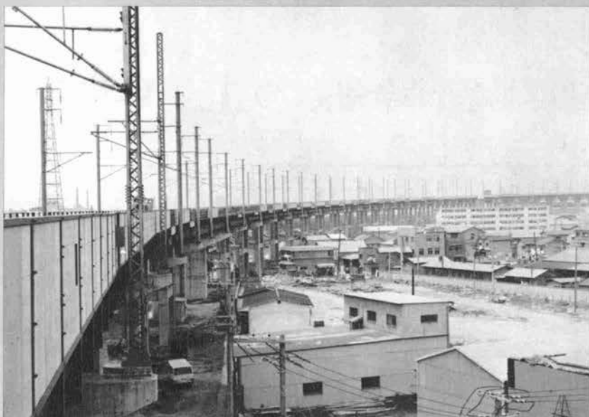
▲大阪市内を通過する完成した山陽新幹線
