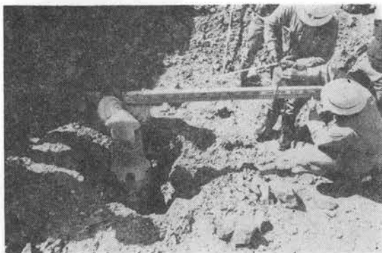
写真-1 パイロットホールが貫通したところ
