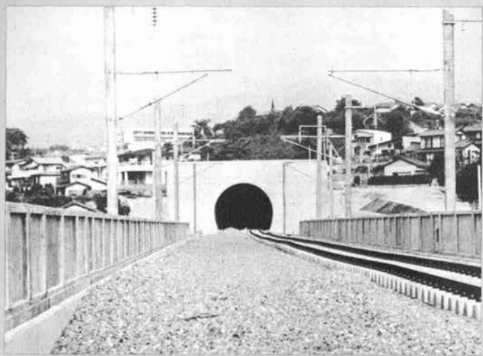
◀完成した六甲トンネル入口
