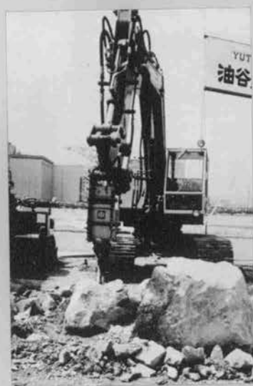
▲碎石ブレーカを装備した 油圧ショベル
