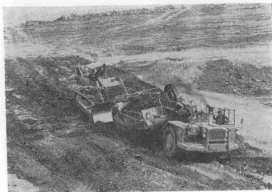
写真-4 モータスクレーパによる積込作業
