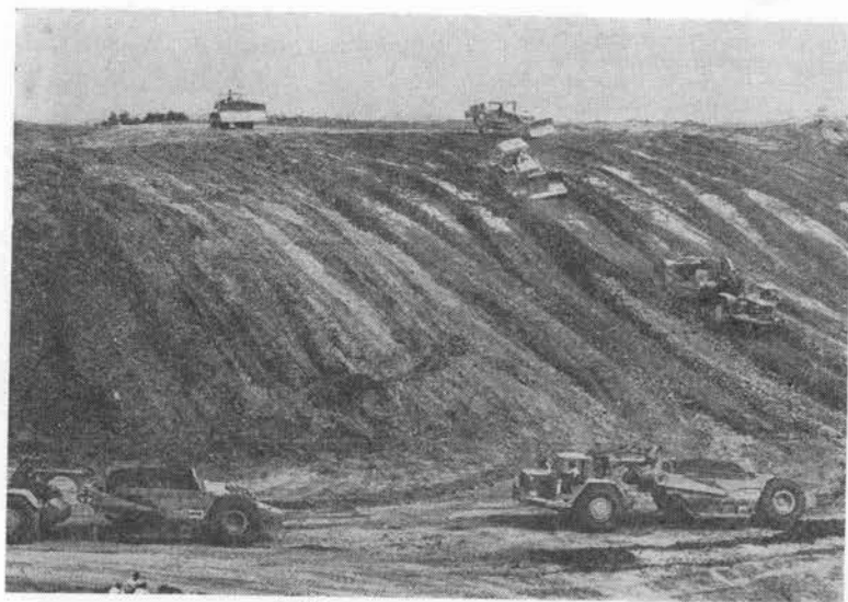
写真-3 モータスクレーパ作業
