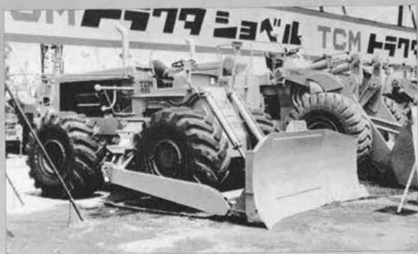
▲国産化された広幅タイヤドーザー
