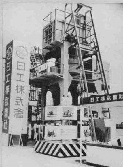
▲コンクリートプラント
