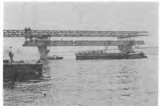
写真—6 I げた (定着げた) 架設後の架設トラスの置換え
