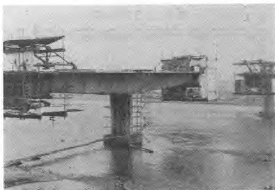
写真-2 架設作業車を4基使用して流水部を架設中
