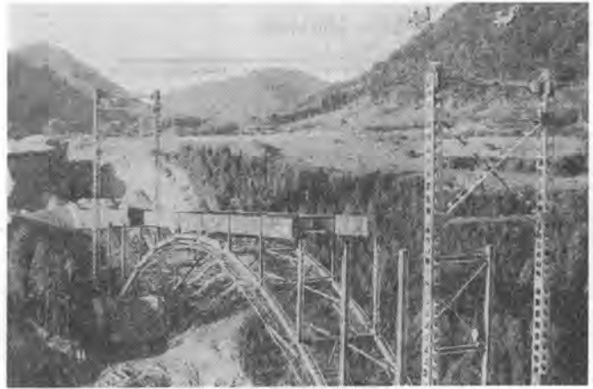
写真-3 補剛材 ⊕ 番げたまで架設
