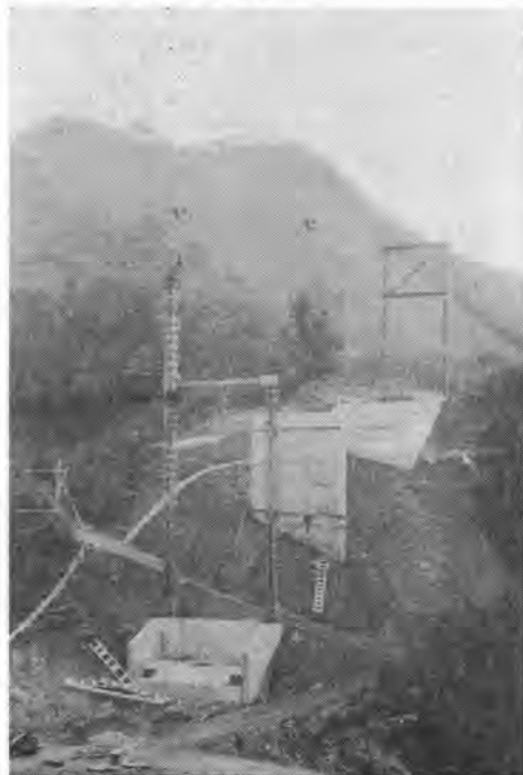
写真-1 T 2 : 中間タワーの組立
