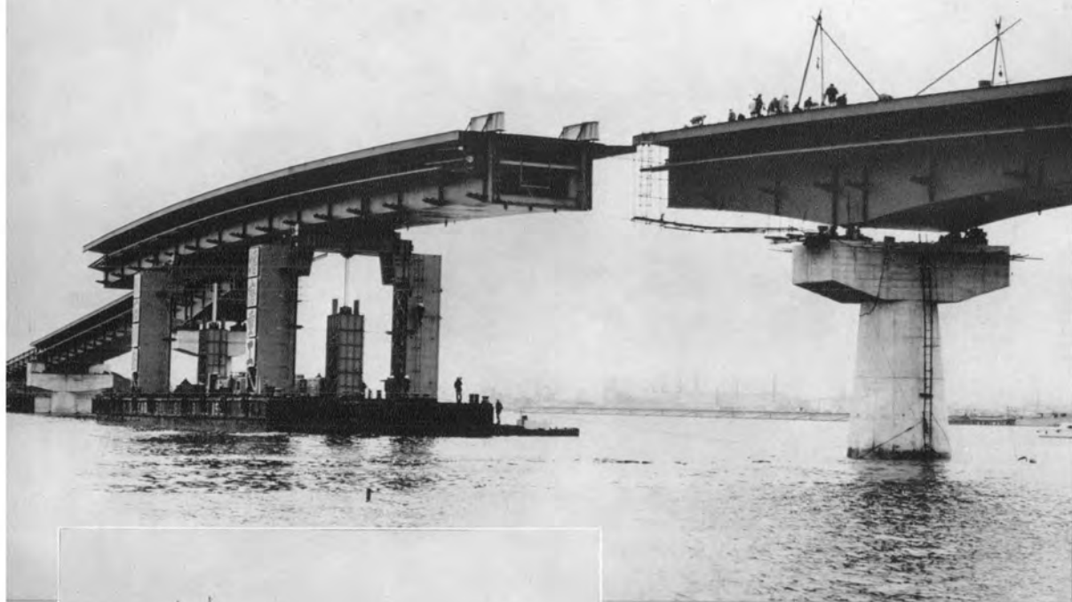
▲リフトアップバージによる中央径間の架設
