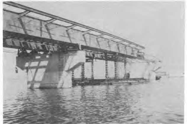
↑ 写真-4 手延機、台船による2箱けた同時送出し架設
