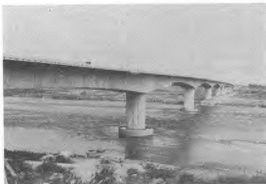
写真-3 主げた本体の完成(右岸より左岸を望む)
