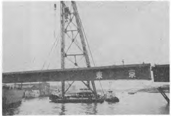
写真-2 フローティングクレーンによる大ブロック箱げたの直つり架設
