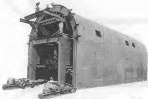
導水路トンネル用全断スチールフォーム
