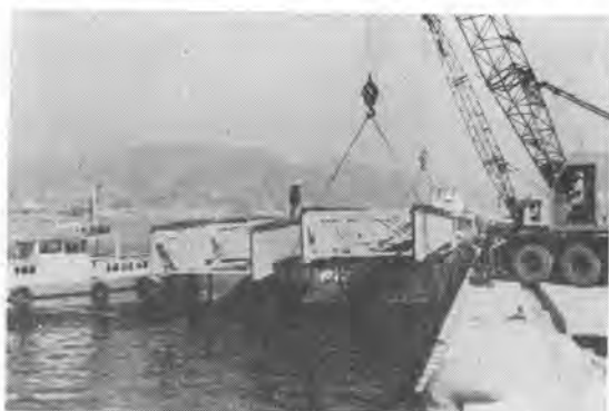
写真-2 台船への積み込み
