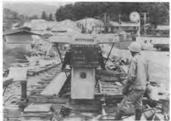
写真-1 けたの横取り
