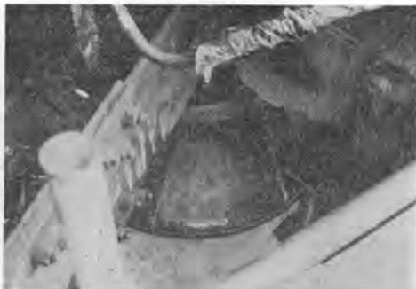
↑ 写真-14 本設柱とトラスの定着部
