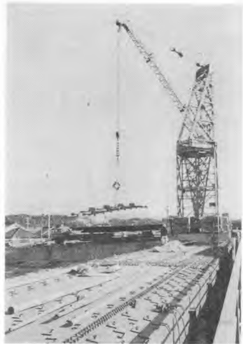
写真-1 タワークレーンによる架設状況
