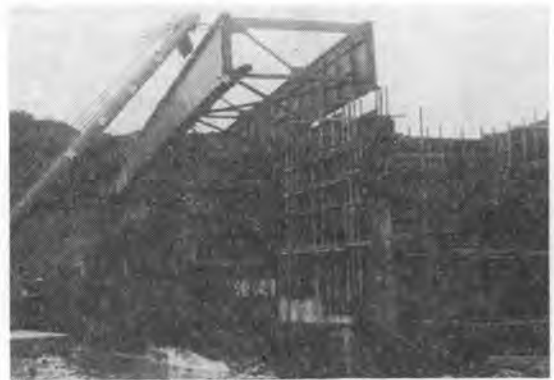
写真-4 架設位置に接近
