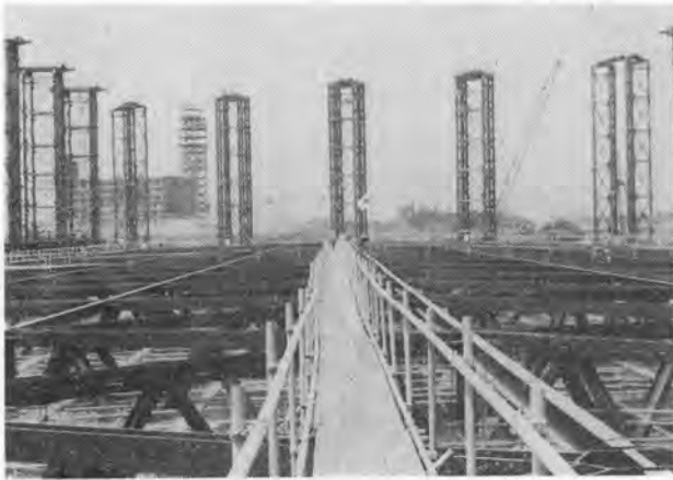
← 写真-1 地組みされたトラス
