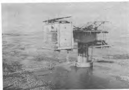
写真-1 架設作業車2基目組立中(材料運搬およびワーゲンの組立はすべて2.5tつりキャリヤで施工した)
