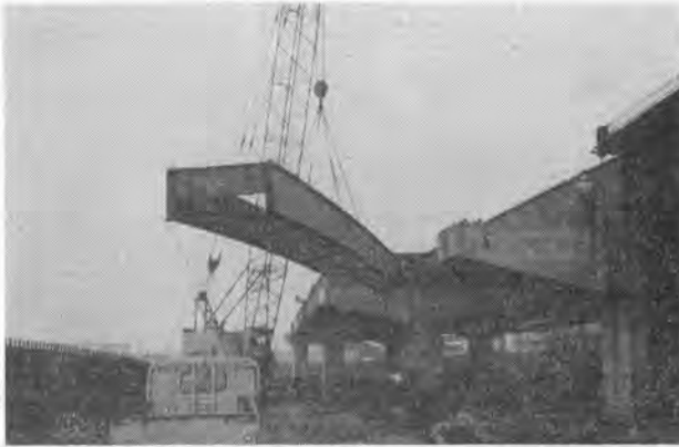
↑ 写真-1 60tつりトラッククレーンによる陸橋部鋼けたの架設
