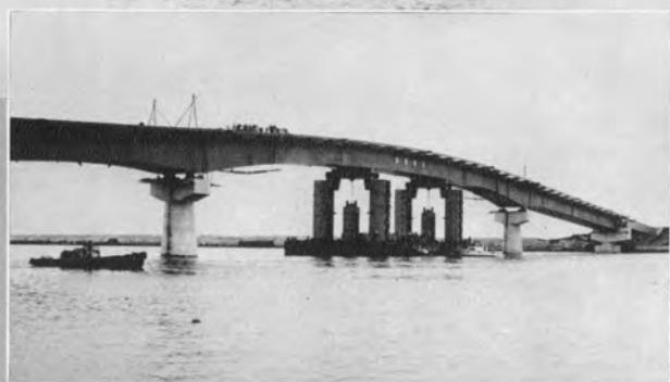
▲リフトアップバージによる中央径間の架設
