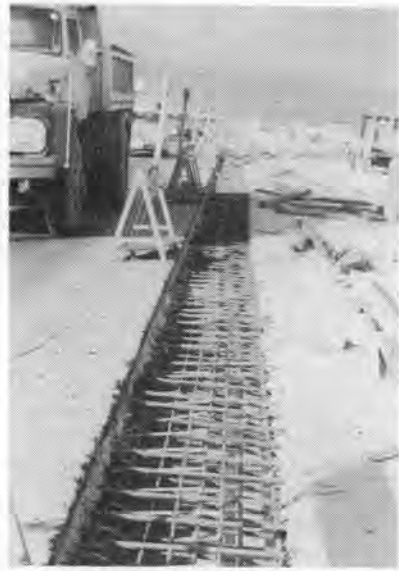
写真-4 床版打継部
