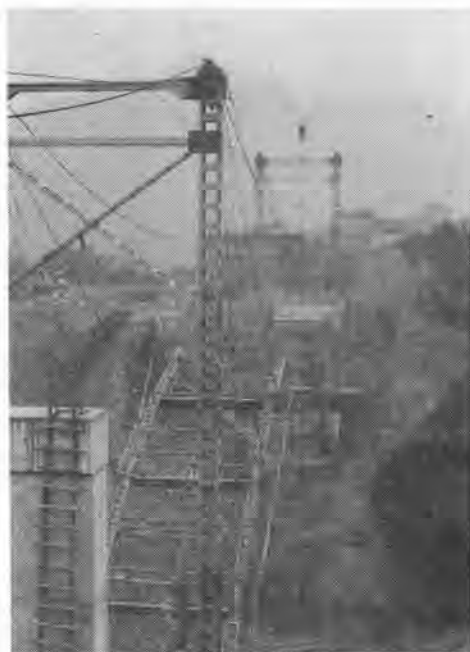
写真-2 アーチリブの架設
