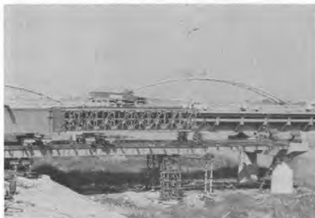
写真-2 けたの引出し（工事げたと手延機）
