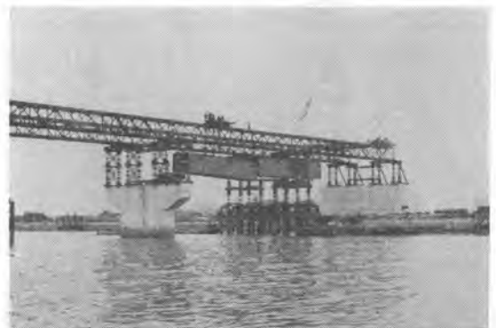
写真—5 架設トラスによるFげたのつり下げ架設
