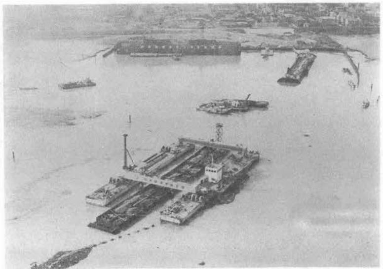
写真-3 京葉線羽田トンネルで使用した 双胴船形式の沈設作業船 (基礎のスクリード作業、く い打ちにも利用)
