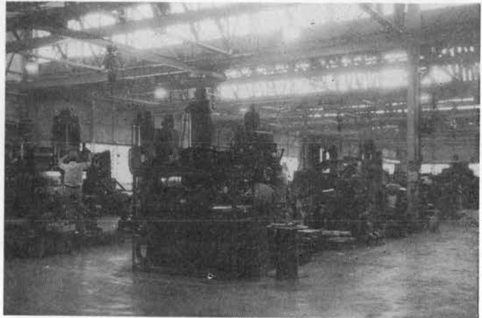
第2工場内機械工場
