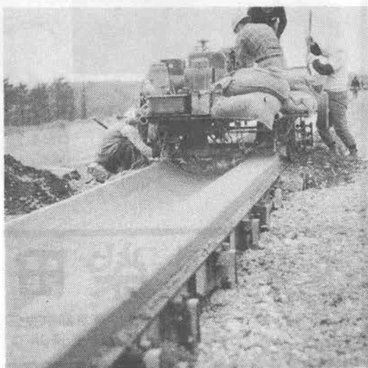
北海道縦貫道路作業現場 改造CM型
