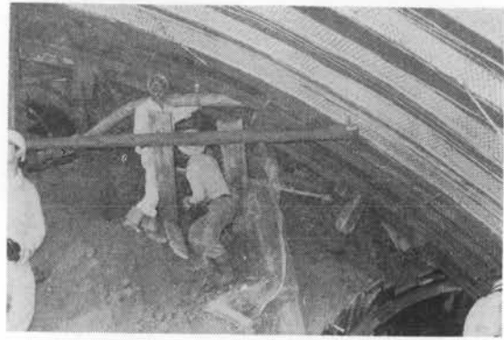
写真-8 宝塚トンネルアーチ部1次覆工
