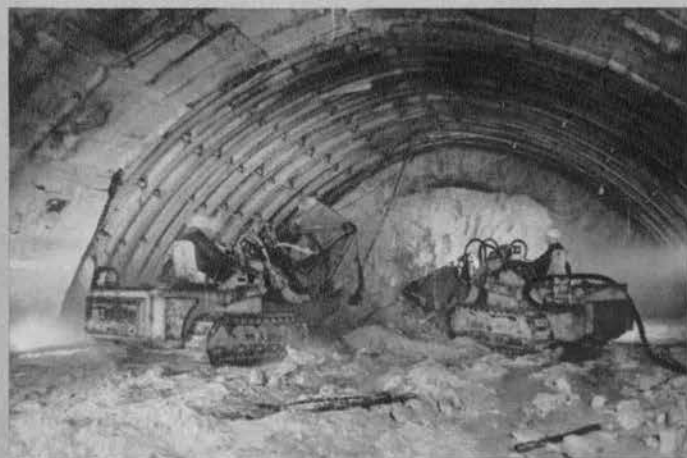
◀サイドダンブローダME642Hの 上半部分での稼働状況 —六甲トンネル北山工区—
