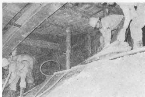
↑写真-6 宝塚トンネルアーチ部縫下り
