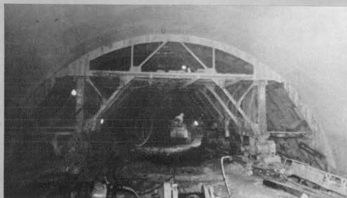
▲上半用スチールフォーム —六甲トンネル甲陽工区—
