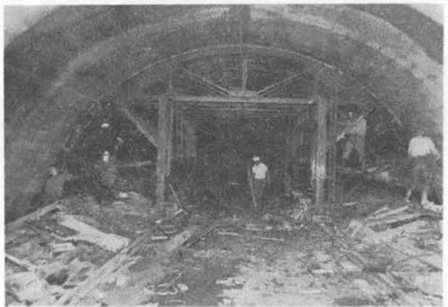
写真-2 早期覆工をめざす上半1次巻移動式セントル
