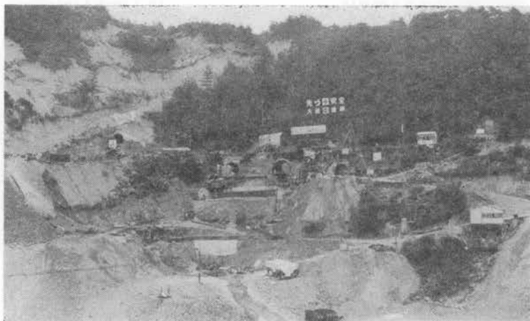
写真—1 宝塚トンネル導坑掘削時全景
