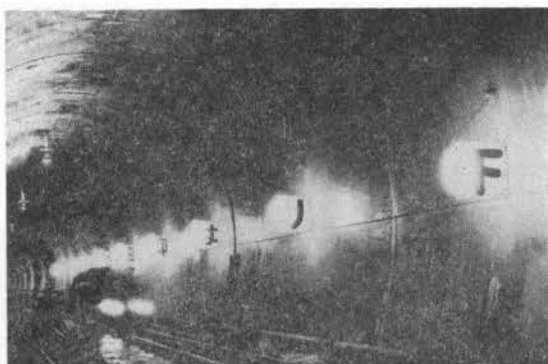
写真-6 中津川方本坑全巻コンクリートの安全標識
