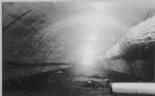
▲上半覆工部分と換気用パイプ —神戸トンネル—
