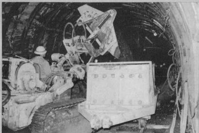
◀サイドダンプローダによるずり積み —新関門トンネル火の山斜坑—
