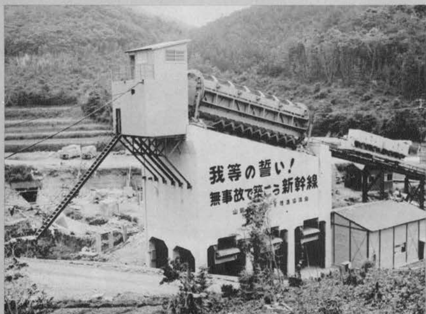
▲斜坑チップラおよびずりピン —藤ヶ谷トンネル—
