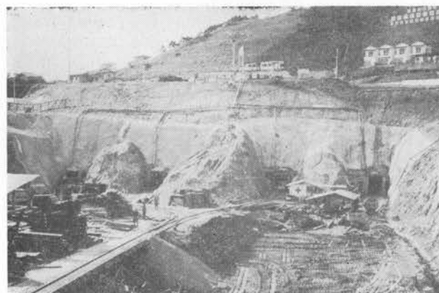
↓写真-3 米谷トンネル導坑下段掘削全景
