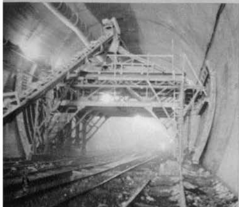
▼側壁用メタルフォーム —帆坂トンネル—
