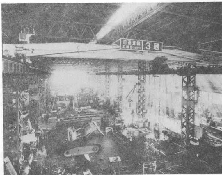
除雪装置ブローの 組立作業→
