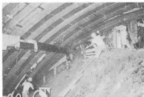
↑写真-7 宝塚トンネルアーチ支保工建込み
