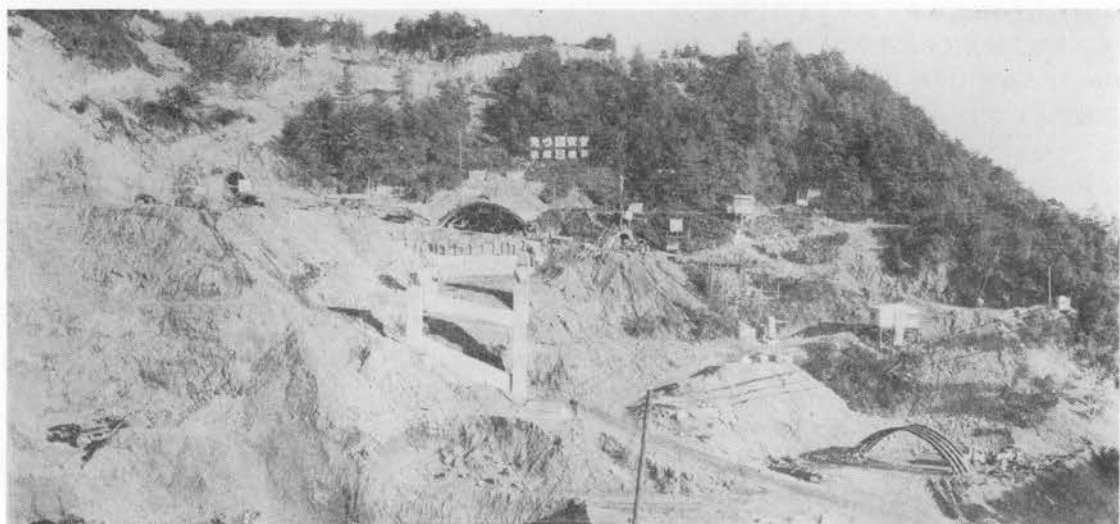
↑写真-2 宝塚トンネル下り線上部半断面および上り線導坑全景
