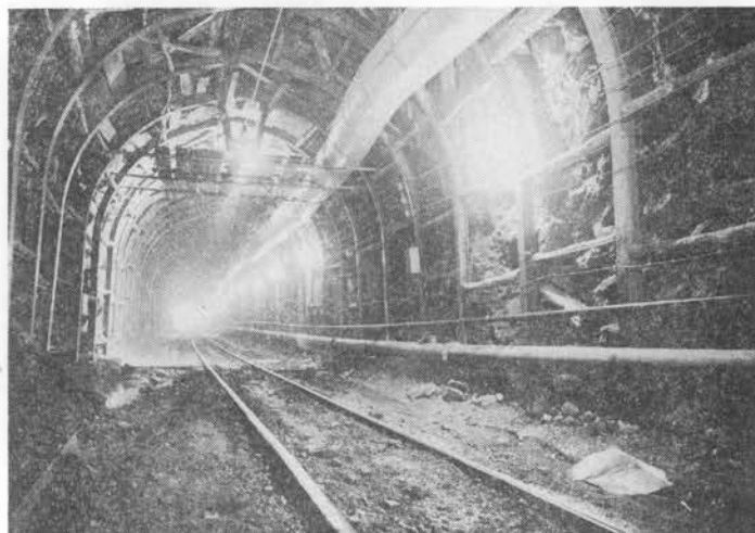
写真-1 全断面発破工法による掘削断面
