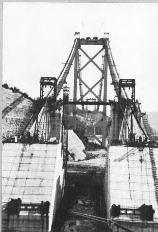
▼主ケーブルの架設をほぼ完了した つり橋の姿
