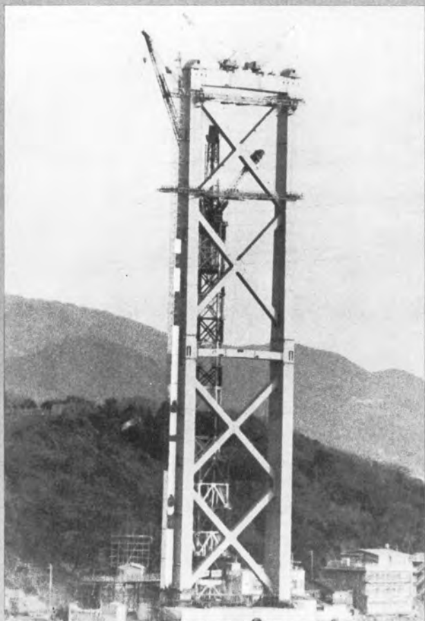
▲架設が完了した門司側塔
