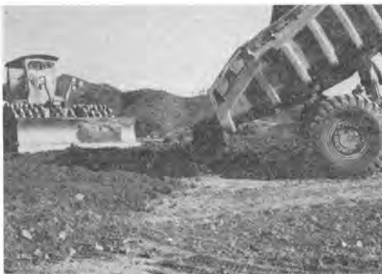
写真-2 35t ダンプとシープスフート
