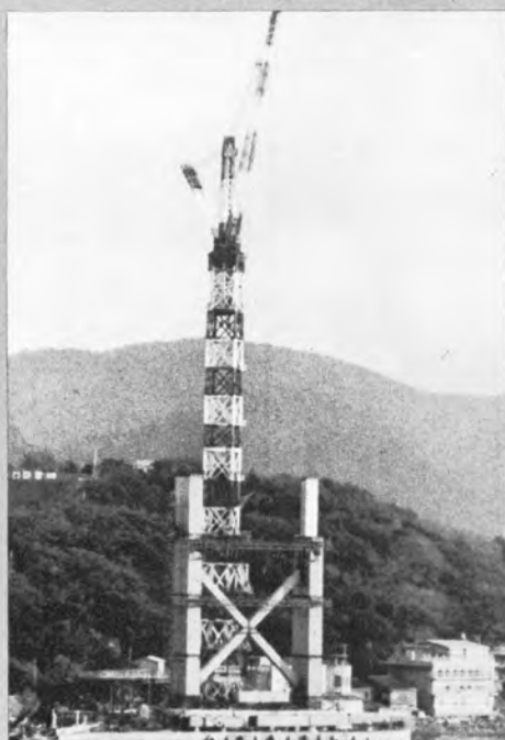
▲門司側塔柱の架設に用いられた タワークレーン
