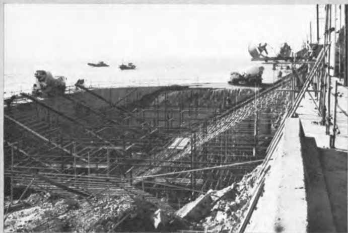
▲下関側橋脚コンクリートを打設中
