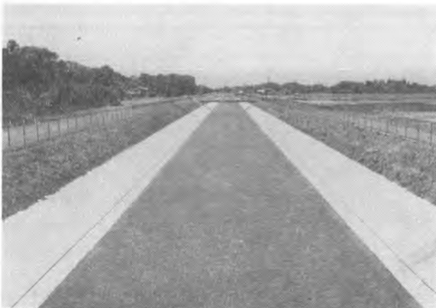
↑ 写真-7 多目的用水路・武蔵水路（昭和 43 年 8 月竣工）
