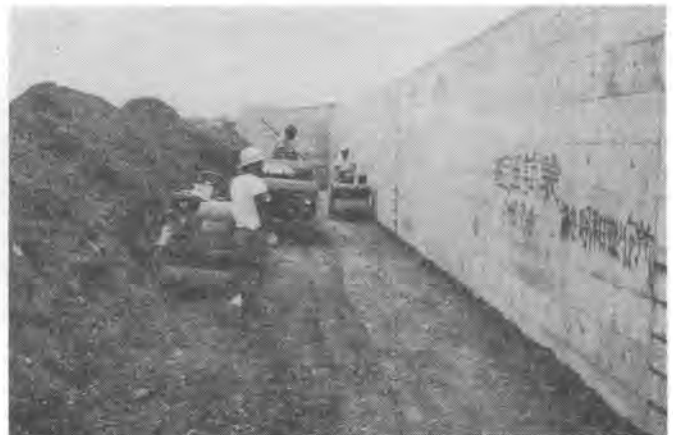
写真-6 裏込部で使用される振動ローラ
