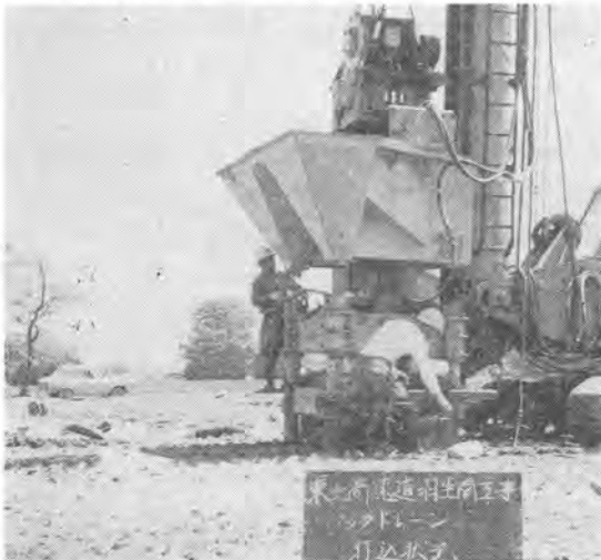
写真-7 (B) D 207 LC によるバックドレーン打込み
