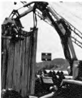
●ポストホールの掘削
