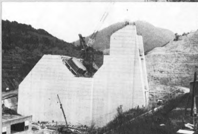
▼門司側橋台コンクリートの打設を ほぼ完了したところ
