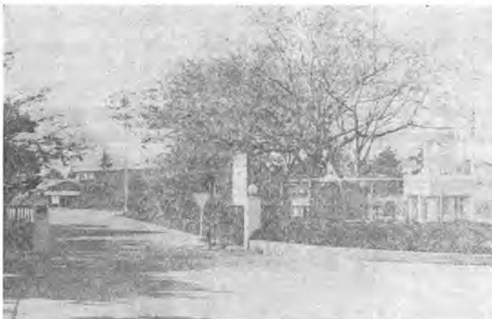
土木研究所千葉支所正門
