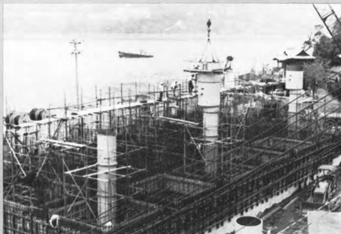
▲門司側橋脚基礎の空気ケーソン
