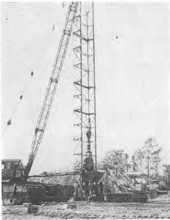
写真-7 (A) NQ 800 によるバックドレーン打込み
