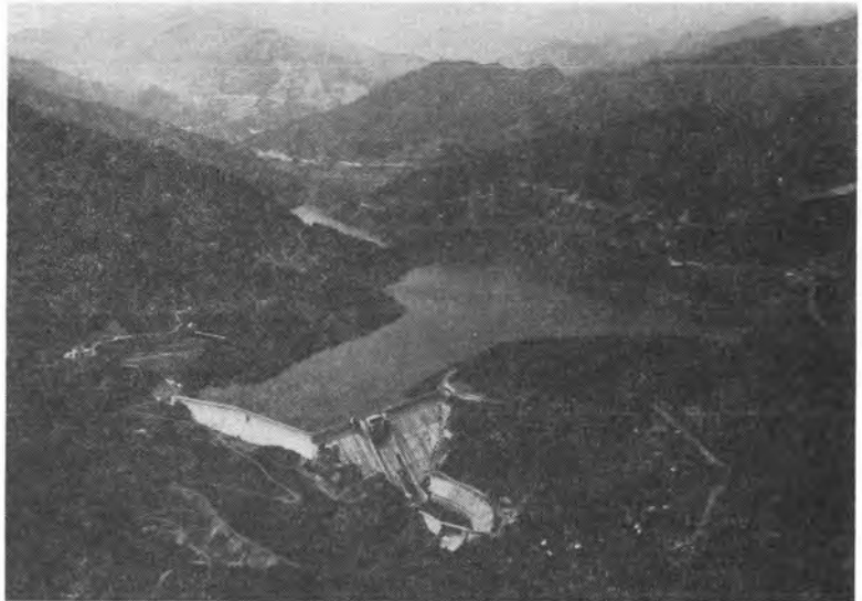
→ 写真-3 下久保ダム (昭和 43 年 11 月竣工)
