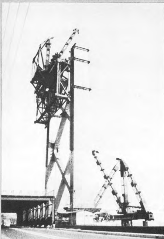
▼下関側塔柱の架設に用いられた クリーンクレーン
