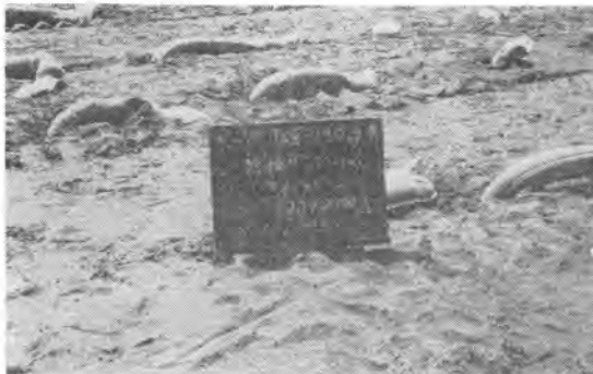
写真-7 (C) バックドレーン打込後の状況
