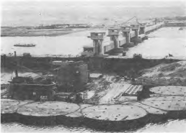
写真-12 第3ブロック工事施工状況（昭和43年10月）
