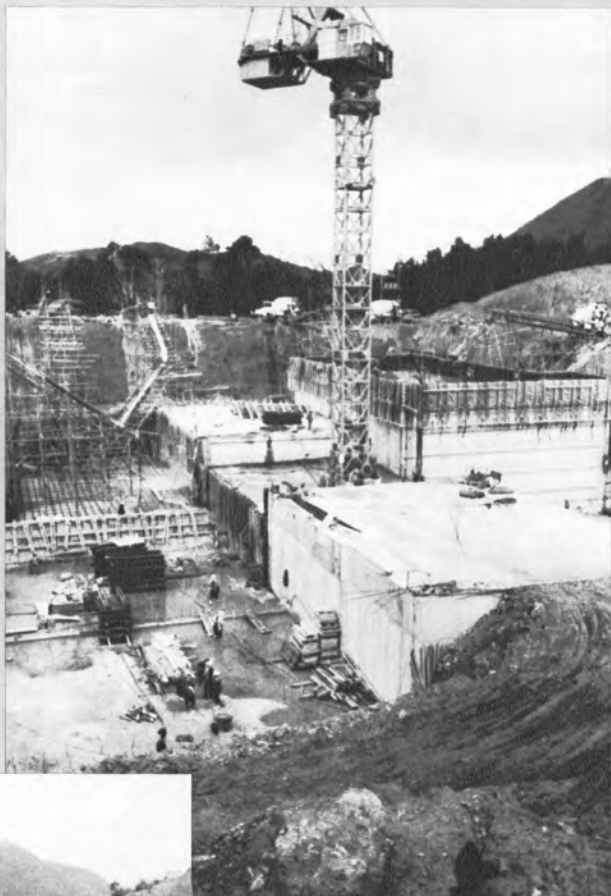
▶門司側橋台コンクリートを打設中
