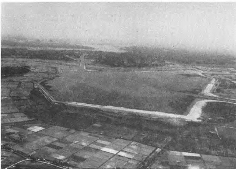
← 写真-4 印旛沼開発北部調整池 (昭和 44 年 3 月竣工)
