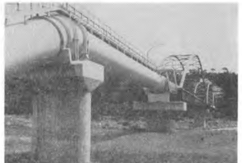
↑ 写真-8 専用水路・群馬水利根川 サイフォン水管橋（昭和 44 年 6 月竣工）
