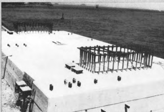
▲完成した門司側橋脚で、この上に塔柱が建てられる
