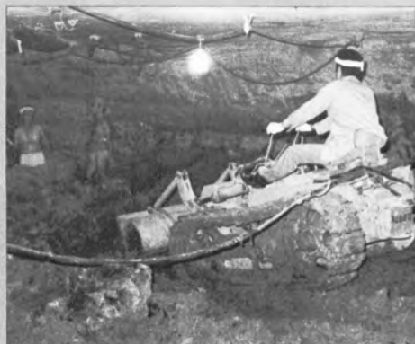
▲門司側橋脚基礎の空気ケーソン内 で活躍する電動式トラクショベル
