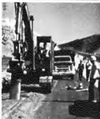
●能率良くトレンチシートを打込み
