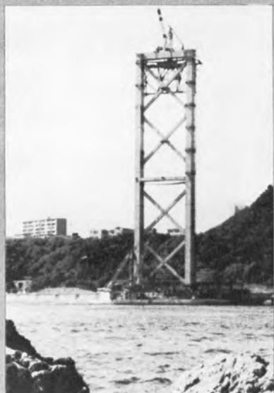
▼架設が完了した下関側塔
