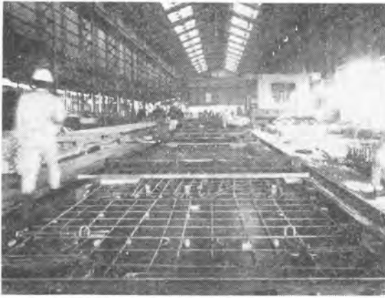
写真-1 型わく、配筋、埋込金物等のセット
