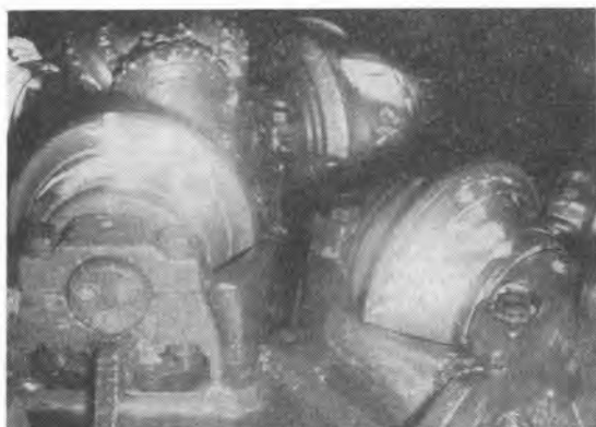
写真-2 トリコンカッタ, センターカッタ, およびディスクカッタの取付状況
