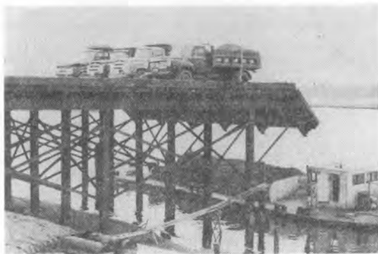
写真-4 置砂積込用仮設棧橋
