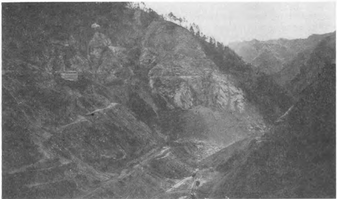
写真-2 ダム掘削状況
