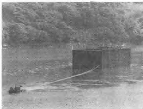
写真-8 沈埋函えい航状況
