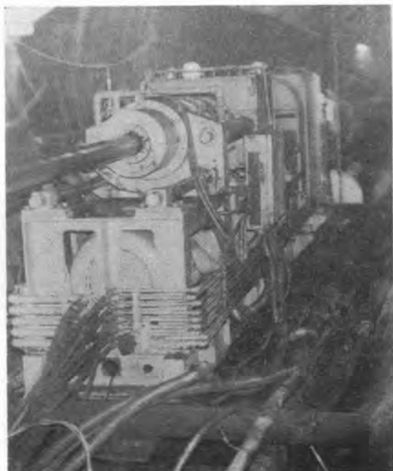
写真-3 水平ボーリング“ボアロック”
