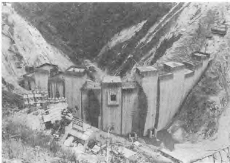
写真-1 工事中のダム全景
