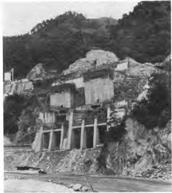
写真-4 工事中の取水口
