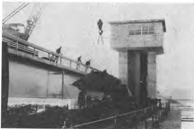
↑ 写真-9 No. 1 号調節 2 段ゲートの水中ステージングによる組立、据付状況
