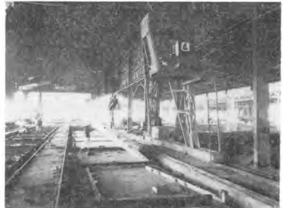
写真-4 PC板のつり起こし作業
