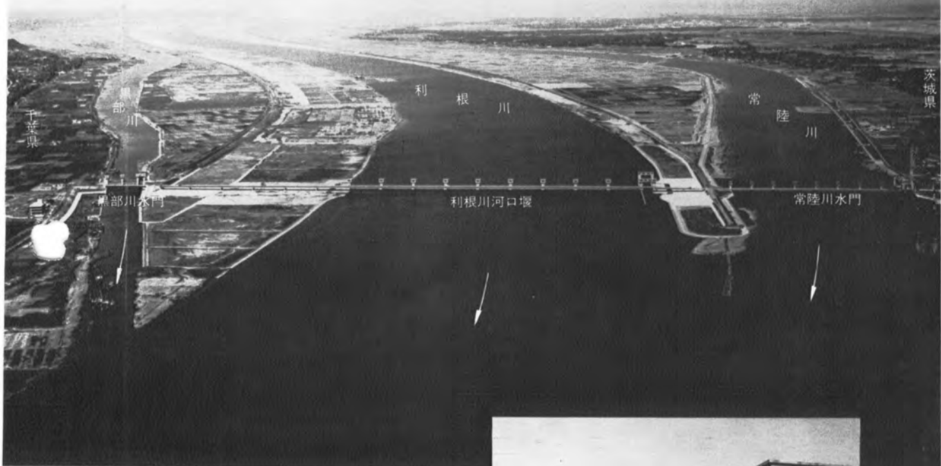
▲完成した利根川河口堰
