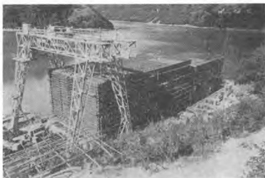
写真-7 沈埋函製作状況
