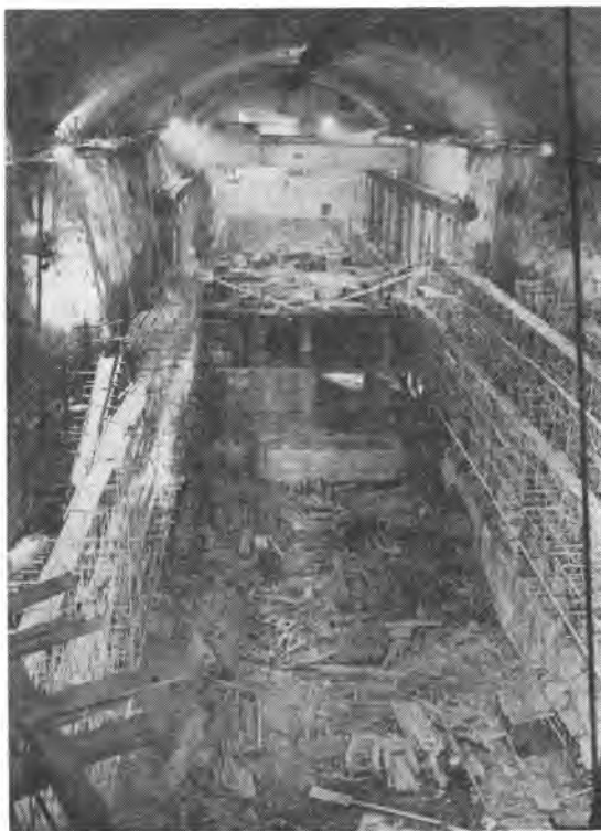
写真-6 発電所掘削状況
