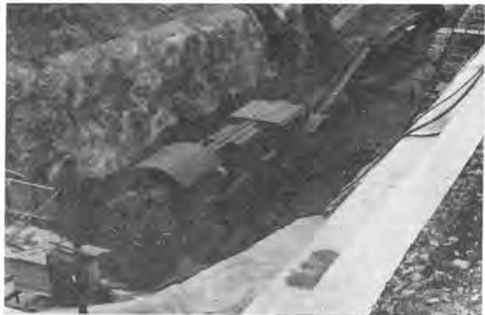
写真-1 TM 430 G 坑口組立完了全景
