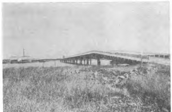
写真-5 工所用仮橋
