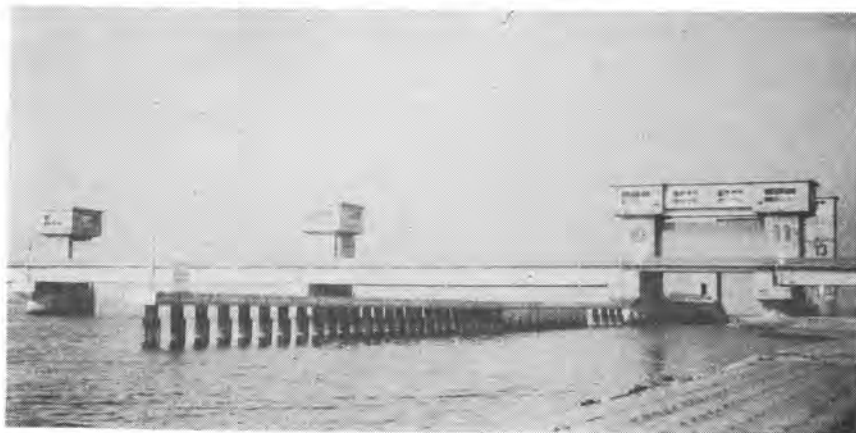
← 写真-10 下流側より開門を望む (手前は導流堤)
