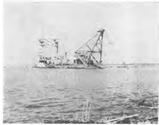
写真-2 稼働中の 2,000 PS サンドポンプ船
