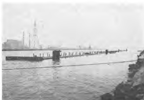
写真-4 係留地で養生中の沈埋函
