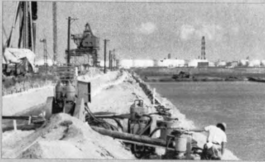
▲ウェルポイント排水路設置状況
