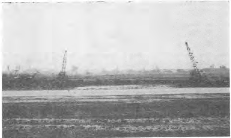
写真-2 ドラグラインによる掘削
