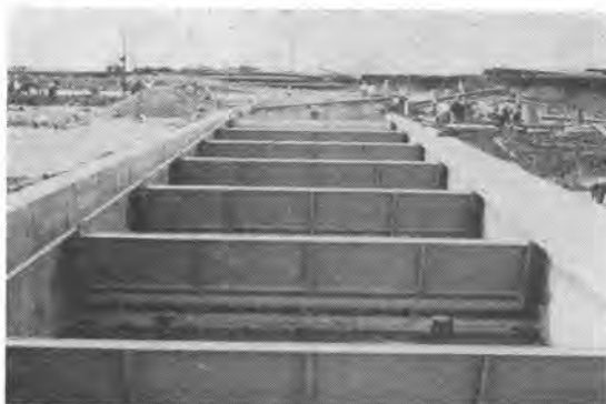
写真-13 据付けられた魚道隔壁フラップゲート
