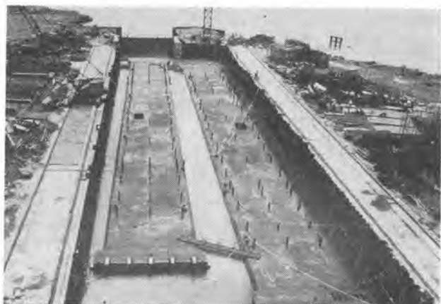
写真-3 ドライドック内で完成注水された沈埋函
