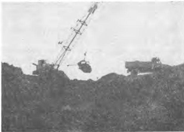
写真-3 ドラグラインで掘削し、ダンプで運搬
