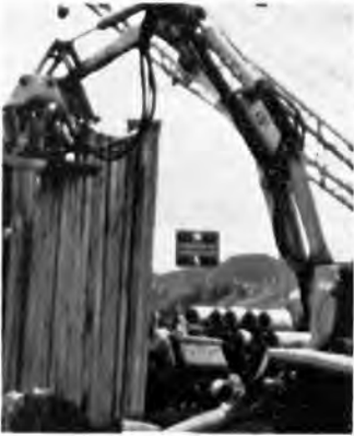
●ポストホールの掘削
