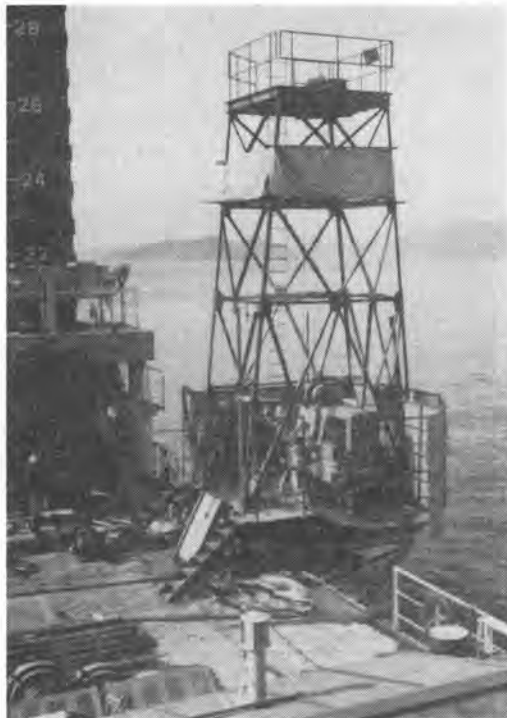
写真-2 掘削やぐらと掘削機
