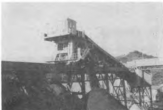
写真-4 トリッパとストックパイル
