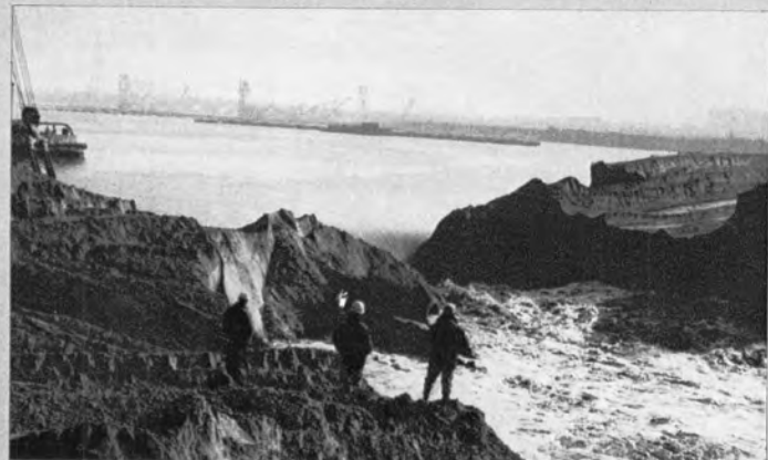
▶築堤切り状況
