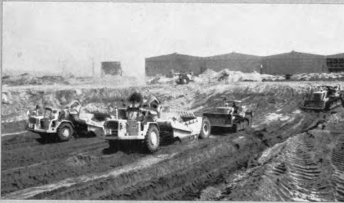
◀モータスクレーバとプッシュブル による掘削
