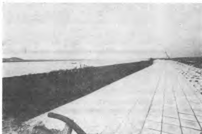
写真-12 鋼管矢板仮締切り水中切断撤去直前の低水護岸工
