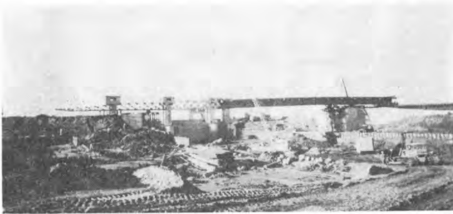
写真-15 手延べ工法によるけた架設状況
