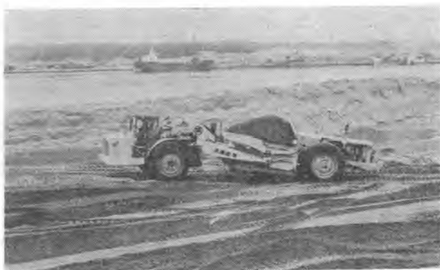
写真-3 モータスクレーパによる土砂運搬
