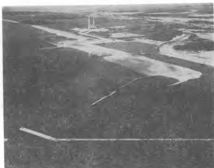
写真—2 施工時全景（昭和 46 年 5 月）
