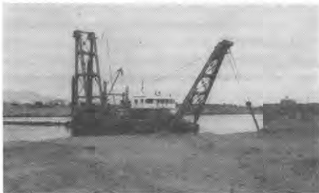
写真-6 ポンプ船による浚渫
