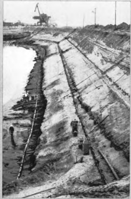
▲ウェルポイント布設状況
