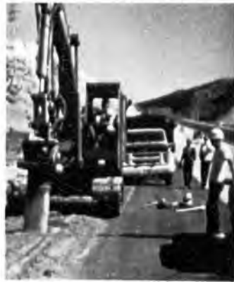
●能率良くトレンチシートを打込み
