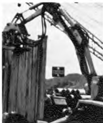
●ポストホールの掘削
