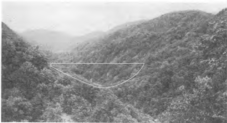
写真-2 二居ダム（上流側より）
