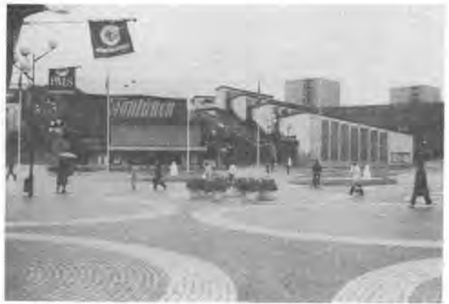
写真-9 ストックホルム近辺の新市街地 Vällingby (自動車交通からの分離)
