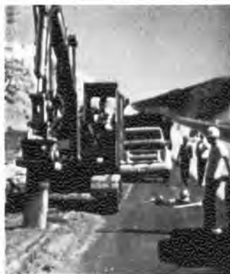
●能率良くトレンチシートを打込み
