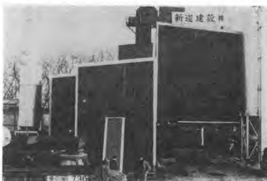
写真-4 公害対策アスファルトプラント "TSAP 1000 FAV"
