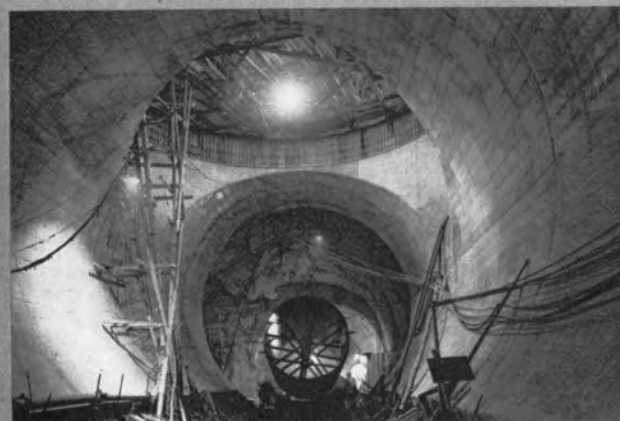
▲ 2号導水路調圧水槽接合部
