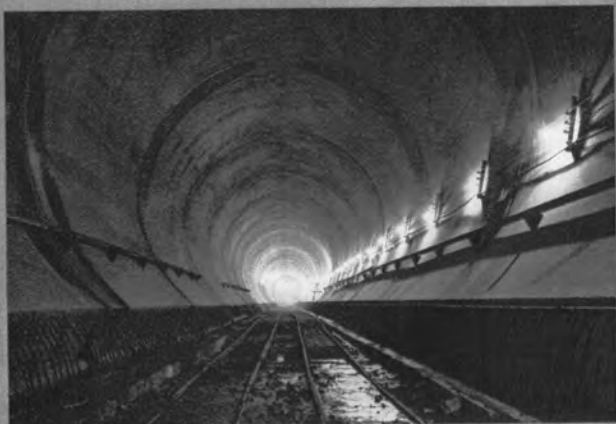
◀ 2号導水路トンネル(内径9.30m)下口の コンクリート巻立
