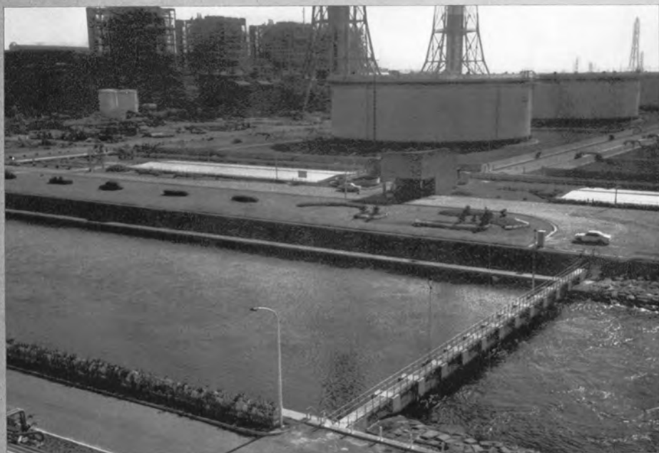
▼復水器冷却用水路
