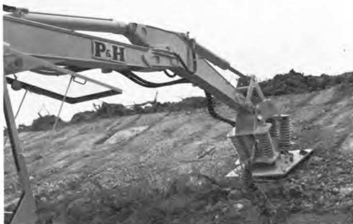
●能率良くトレンチシートを打込み
