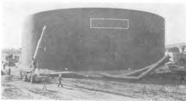
エアクッションによる 500 t タンクの移動
