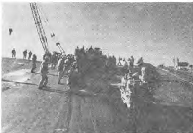
アスファルトフェーシングによるフィルダムのしゃ水壁工事
