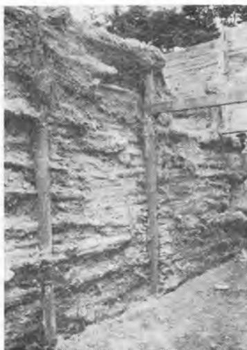
ジェットグラウト工法による地中壁
