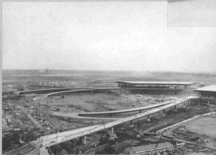
▲旅客ターミナルビルおよび駐車場
