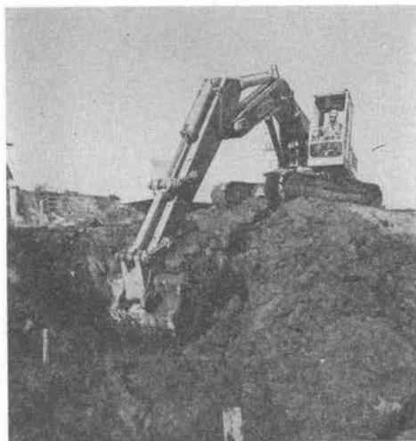
写真-1 ショベル系掘削機 (油圧式ショベル)
