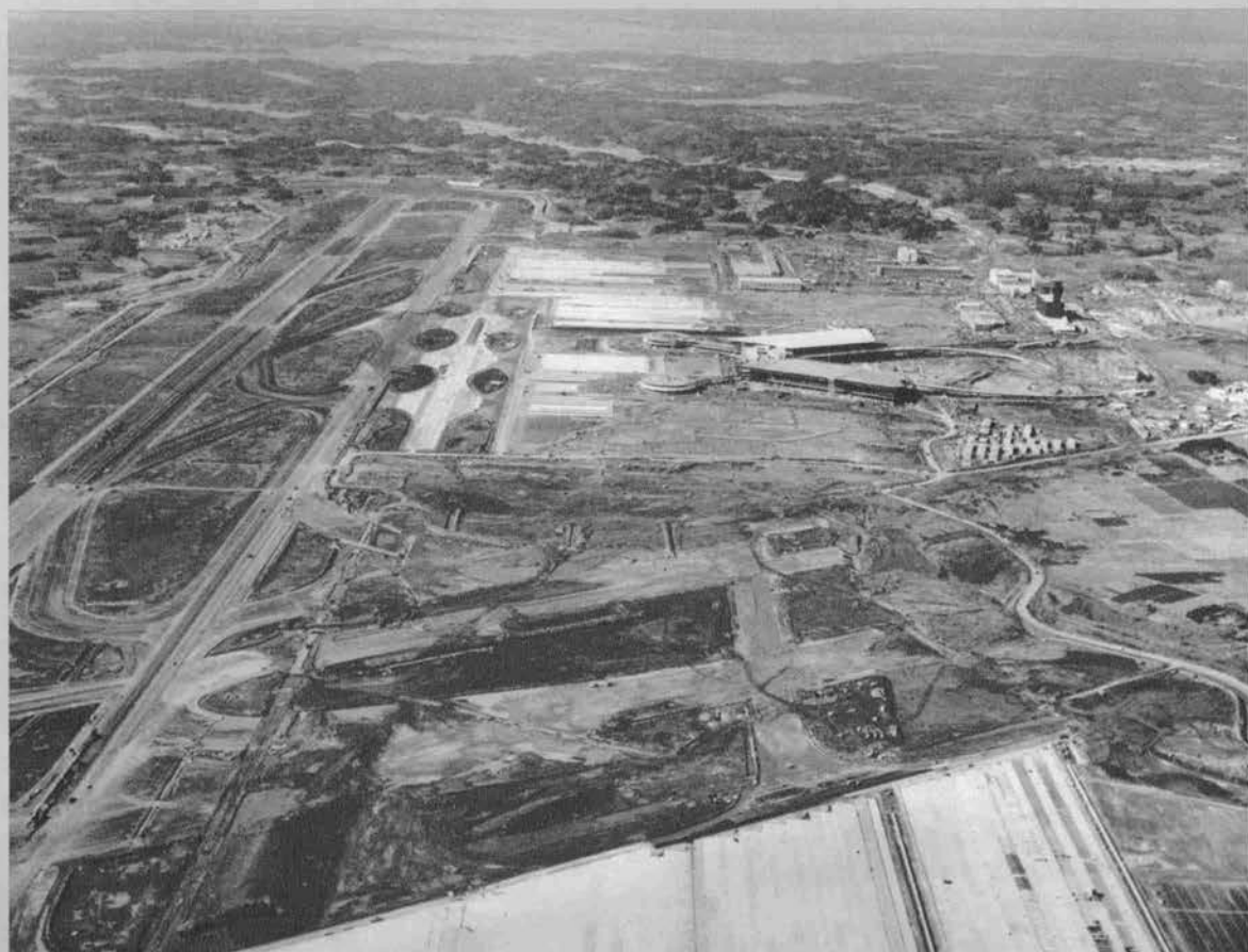
▲上空より見た新空港の建設状況
