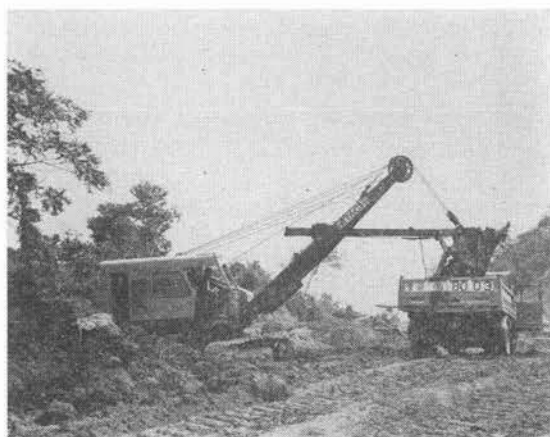
写真-2 ショベル系掘削機 (機械式ショベル)
