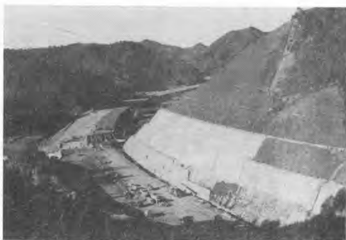
写真-1 STA 148+40 付近切土箇所
