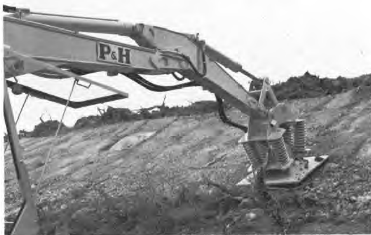
●能率良くトレンチシートを打込み
