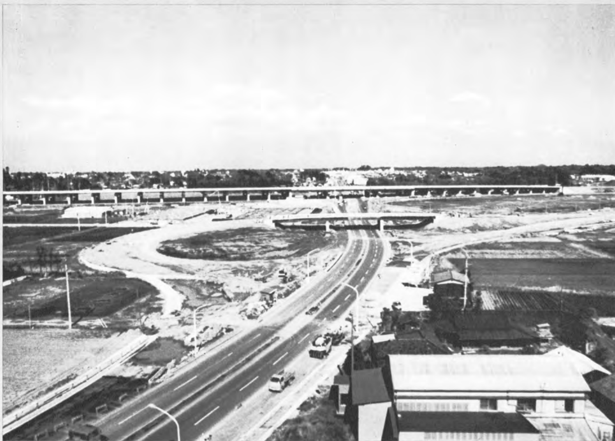
▲国道16号線より見た東北道への玄関口・岩槻インター（左側が仙台方向）
