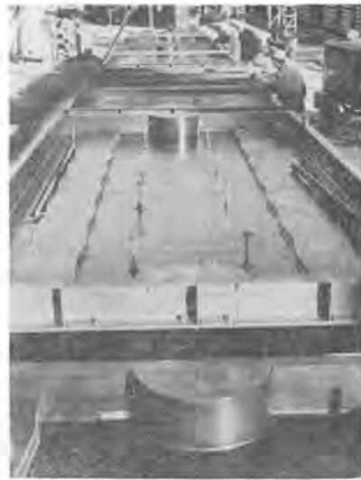
写真-2 軌道スラブの型わく
