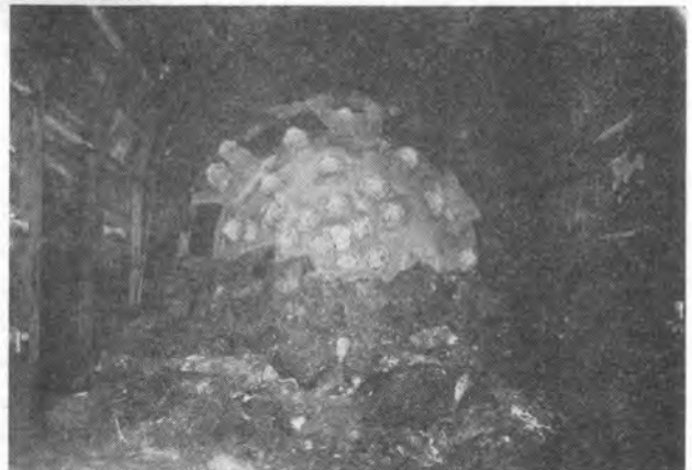
写真-10 貫通状況
