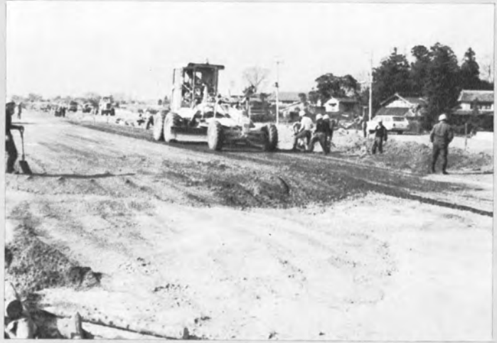
▲グレーダによるサブベースの施工
