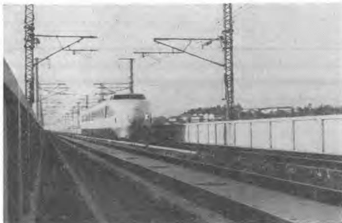
写真-1 完成したスラブ軌道上を走る新幹線試験車
