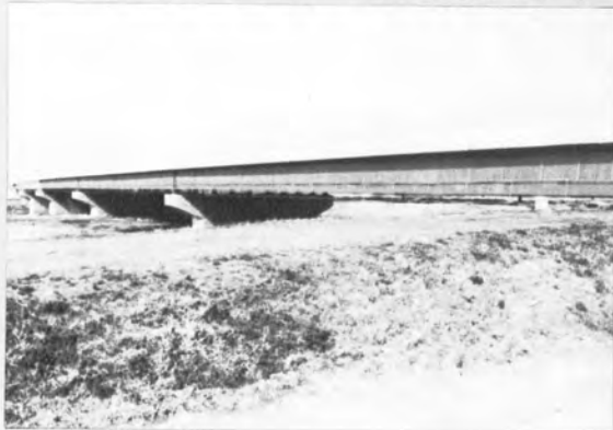
▼群馬、栃木の県境にかかる渡良瀬川橋
