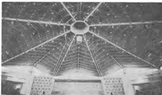
写真-2 大成トラス (長崎体育館)
