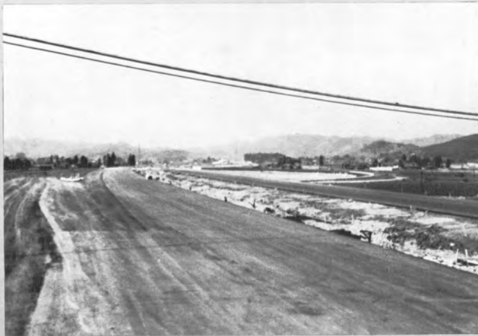
◀岩槻から栃木インターまでは交通量の 伸びに応じて6車線に拡幅する暫 定施工としているため開通当初は10m の中央分離帯となる。(鹿沼付近)
