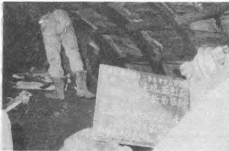
写真-9 上半手掘り工法
