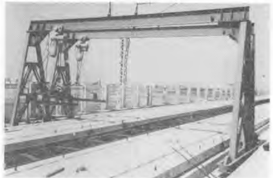
写真-3 高架上の簡易門形クレーン
