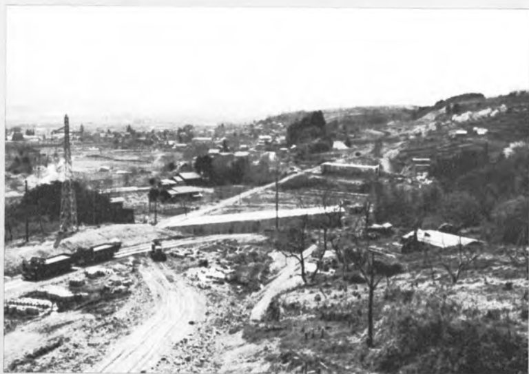
▲構造物先行方式による福島桑折地区工事
