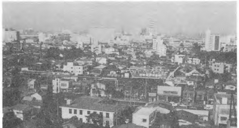
↑ 写真-8 カーブ変更区間の施工
