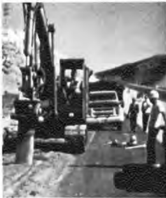
●能率良くトレンチシートを打込み
