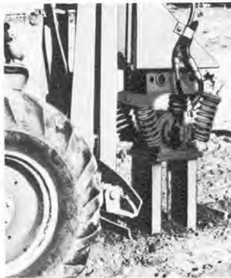
●狭い溝のつき固めができます。使用現場。ハイパック本体より巾の狭い溝用アタッチメントをつけての
