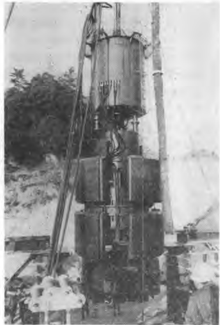
写真-2 ロータリ掘削機 (φ2.5~3.0m)
