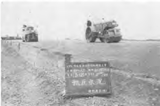
写真-2 サブベース工(転圧状況)
