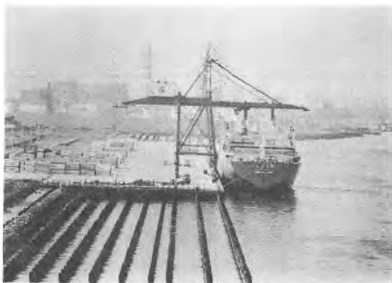
写真-1 大井ふ頭の現況
