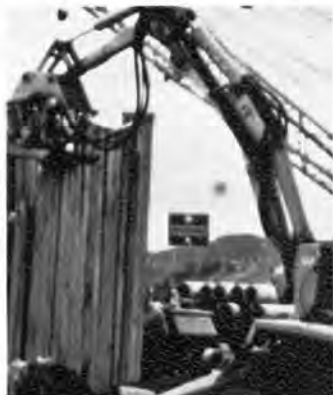
●ポストホールの掘削
