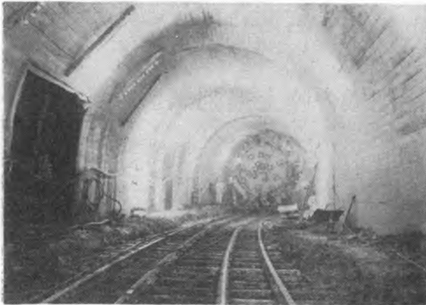
写真-7 引込み状況
