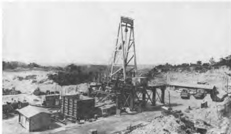
写真-1 陸上掘削試験場全景
