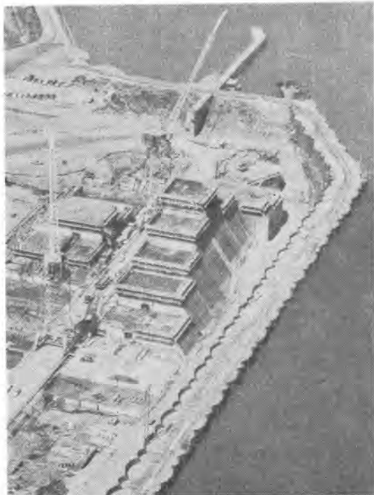
乾燥敷地を維持する囲いせきは砂利を満たした 15.3 m 径のセルからなっている
