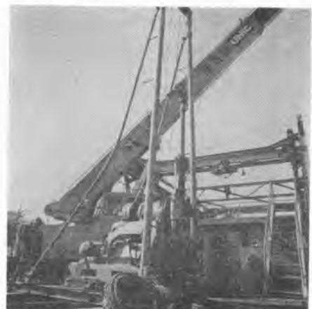
写真-3 大口径ボーリングマシン
