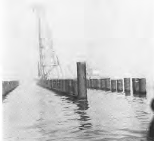
写真-3 くい打ち工事
