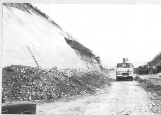
▲岩舟地区では6～7段もある大切土となるため、のり面对策ではPCアンカーによる岩盤定着を行なっている。
