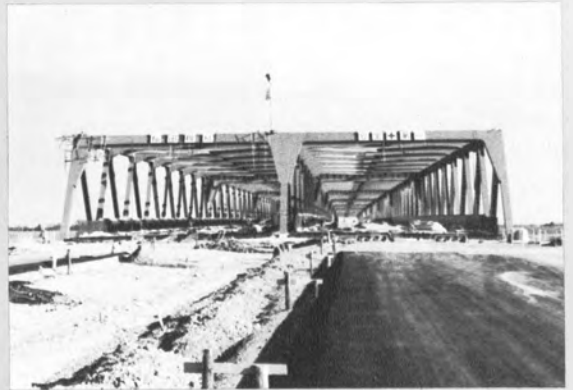
▲高速道路としては珍しい三主構 トラスの利根川橋 (群馬県側)
