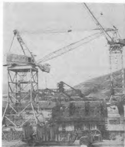
トラクタでけん引されたローボーイはコンクリートバケットを運搬してガントリークレーンに供給する
