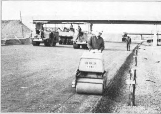
▲サブベースコースの施工（昭和47年11月供用開始を目標に本格的舗装工事に入った岩槻～宇都宮間）
