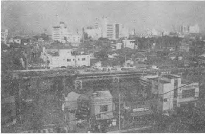
← 写真-4 上床コンクリート工 (北品川第5踏切付近)
