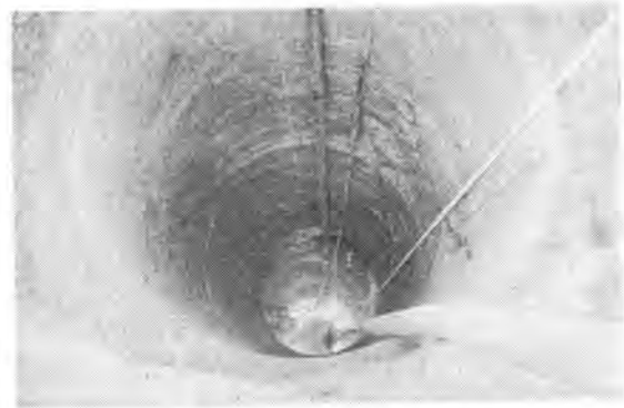
写真-3 孔内排水後の状況
