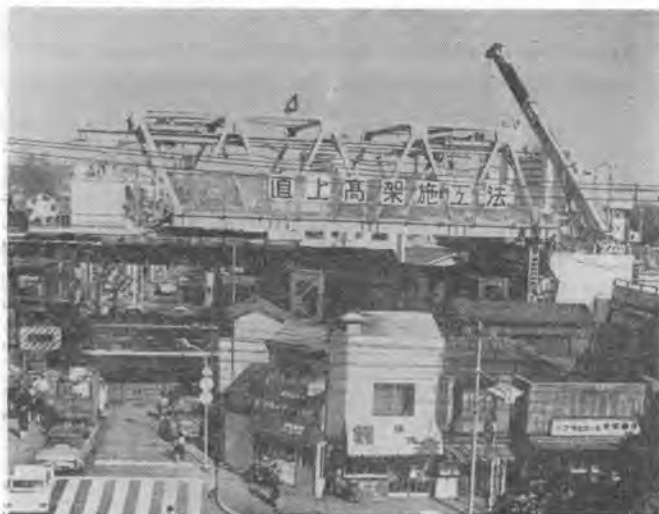
写真-2 運行中の電車直上で活躍中の施工機(北馬場駅付近)
