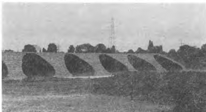
写真-6 コルゲートパイプによる氾濫防止対策
