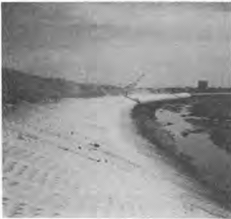
写真-9 チョークによる築堤工事
