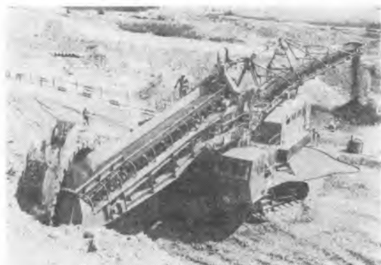
写真-2. バケットホイールエキスカベータ“KE-2000”
