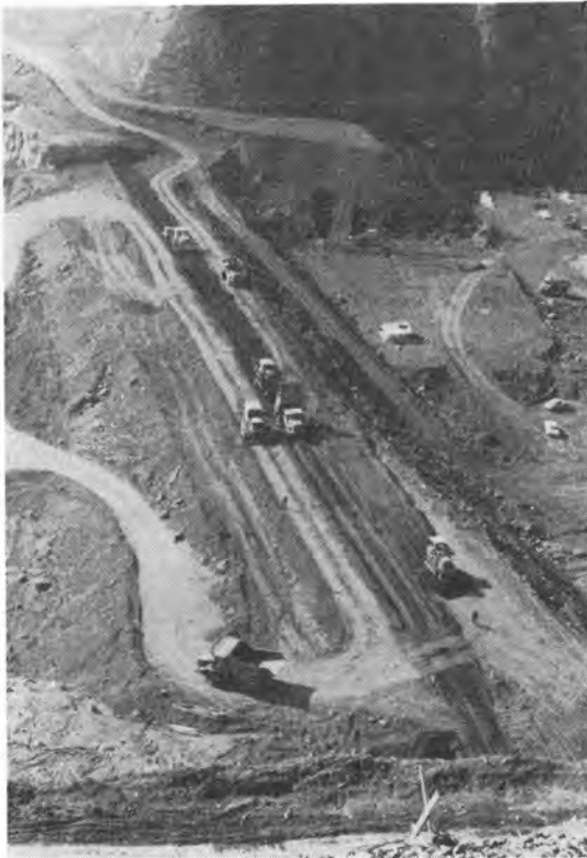
写真-1 2次締切盛土全景
