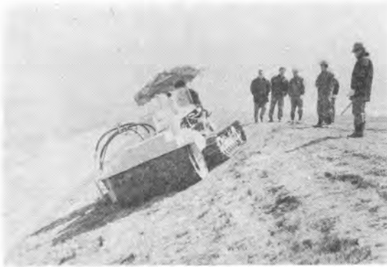
写真-11 締め装置
