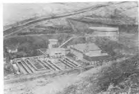
写真-6 1,200 m 3 /hr トンネル廃水処理装置
