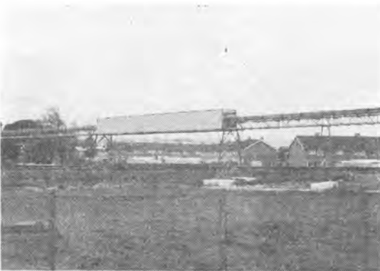
写真-11 長距離ベルトコンベヤの高架設備
