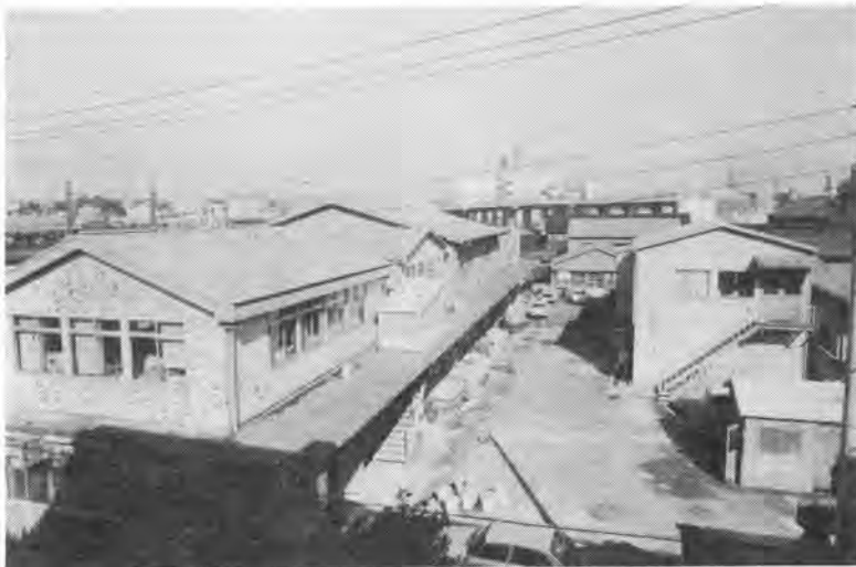
東京都土木技術研究所（本所）全景
