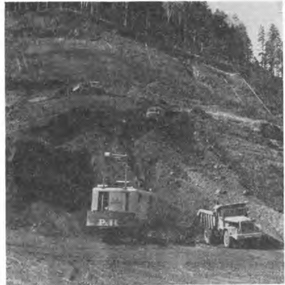
写真-2 原石積み込み状況
