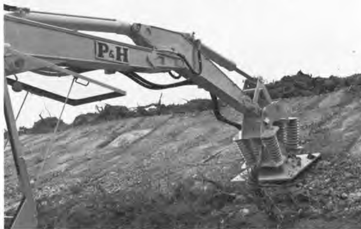
●能率良くトレンチシートを打込み
