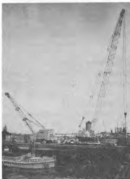
写真-5 リバースサーキュレーションドリルによる橋脚基礎ぐい施工
