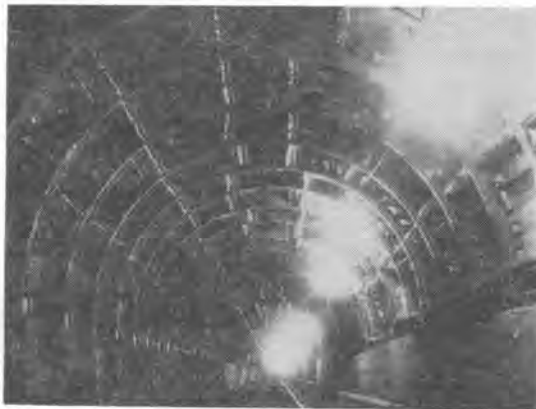
写真-14 メッセル工法によるトンネル掘削
