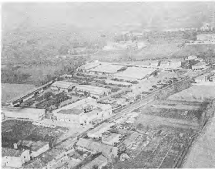
写真-14 シメサ工場全景
