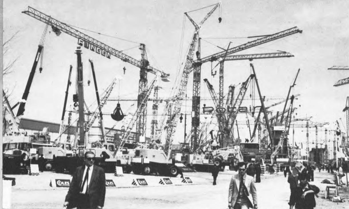
▲タワークレーン
