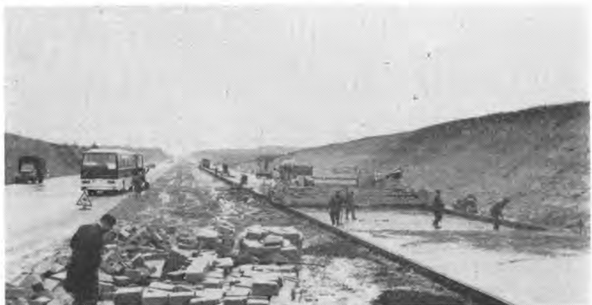
写真-4 → コンクリートフ ォイニッシャによる 舗装工事
