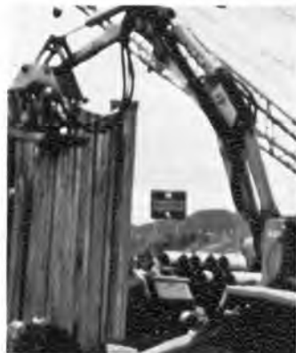
●ポストホールの掘削
