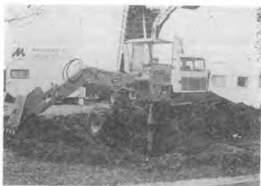
写真-8 Menzi 社の油圧ショベル
