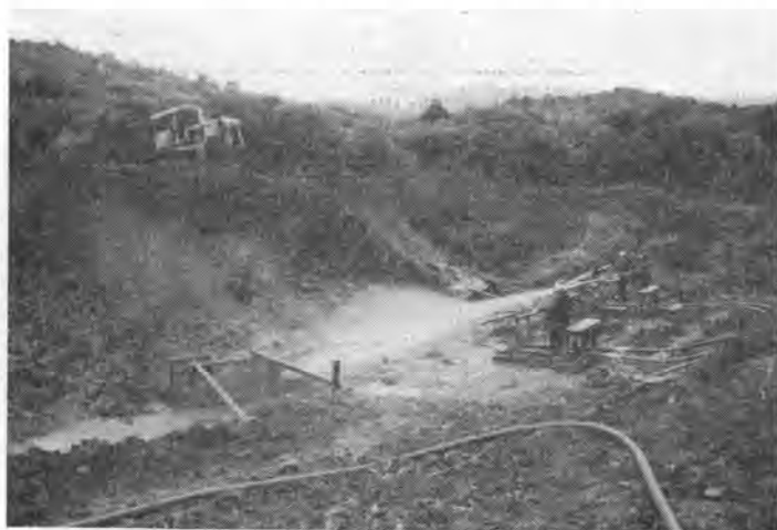
写真-2 ジェットモニターによる造泥作業
