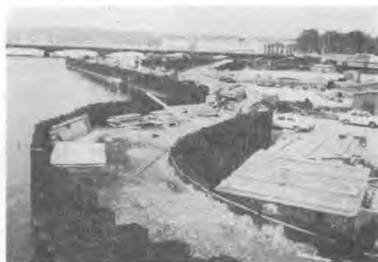
写真-13 レマン湖湖底駐車場の建設状況
