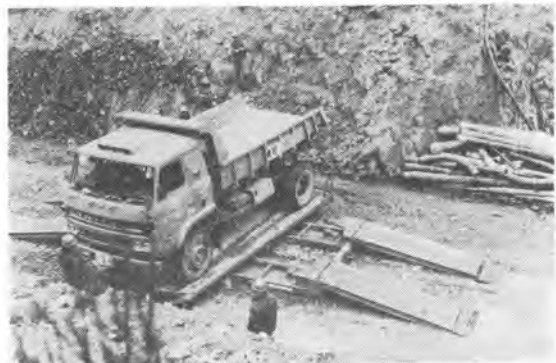
写真-7 ダンプトラック（トンネル専用）とターンテーブル
