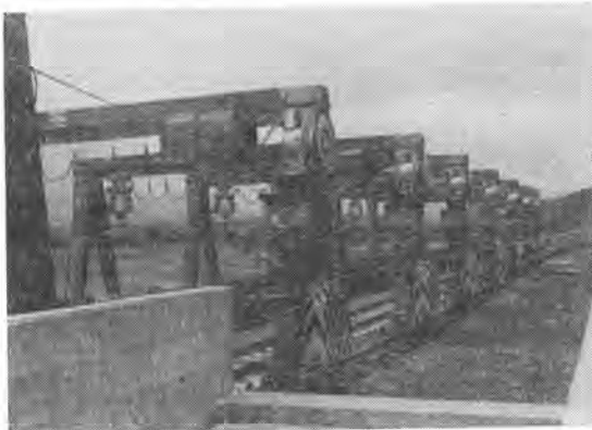
写真-9 軌道基地用連動式門形クレーン
