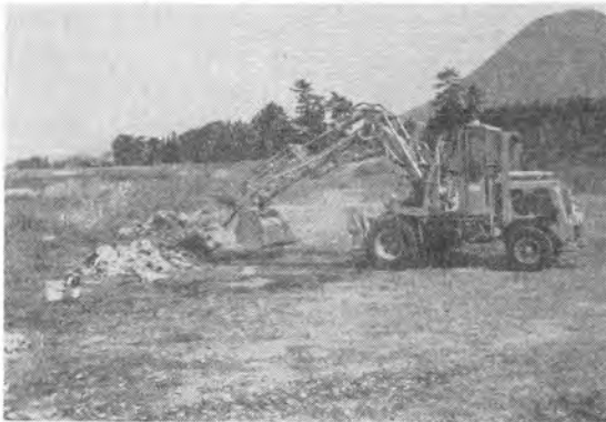
写真-12 藪芥処理装置付油圧ショベル
