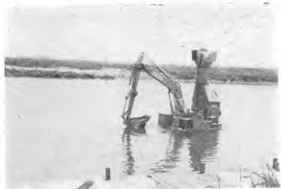
写真-2 作業中の水陸両用掘削機
