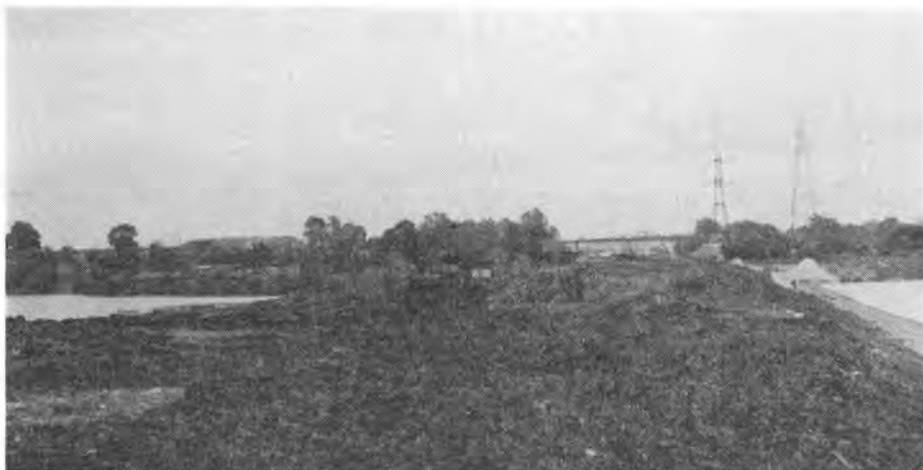
写真-5 ソープ付近の路盤造成工事
