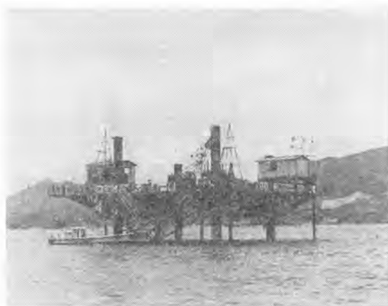
写真-1 海上作業足場“躍進一号”
