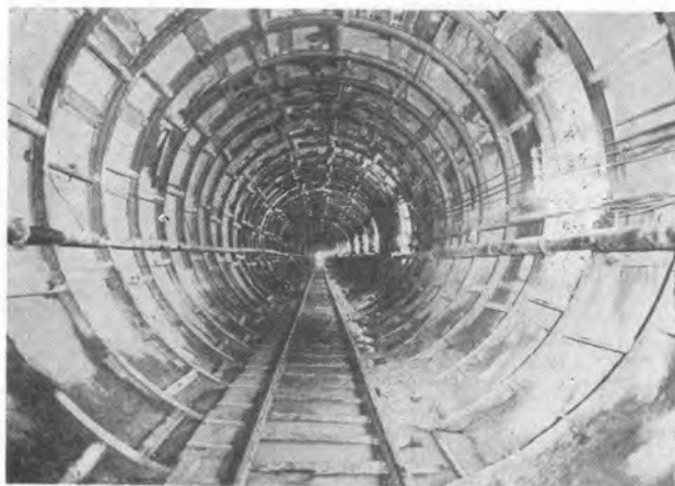
写真-5 T.B.M 施工による坑内
