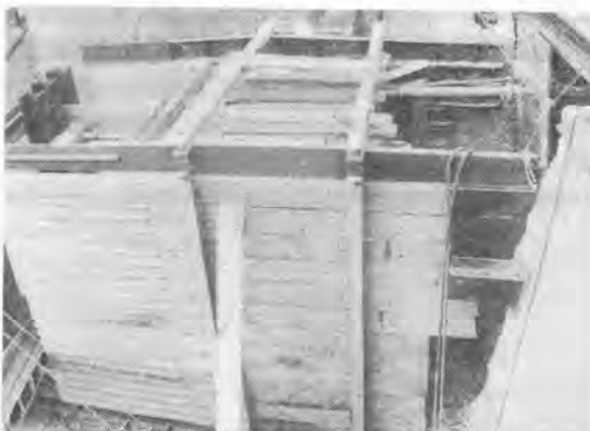
写真-4 スライディング・アーマ組立完了 (後方H鋼は発進基地)
