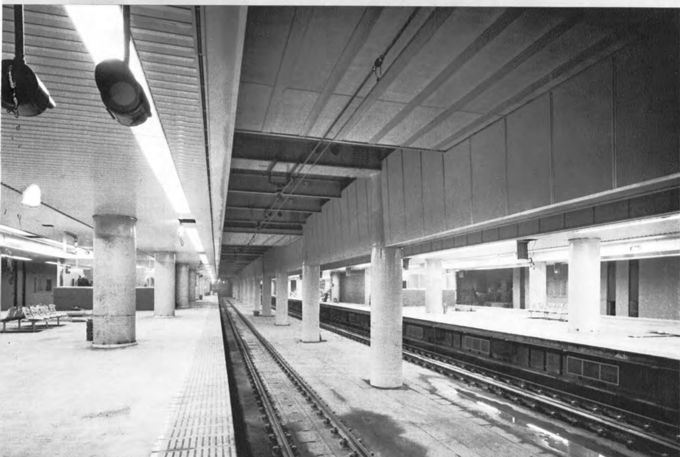
▲完成した地下駅ホーム
