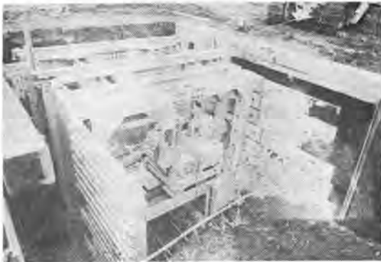
写真-3 後方よりみた実験中の掘削機
