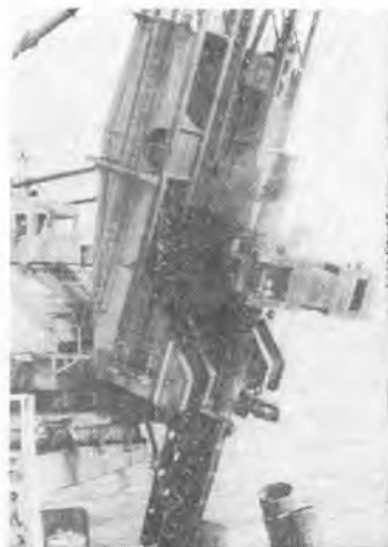
写真-2 ムアリングドルフィン No. 3 (φ1,219, l=62 m, 斜 20°) 打込み状況—昭和 47 年 4 月 25 日~27 日—
