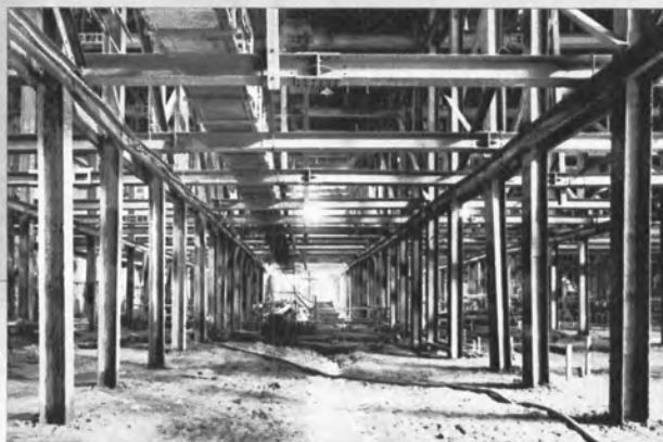
路面覆工を受ける中間ぐいおよび1次掘削が完了▶
