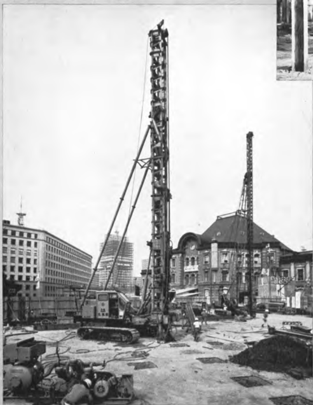
▼中間ぐいを打込むためのさく孔機
