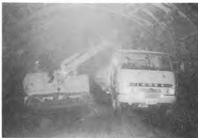
写真-1 ずり出し状況
