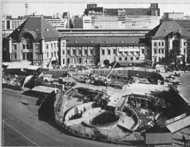
▲東京駅前広場中央では換気塔が施工されており、 周囲は車路となっている
