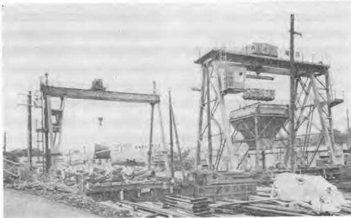
写真-4 坑外設備
