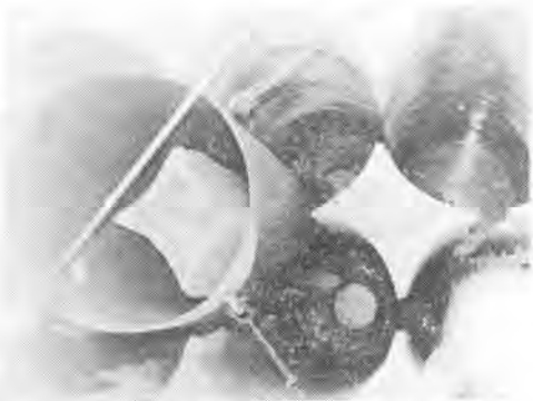
写真-5 菱形掘削におけるガイドケーシング設置の状況
