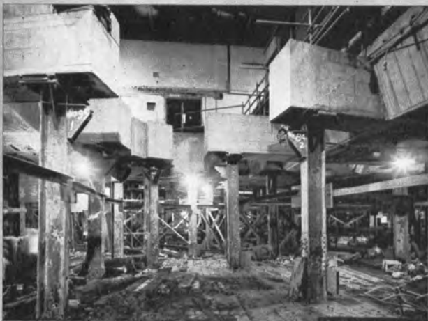
▼丸ノ内北口本屋（赤レンガのドーム）を仮受するためのH鋼ぐいおよび鉄筋コンクリートの横ばり
