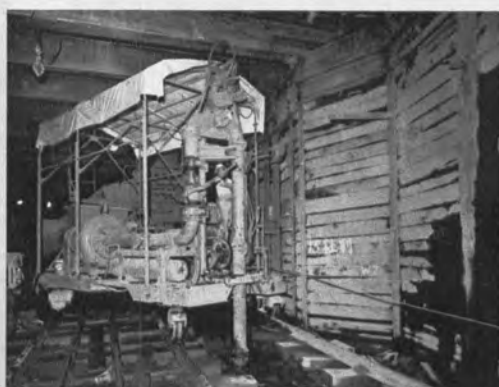
▲ソレタンシュ掘削機による連続地下壁の掘削
