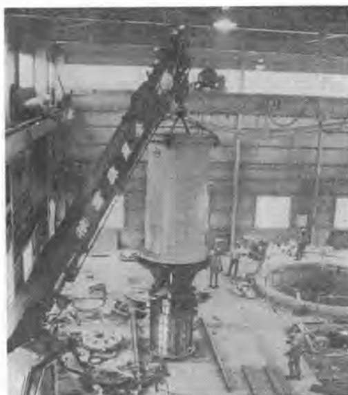
超大形三軸圧縮試験機の据付状況
