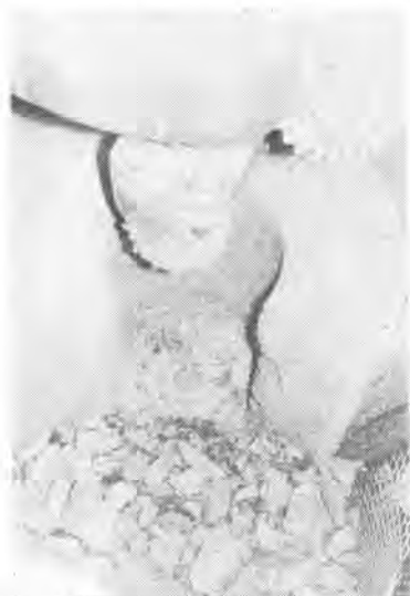
写真-4 パイロットビットで隣接孔に碎石を投入してモルタルをラップ掘削した状況
