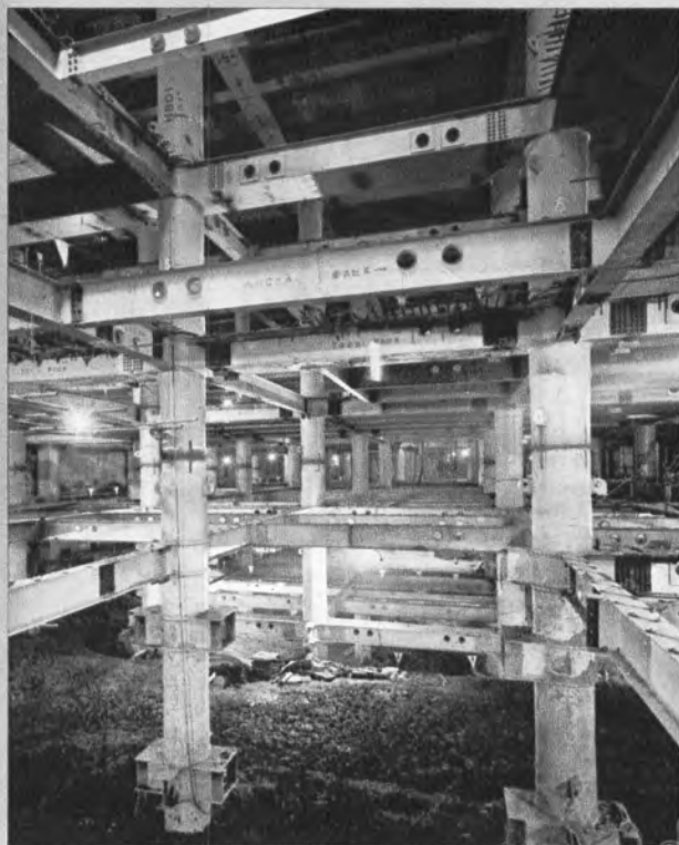
▲地下3階までの鉄骨組立も完了し、 4階の掘削および鉄骨組立を施工中
