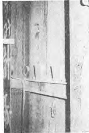
写真-6 木製縦矢板施工状況
