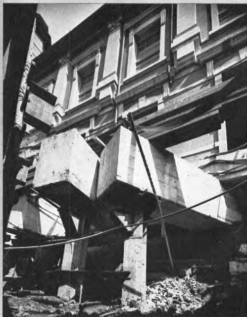
▲丸ノ内本屋の仮受が完了し、これから掘削にかかる
