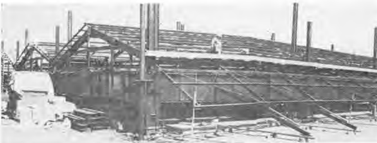
リフトアップ工法
