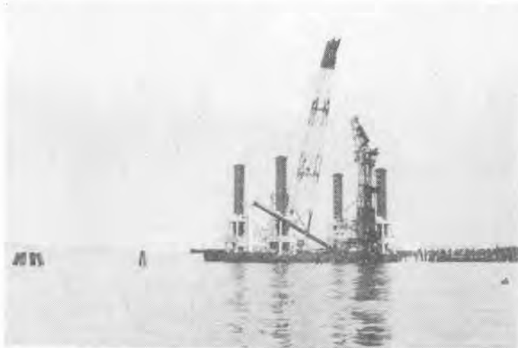
写真-2 ムアリングドルフィン No. 3 (φ1,219, l=62 m, 斜 20°) 打込み状況—昭和 47 年 4 月 25 日~27 日—
