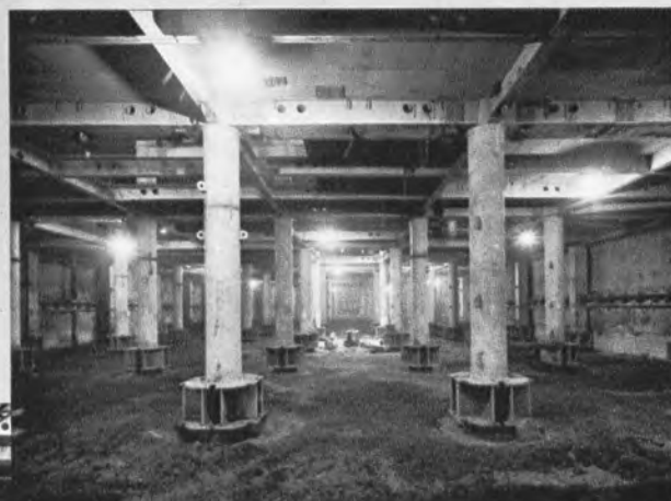
▲地下5階の掘削も完了し、 最後のはりがこれから取付けられる
