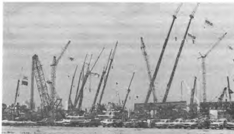
林立するクレーン
