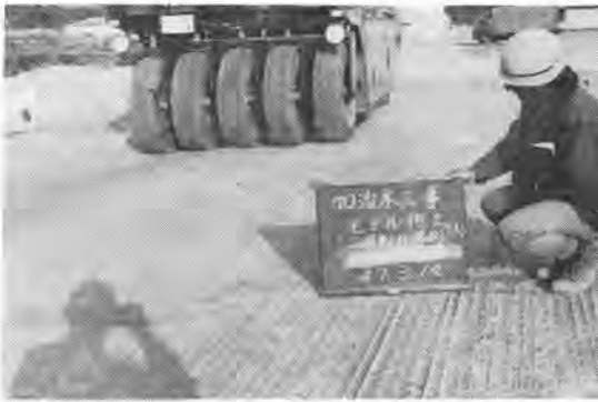
写真-3 タイヤローラによる締固め状況 (加治木工事)
