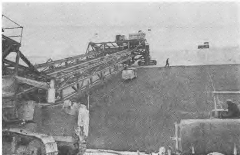
左側のローラは堤防の底部におかれたトラクタによって操作される。右側の機械は堤頂のトラクタによって操作される。
