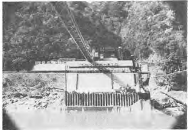
写真-1 白川取入口工事
