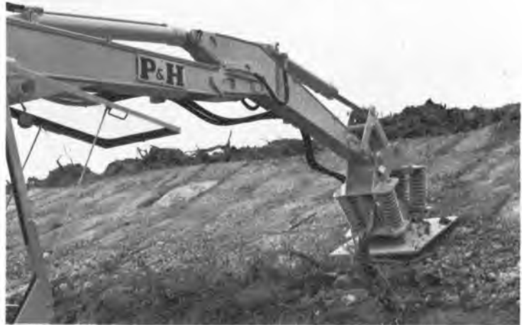
●能率良くトレンチシートを打込み
