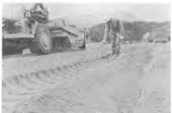
写真-2 モータスクレーバによるまき出し状況 (給良工事)
