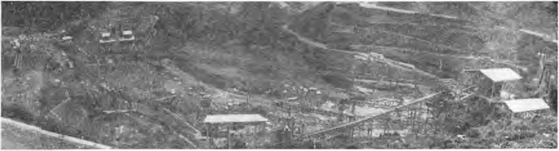
写真-1 ダムサイト右岸骨材製造プラント全景
