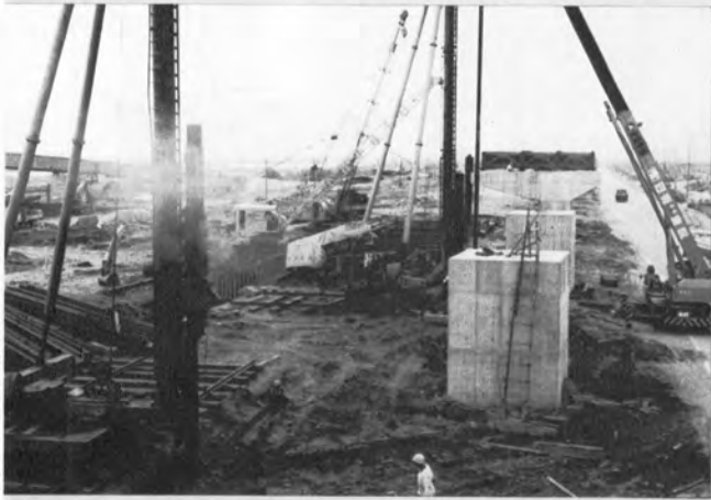
▼矢板の打込み
