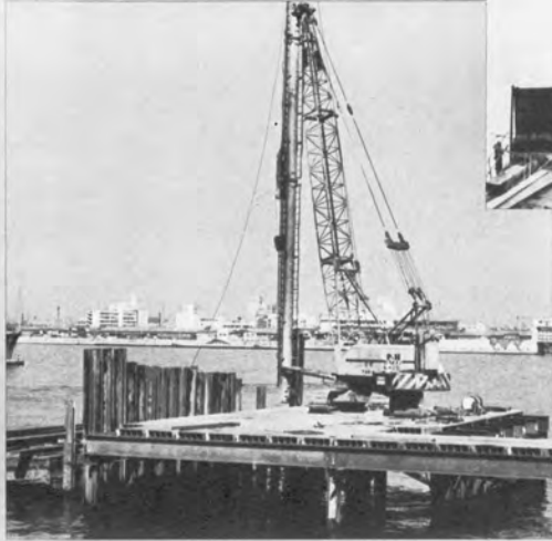
▼ケーソン仮締切（二重締切） のための鋼矢板打ち
