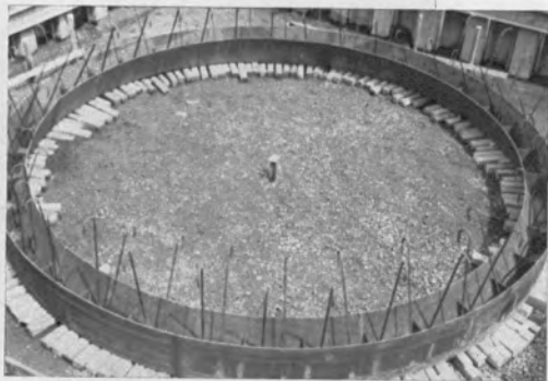
▼築島完了、沓の設置
