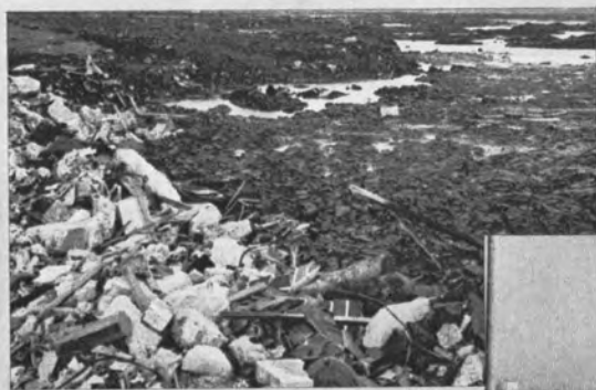
▲着工前の湾岸道路予定地 (大井ふ頭内)
