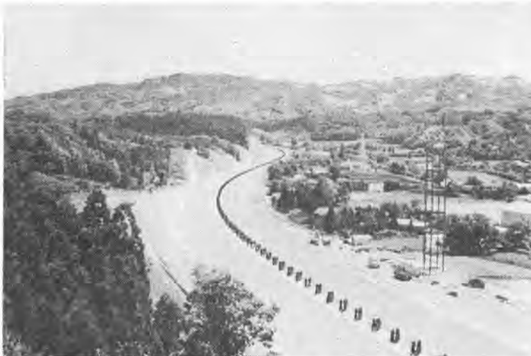
写真-1 玉名 P.A. 付近バイパス終了、サーフェース未施工 (南関・菊水舗装工事)
