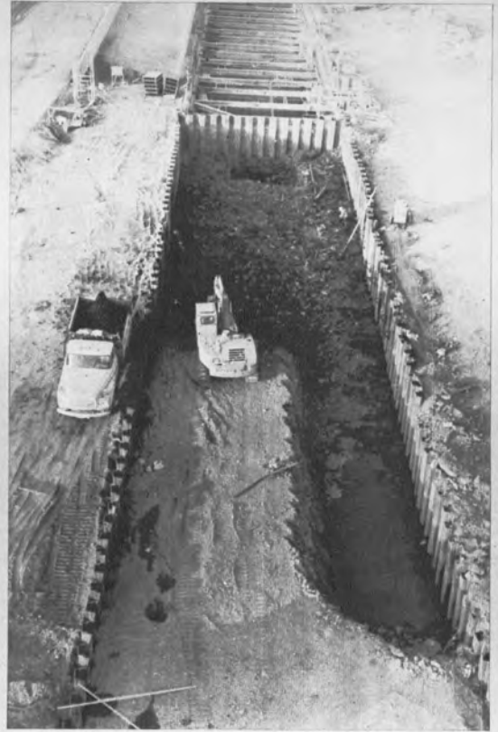
▲バックホウによる掘削
