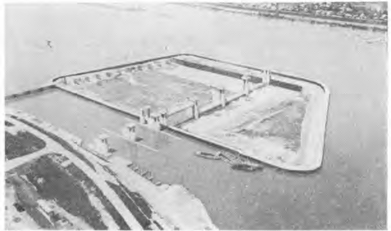
写真-2 木曾川大堰第 2 期工事の据付も平行して完了している。工事費は約 9 億円で、堰上流の取水暗きょ工事は昭和 45 年度中にすでに完了した。
