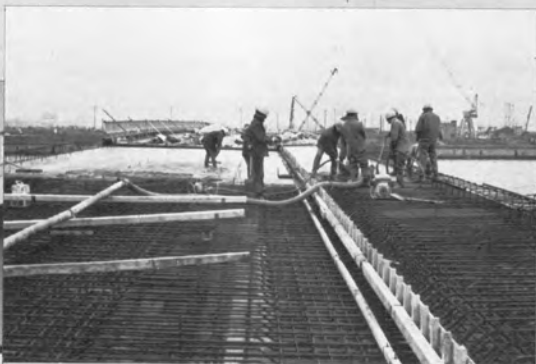
▲床版コンクリートの打設
