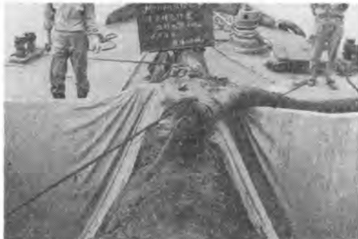
写真-3 土運船への吐出状態(多摩川)
