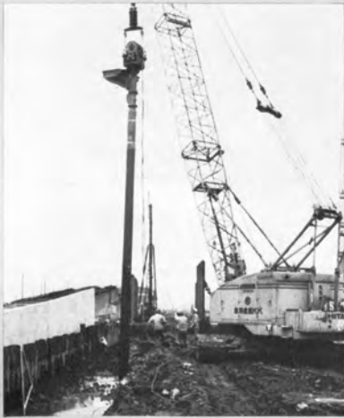
▲地盤改良のための 生石灰ぐいの打込み
