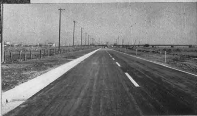
▼暫定2車線が完成した湾岸道路（供用中2.1km）
