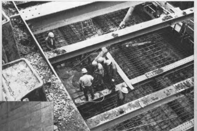
▲コンクリートの打設
