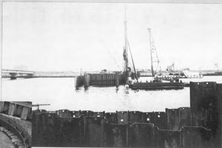
▲ディーゼルハンマM20による 鋼矢板の打込み（二重締切）
