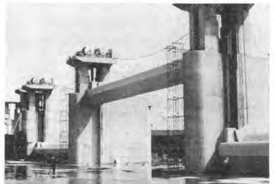
写真-3 堰体 (スパン 40 m) および洪水吐ゲート
