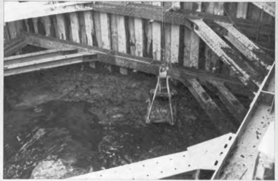
▲海底下の軟弱土の掘削
