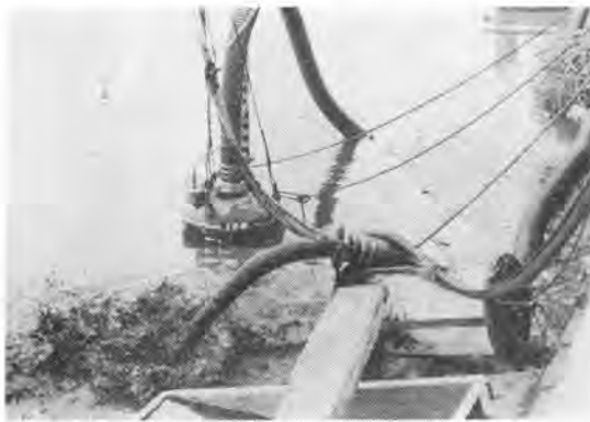
写真-1 実験機によるヘドロ吐出状態
