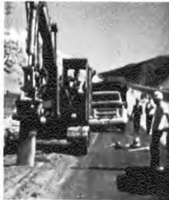
●能率良くトレンチシートを打込み
