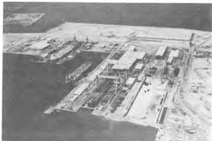
写真-1 川崎重工業坂出工場第2建造ドックの建設中
