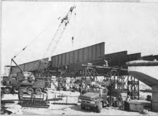
▼庄川橋の上部工 -北陸道・庄川橋工事-
