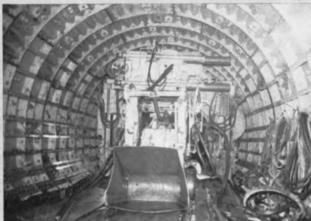
ずり積み機と後続台車で 支保工にセグメントを使用▶ —真鶴道路3期・真鶴トンネル工事—
