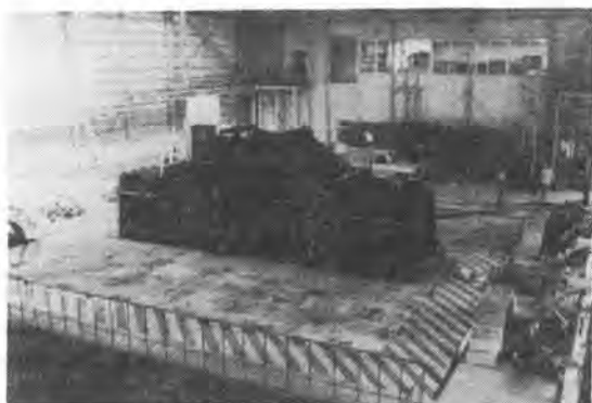
写真-3 大形耐震実験施設
