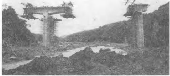
写真-2 ディビダーク工法による那珂川橋の施工
