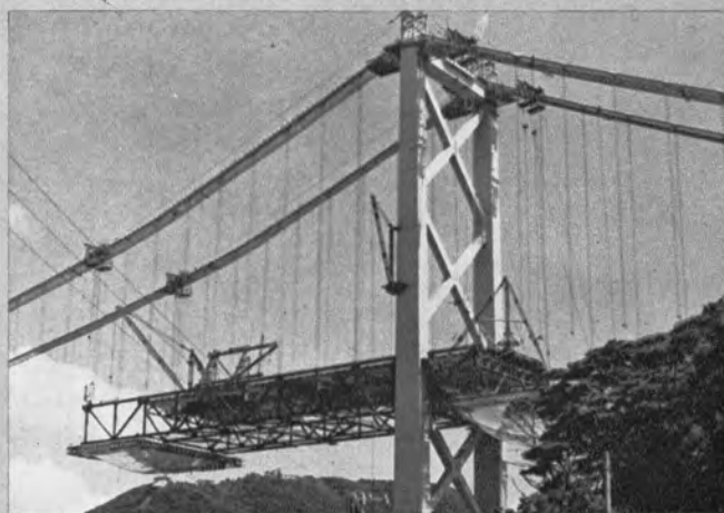
けた上の移動クレーンにより パネルの補鋼けたを架設▶ —関門自動車道・関門橋工事—
