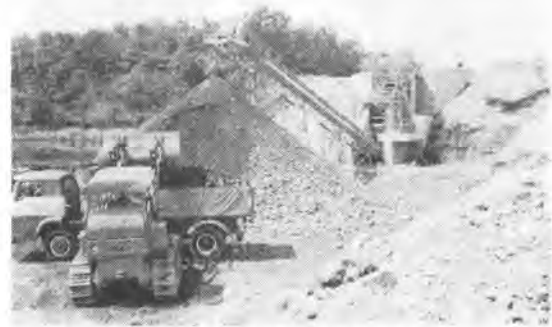
写真-1 玉石の砕石(黒磯工事)
