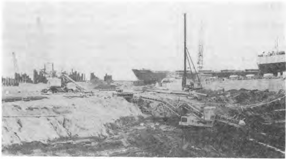
写真-1 B.W.Eによる掘削状況
