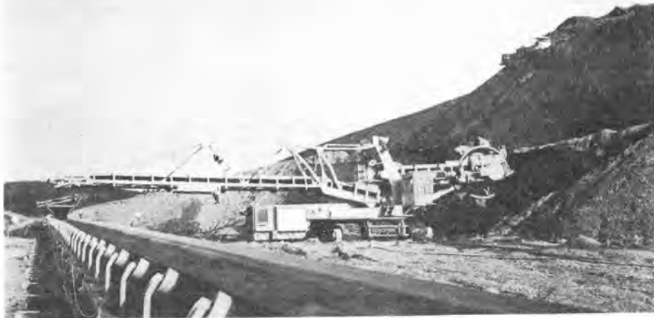
写真-2 C-300 による掘削状況
