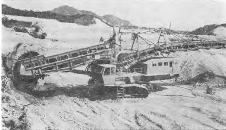
写真=1 KE-2000 の掘削状況
