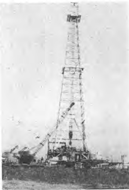
写真-2 深層地震観測井の工事
