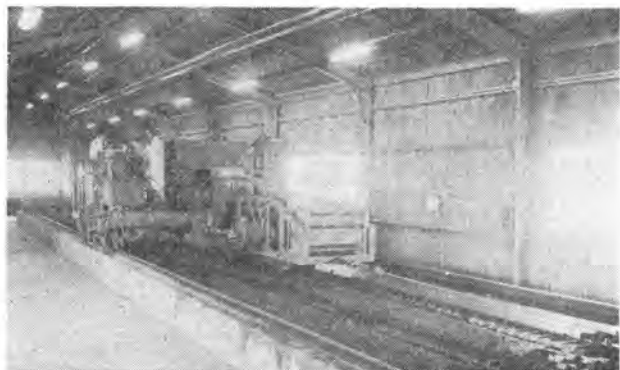
写真-4 土工板による掘削、運土の研究
