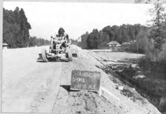
▼モータグレーダによる路床整形 —東北道・宇都宮舗装工事—
