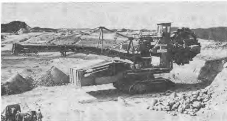
写真-1 C-500 による掘削状況
