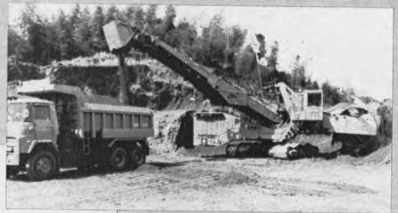
▲B.W.Eによる道路掘削 -九州道・瀬高工事-
