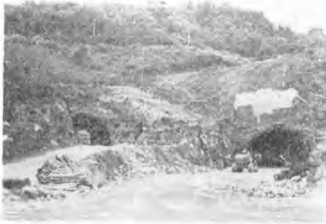
↓ 写真-7 愛宕山トンネル福島側坑口
