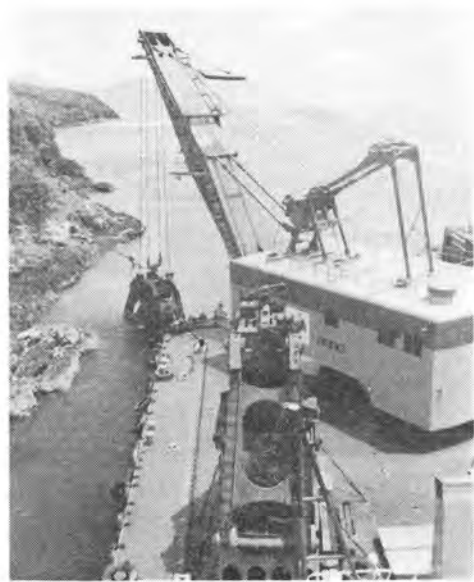
写真-2 グラブ式浚渫船（長島側作業中）
