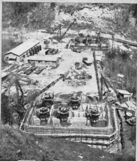
▼中田切川PC橋のケーソン工事 —中央道・伊那工事—
