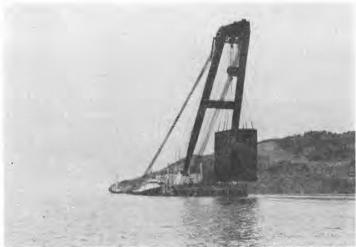
写真-4 1,200 t ぶりクレーン船による鋼わくのつり込み(作業ヤード仮置)
