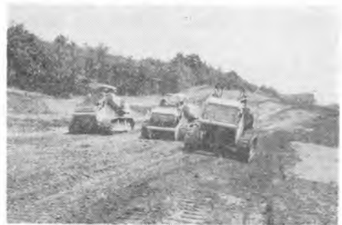
↓ 写真-4 ロームに対してメンクを使用 (那須北工事)
