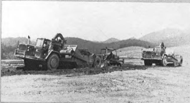
▲プッシュドーザとスクレーパによる 道路掘削 -中国道・福崎工事-
