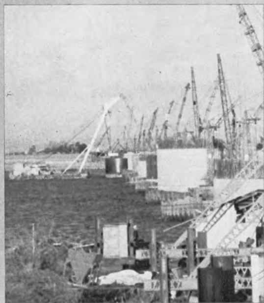
▲三脚デリックによるウェル掘削 —東名阪道路・木曾川橋脚工事—
