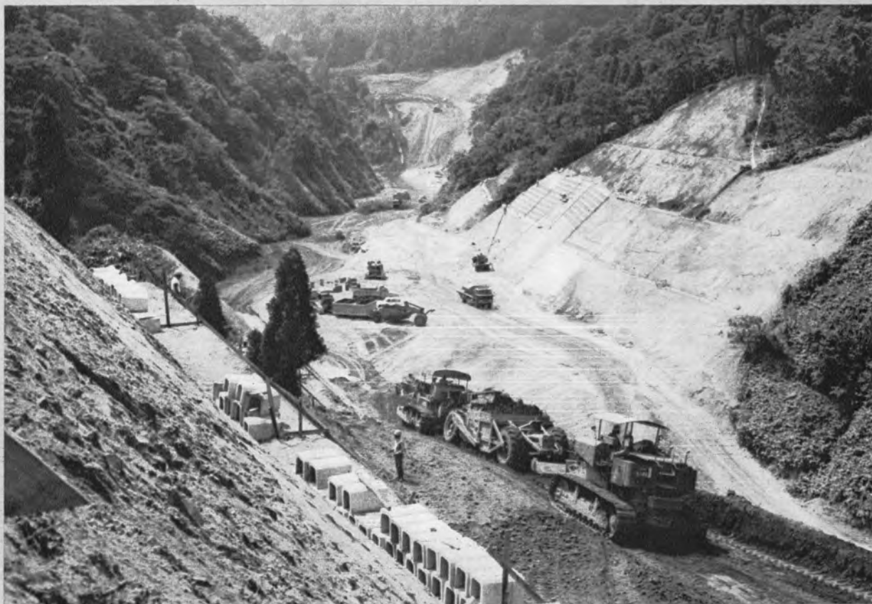
▲道路掘削 —北陸道・清水谷工事—
