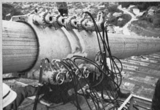
▲メインケーブルのボルトテンショニング —関門自動車道・関門橋工事—
