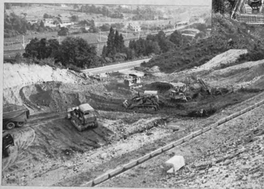
▲国道19号隣接区間の道路掘削 —中央道・恵那工事—
