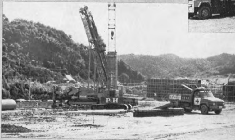
◀φ1,500ペントぐいの打設 -九州道・加治木I.C橋工事-
