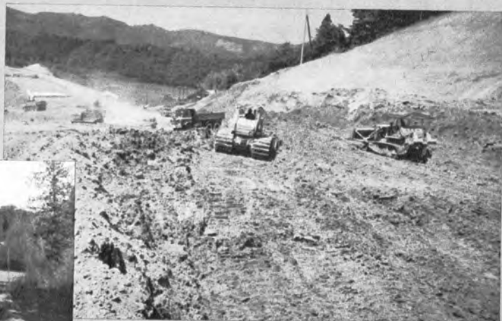
▲道路掘削 —東北道・仙台工事—
