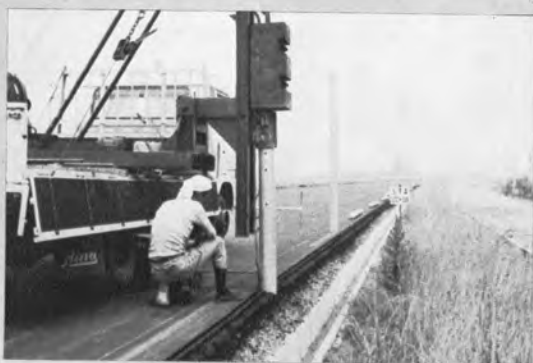
▲ガードレールポストの打込み —東北道・岩槻舗装工事—
