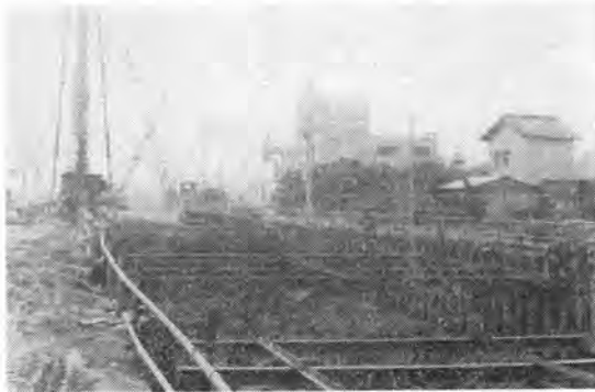
写真-2 従来一般的であった開削工法 (打出幹線 2,900×2,700 2連)
