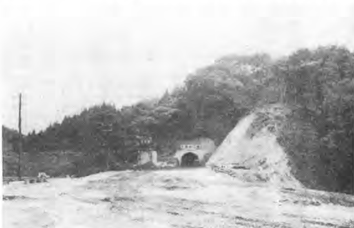
写真-1 第2有壁トンネル坑口付近
