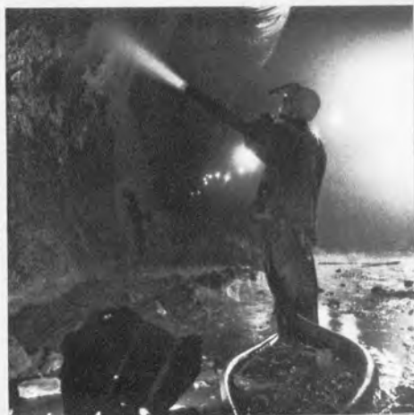
▲コンクリート吹付作業 (北海道側)
