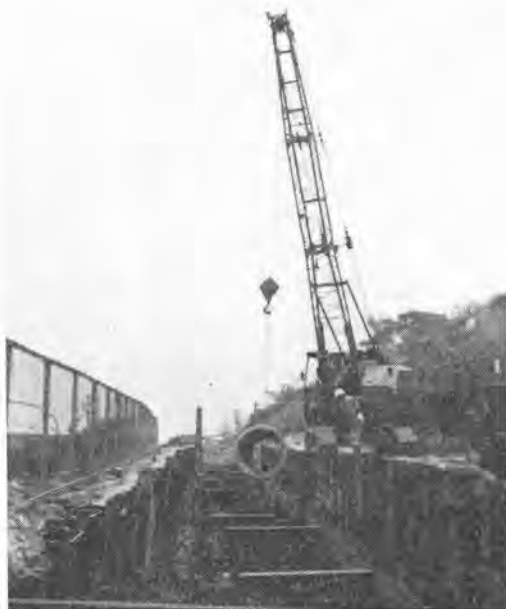
写真-1 ヒューム管の布設(管渠工事)
