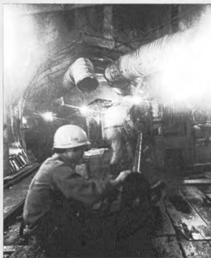
▲本州側坑内における 先進ボーリング作業 —交通新聞提供—
