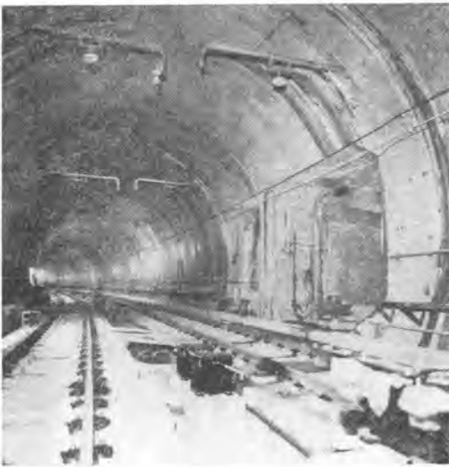
写真-1 錦町工区複線シールド
