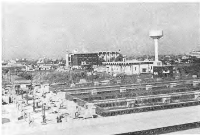
← 写真-7 手前は水処理施設、後方は汚泥処理施設（川俣処理場）
