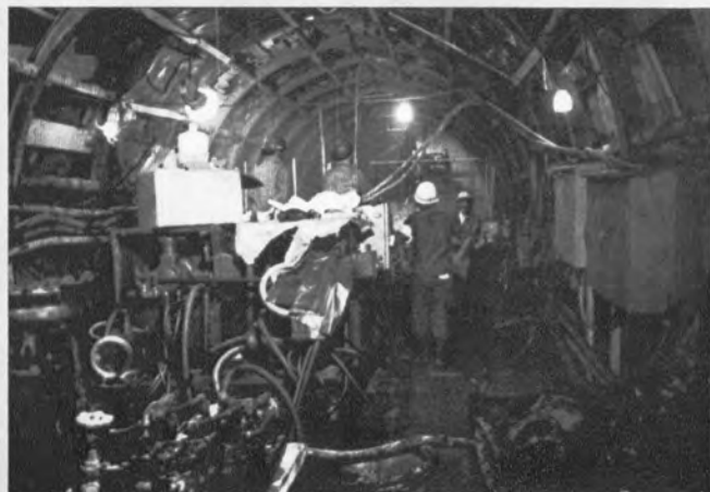
▲本州側坑内における止水注入作業
