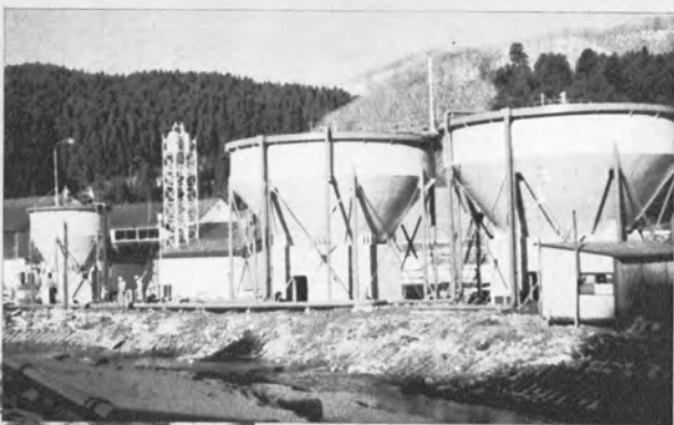
▲トンネル廃水処理場（北海道側） 処理能力 600 m 3 /hr
