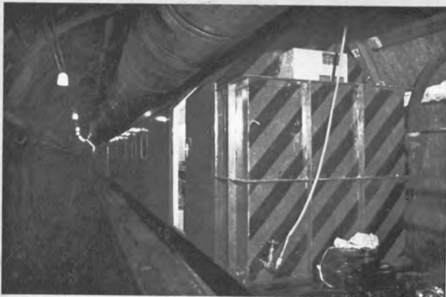
坑内主排水ポンプ室（北海道側） 室内の壁面は吹付コンクリート施工▶
