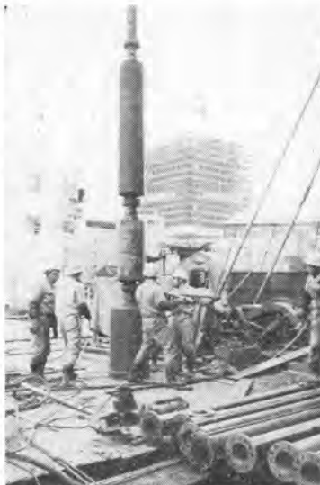
写真-2 円筒形ビット(垂直精度保持のため荷重カラーを取付けたもの)
