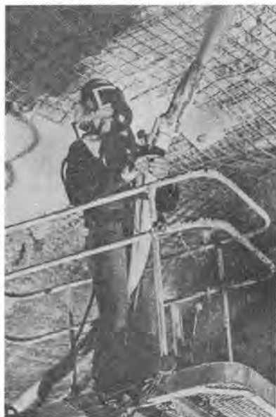
写真-1 コンクリート吹付作業
