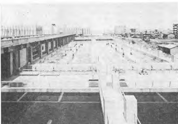
写真-8 水処理施設で、将来覆蓋できるよう柱の一部ができています（鴻池処理場）
