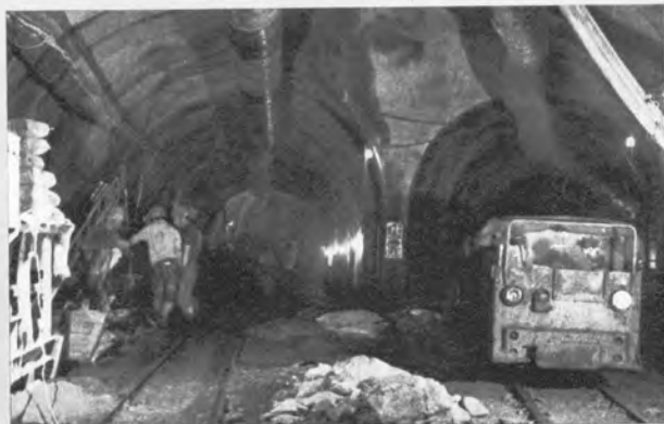
北海道側坑内状況 左側で吹付作業中▶
