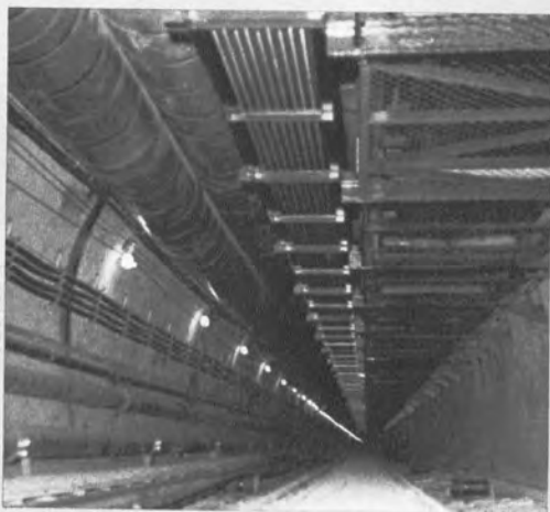
▲北海道側斜坑内（延長1,210m、こう配14°01'） 坑道上部の左は通風管、右はベルトコンベヤ、 中央はコンベヤ保守通路
