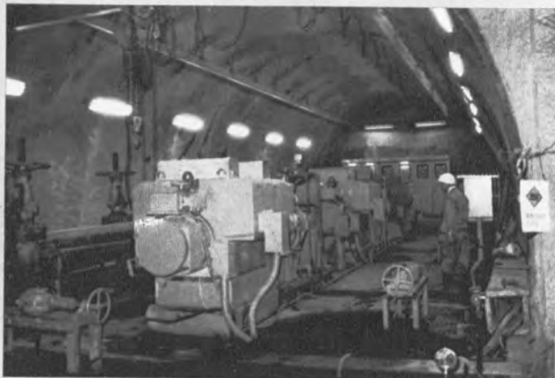
坑内主排水ポンプ室（北海道側） 室内の壁面は吹付コンクリート施工▶
