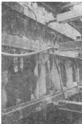
← 写真-5 中村幹線築造工事における地中壁 (□ 2,900× 3,000 mm PIP)
