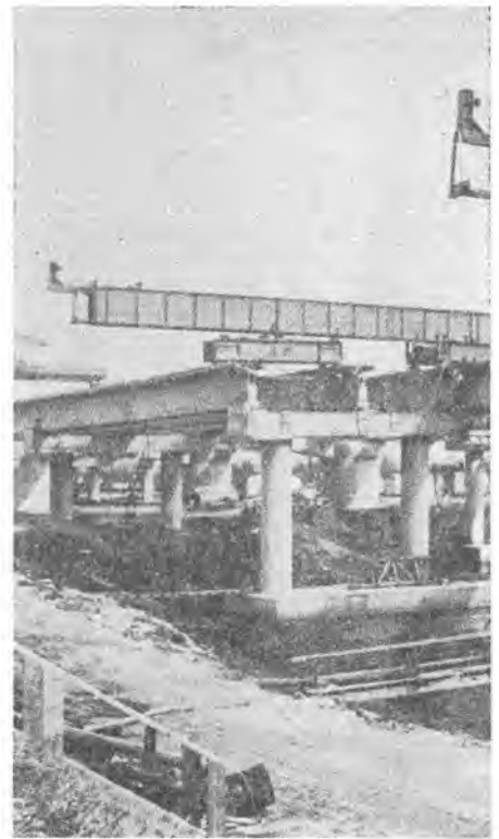
→ 天井走行ホイストによる 橋げたの設置
