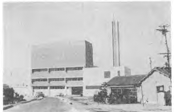
写真-5 ポンプ室、沈砂池上屋 (氷野ポンプ場)
