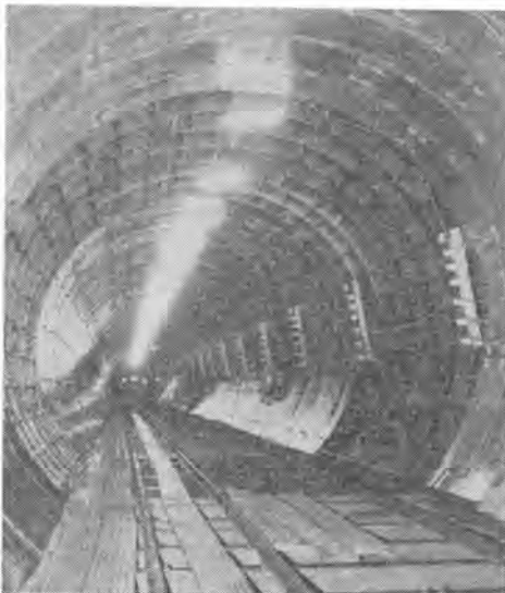
写真-1 シールド（外径 5,250 mm）1次覆工完了状況（青戸幹線工事）
