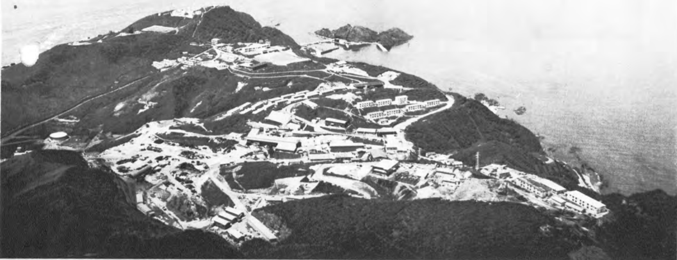
▲本州側工事基地の全景
