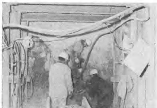
写真-3 神田橋工区トレンチ内凍土掘削状況
