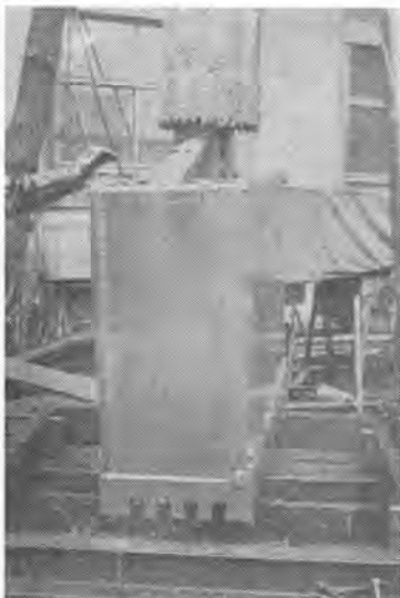
写真-4 鉄筋そう入前に掘削、検測をかねるゲージ通し
