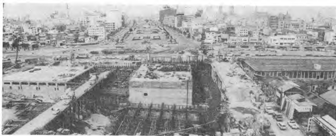
写真-1 建設が進む掘留処理場
