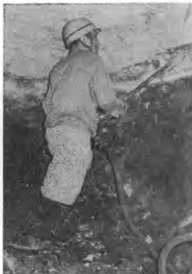
写真-4 水道橋工区凍土掘削状況
