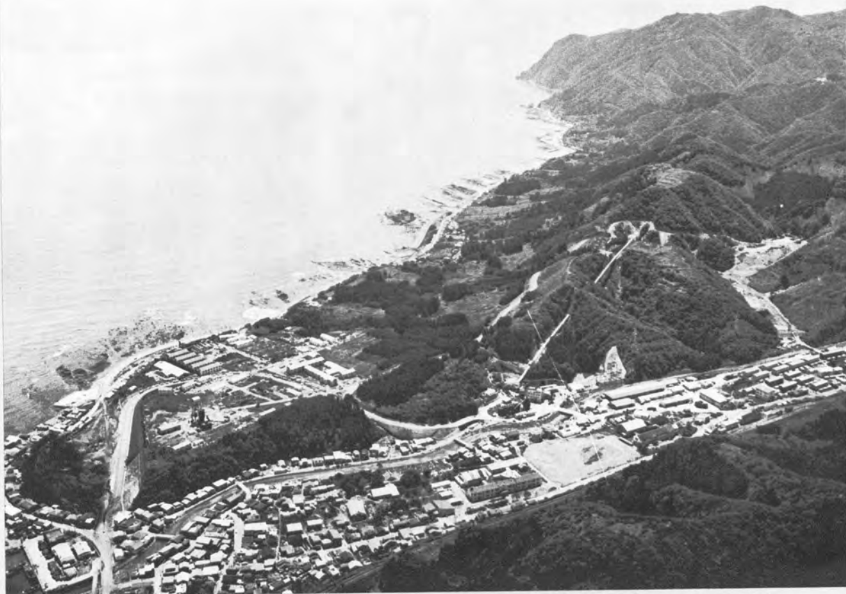
▲北海道側工事基地の全景
