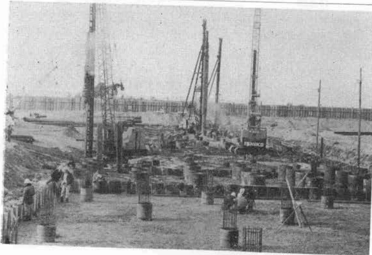
写真-2 基礎工鋼管打設
