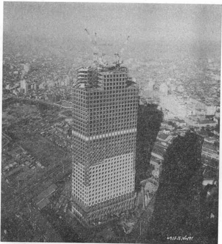
写真-1 新宿住友ビル全景→
