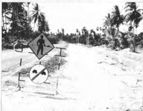
▼現道拡幅工事
