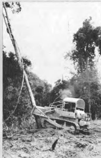
▲ブルドーザによる倒木作業
