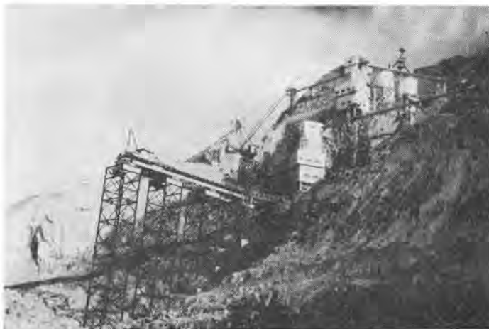
写真-2 ダムサイト左岸の仮設備
