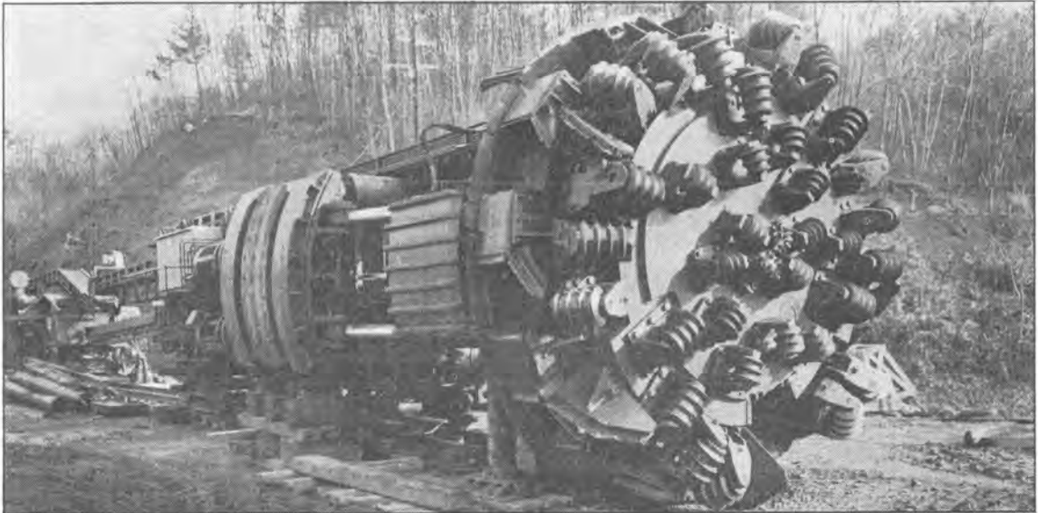
↑ 東北新幹線工事に挑む硬岩トンネル掘削機
