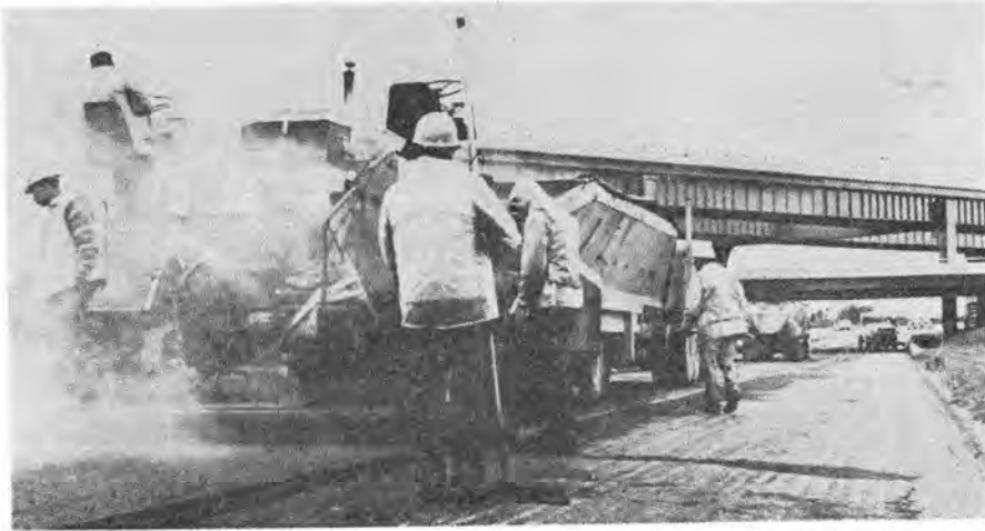
↑ 可傾式トレーラができなかった低い橋の下で さえ積荷を降ろすことができるトレーラ
