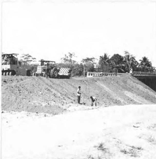
▲バンナイ橋付近の盛土転圧
