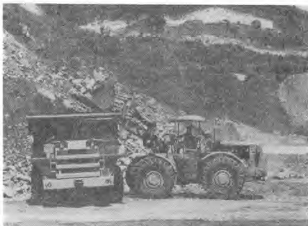
写真—3 本体掘削のずり積込みの状況
