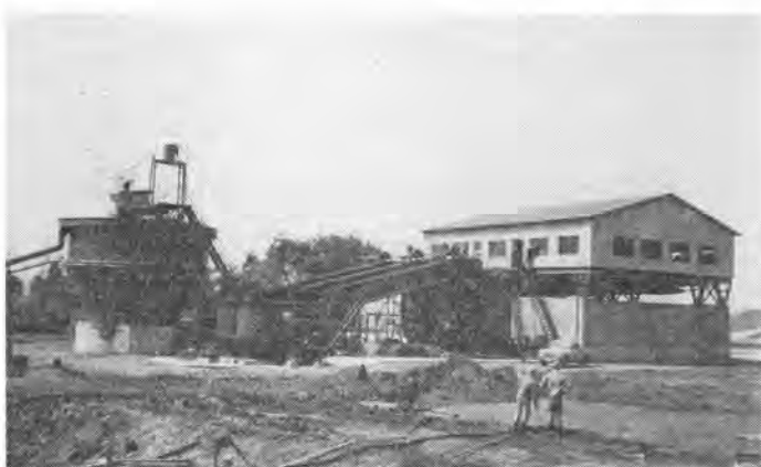
写真-3 鋼製濁水処理設備
