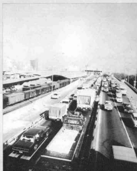
最近完成した1号羽田線の拡幅工事 外側を拡幅したが既設路線を拡幅する難工事であった▶
