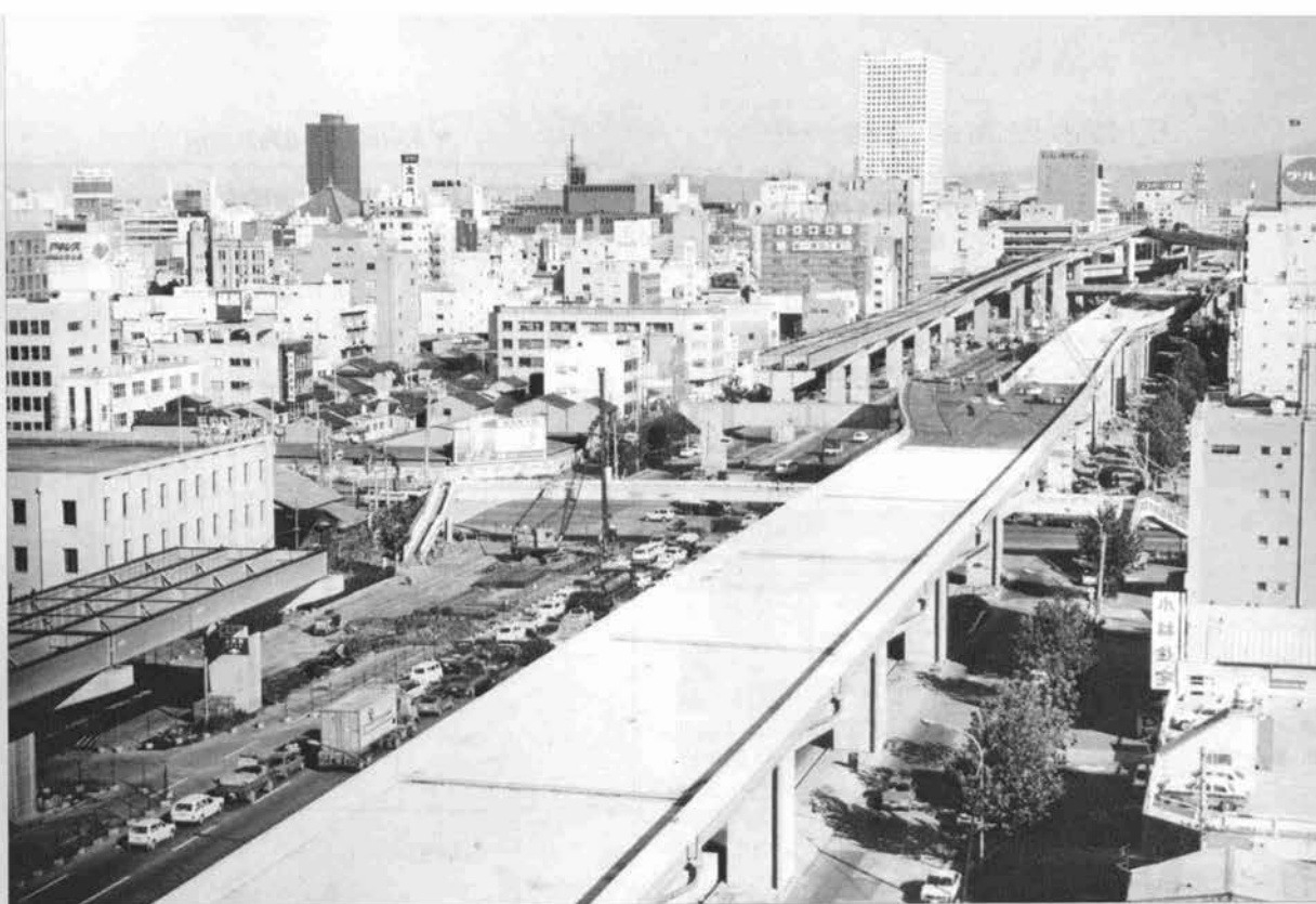
▲大阪東大阪線 床版工事中の阿波座上通付近
