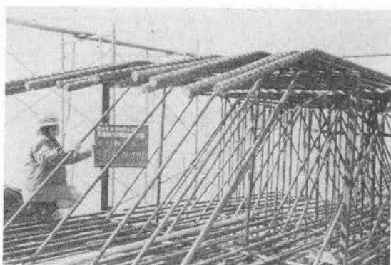
写真-2 D 51 の建込み
