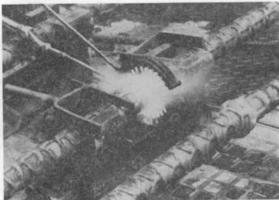
写真—4 強還元ガス圧接法
