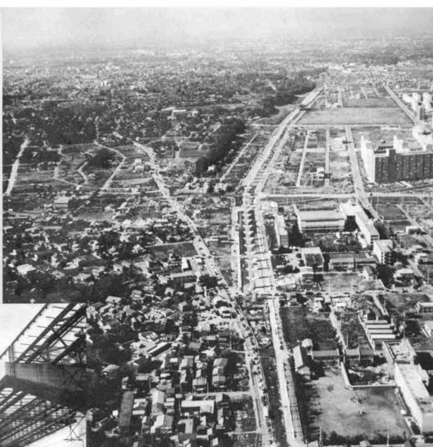
5号線2期 高島平団地付近の状況▶
