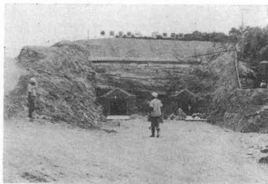
写真-4 西側坑口
