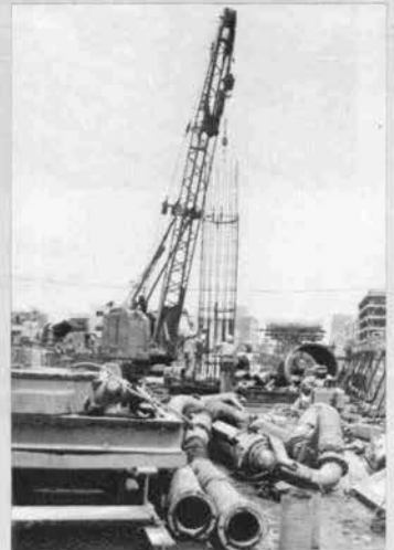
▲径1.5mのリバースぐいの鉄筋建込み状況
