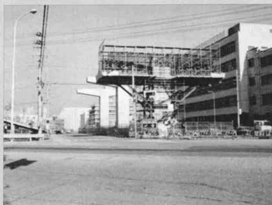
▲名古屋高速道路堀田地区橋体梁部分PC構造
