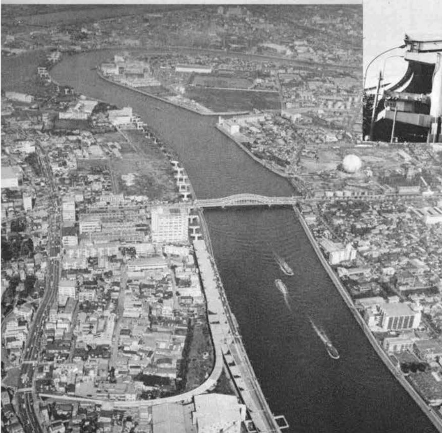
◀6号線2期 隅田川白髪橋付近を上流に向かって工事中
