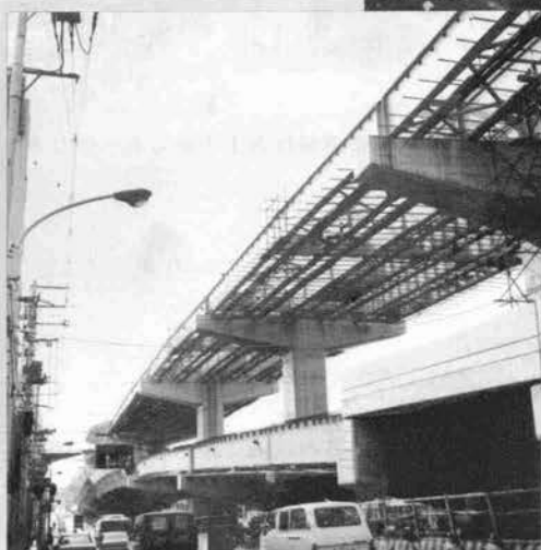
▲ 4号線2期，甲州街道上の施工状況
