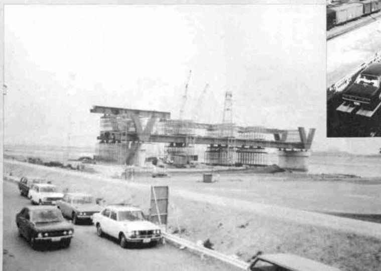
▲ 6号線2期，荒川横断橋梁（V形立体ラーメン鋼床版）の架設状況
