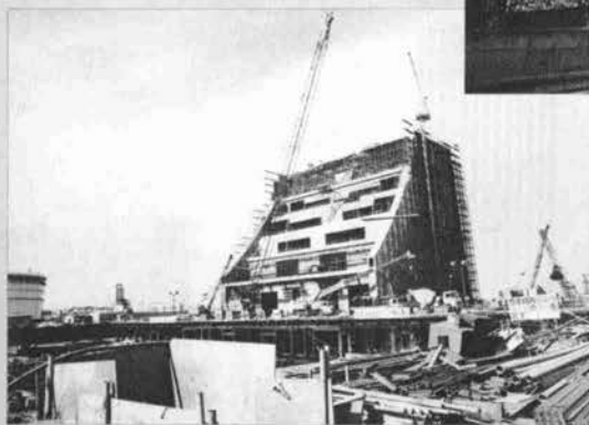
▲湾岸線1期、立坑の施工状況
