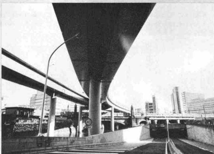
▲最近開通した環状八重洲線で、東京駅前の八重洲駐車場に出入りすることができる
