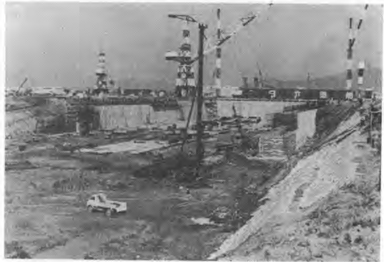
写真-2 建設が進む No.2 大形ドック
