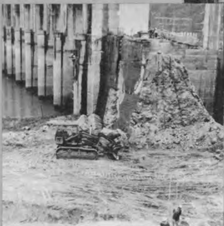
▲取水口既設鹿瀬ダム撤去工事 コンクリートずり搬出作業
