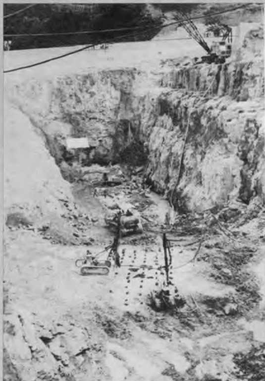
▲クローラドリルによる 発電所掘削さく孔作業
