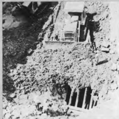
▼発電所掘削 グローホールずり投入口
