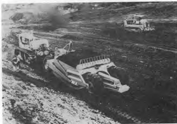
写真-1 被けん引式スクレーパ(コタド 22 SA)の作業状況
