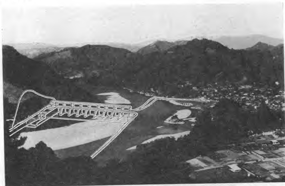
写真-1 船明ダム発電所地点(着工前下流側より)
