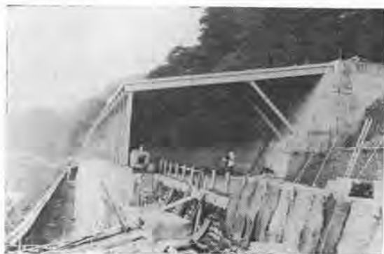
写真-1 スノーシェッド
