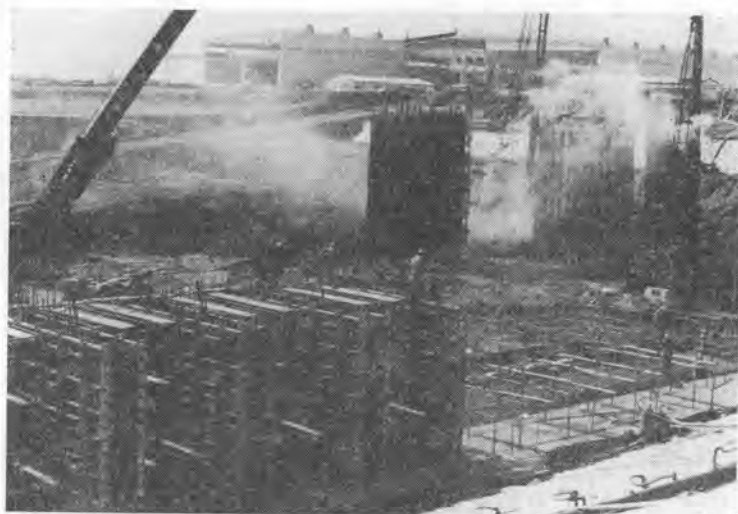
写真-4 No. 1 ドックの渠頭の渠壁工事
