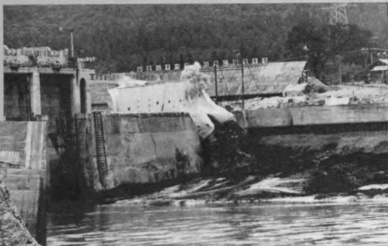
▲取水口既設鹿瀬ダム撤去工事発破作業
