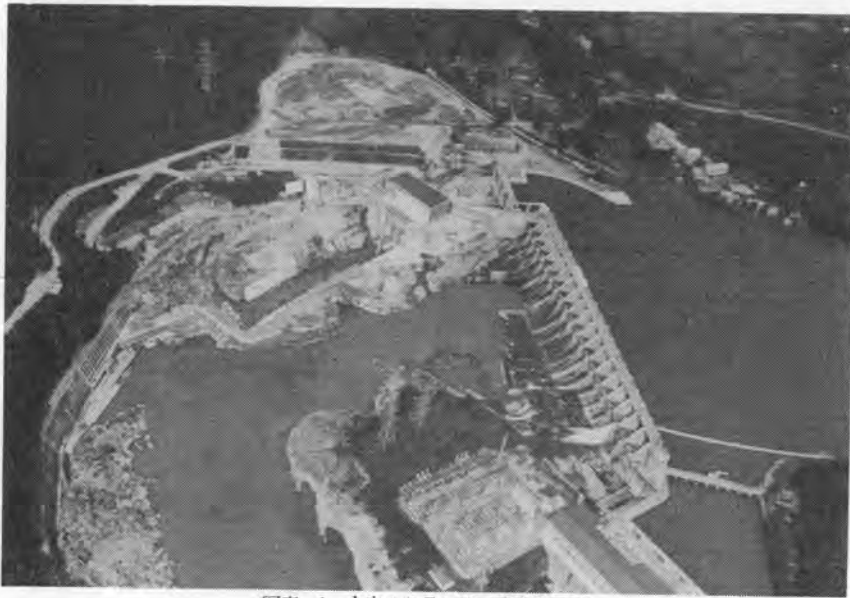
写真-1 上空より見た第二鹿瀬発電所
