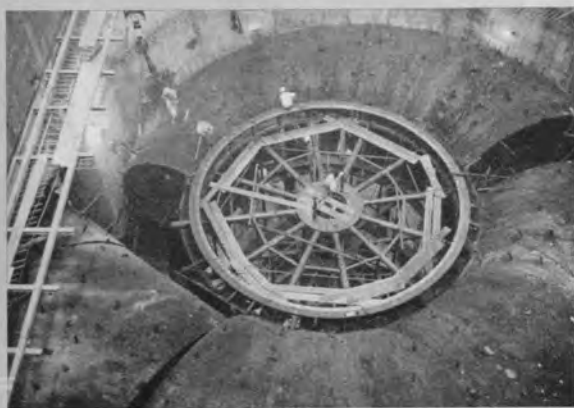
▶発電所ケーシング据付作業
