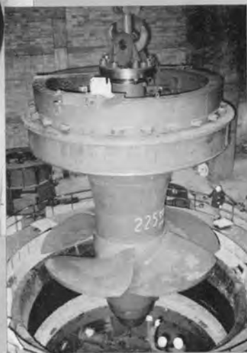
▲日本一の使用水量を誇る 水車の据付作業
