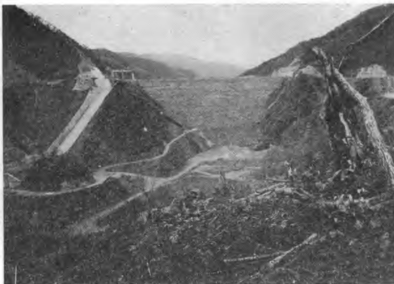
写真-2 ダム下流面および洪水吐斜路部 一昭和47年11月一
