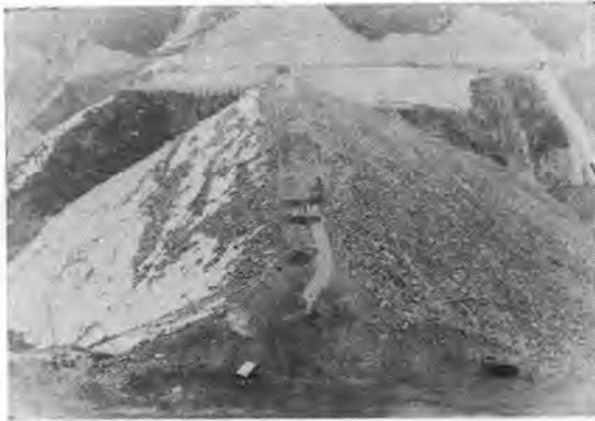
写真-4 完成したダムを左岸より望む —昭和48年3月31日—
