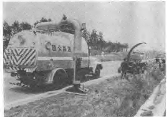
写真-5 真空式芝刈清掃機による分離帯の清掃作業
