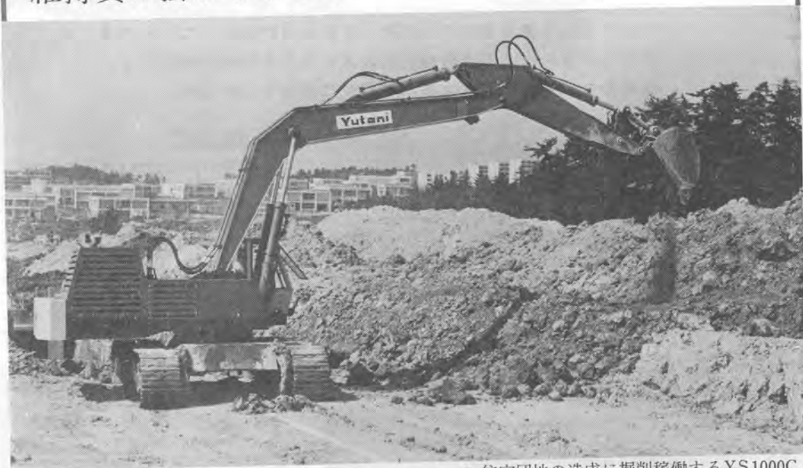
▲住宅団地の造成に掘削稼働するYS1000C
