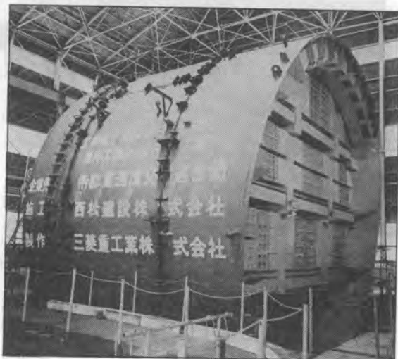
↓ 地下鉄工事に活躍する手掘式シールド
