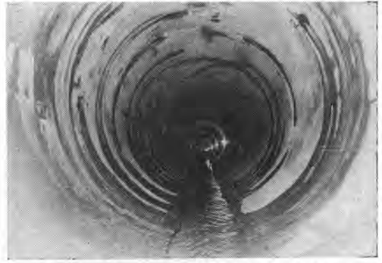
写真-5 巻立, グラウト完了の内径 4.7 m トンネル —昭和48年3月31日—
