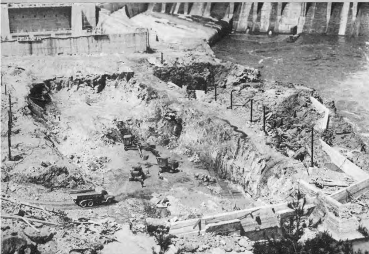
▼2次仮締切内での放水路掘削工事
