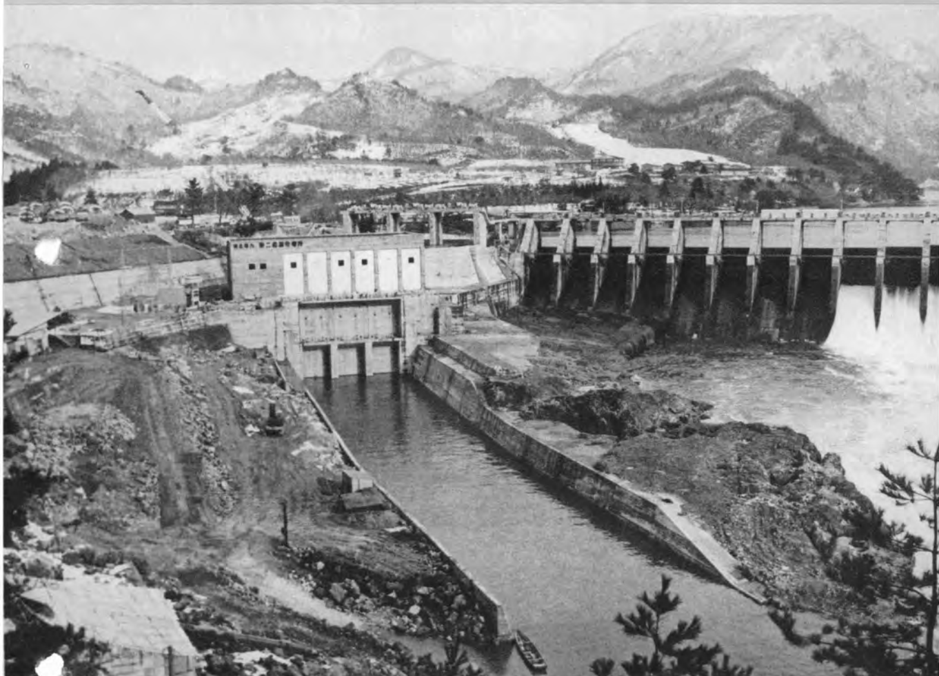
▲通水を待つ第二鹿瀬発電所
