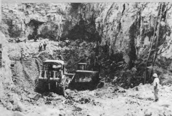
▼2次仮締切内での放水路掘削工事
