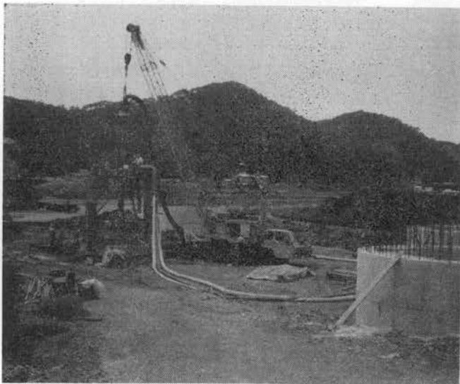
写真-1 現場作業状況
