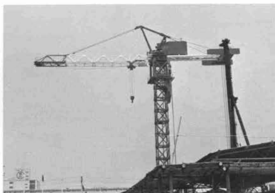
▲レール走行用の大形タワークレーン
