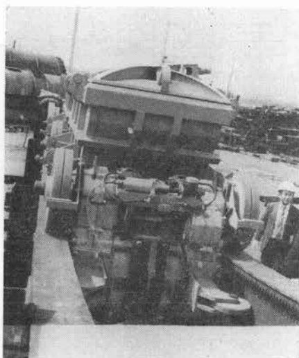
写真-3 列車前部で、右にラックレール、ガイド車輪が見える
