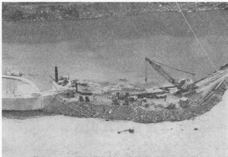
右岸荒締切内鋼矢板打ちおよびグラウト(昭和47年12月19日)
