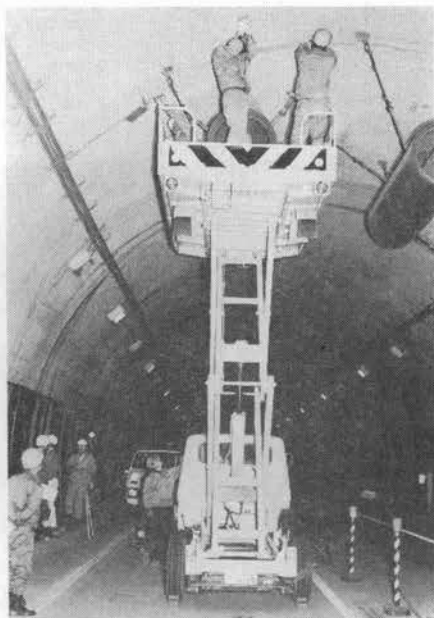
写真-1 ジェットファン取りはずし作業
