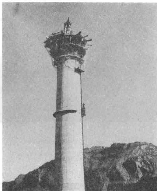
写真-7 スウェー・スリップフォーム施工状況
