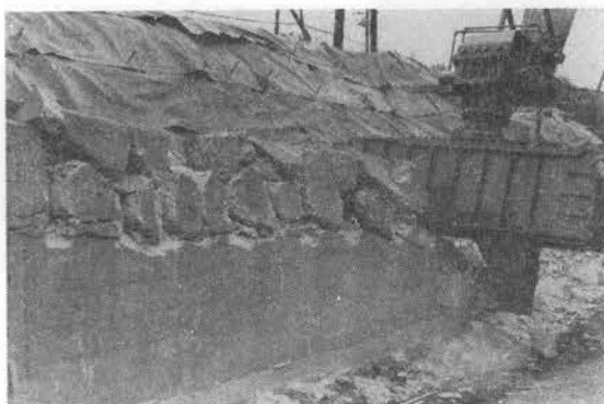
写真-2 破壊機による擁壁破壊
