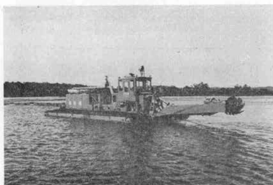
写真-5 水陸両用河道掘削機
