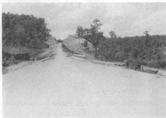
写真-5 橋梁部と掘削部
