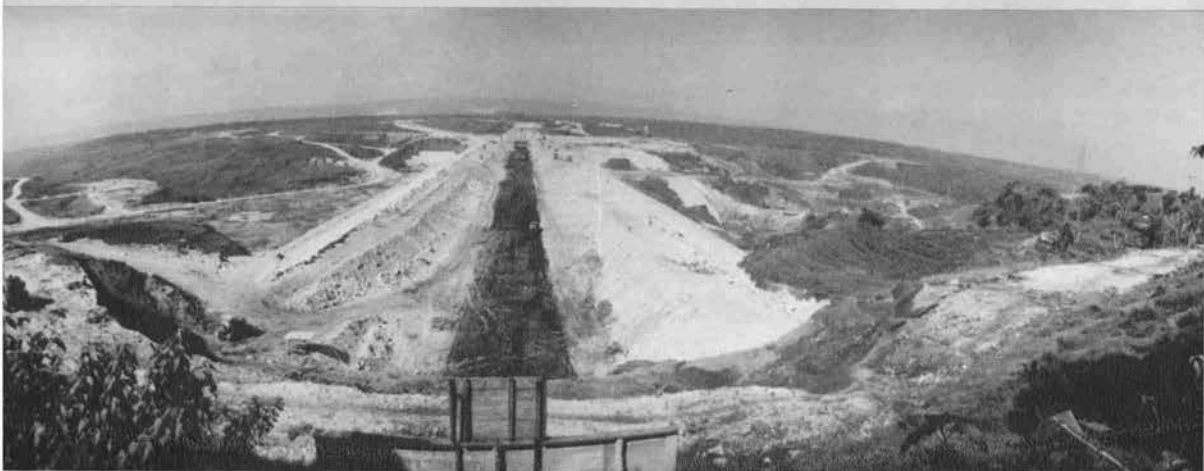
▼カランカテス・ロックフィルダム最終年度盛土 状況（1971年6月）
