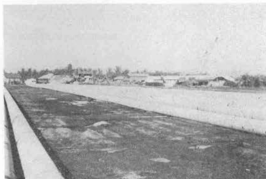
写真-2 コンクリートコーティングを終えた長管
