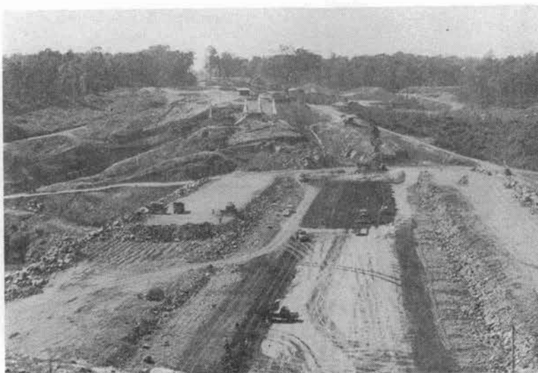
写真-1 ダム本体盛立状況
