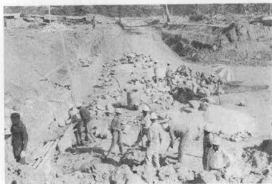
写真-10 現地人の石積作業
