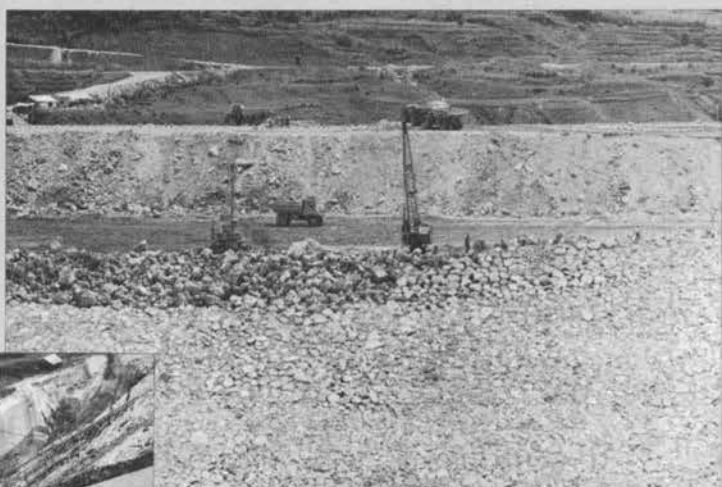
▲カランカテス・ロックフィルダム下流側リップ ラップ
