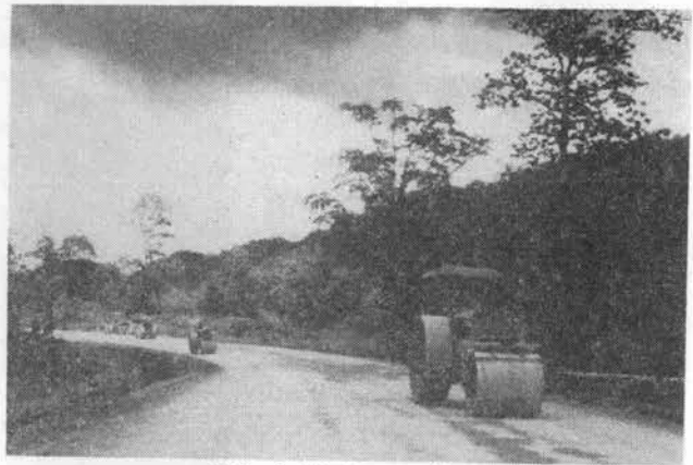
写真-6 砕石ベースの施工
