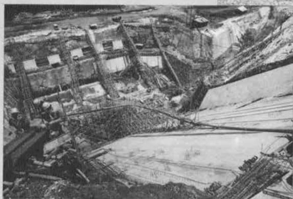
▲カランカテス・ロックフィルダム下流側リップ ラップ
