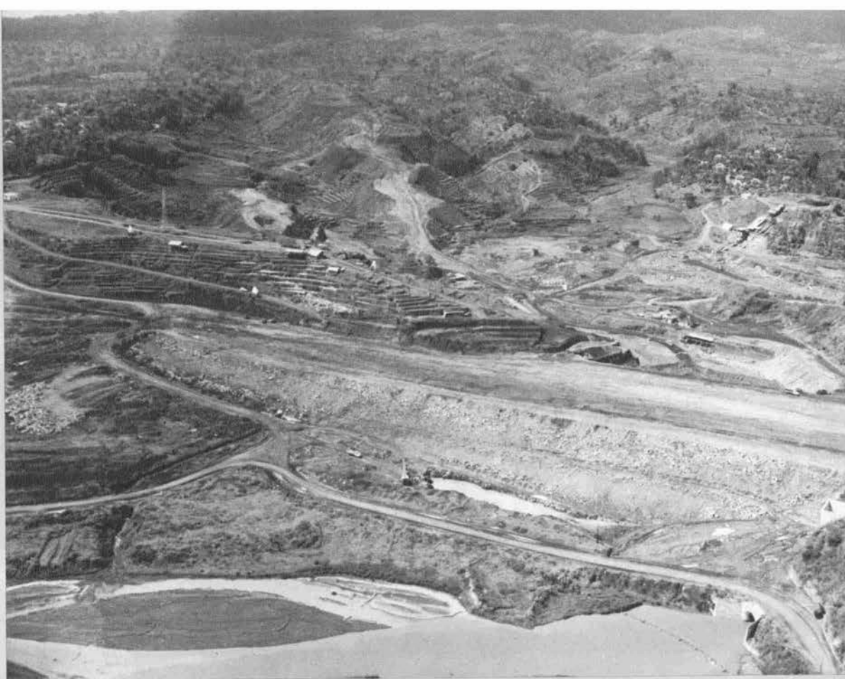
▲盛土工事中のカリコント・ゾーンフィルダム (1969年11月)
