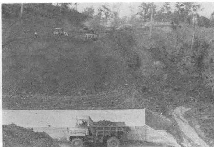
写真-3 盛土作業
