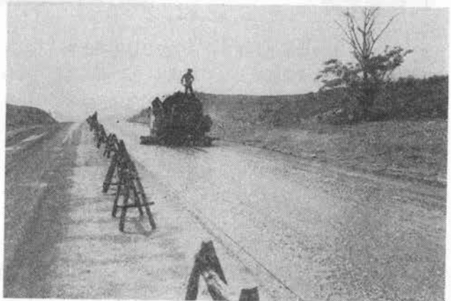
写真-7 プライムコートの施工
