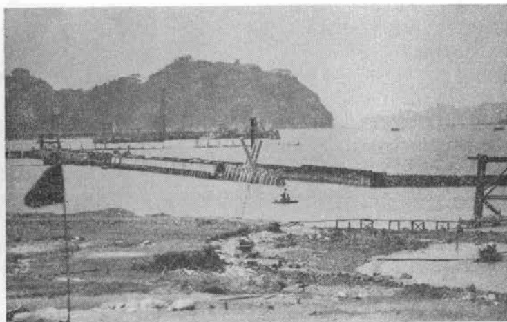
写真-8 コンクリートパイルおよびシートパイル
