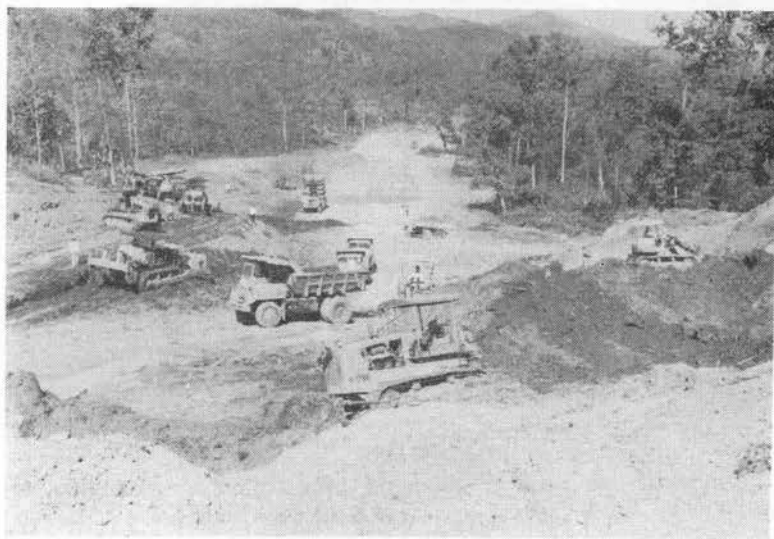
写真-2 土掘削作業
