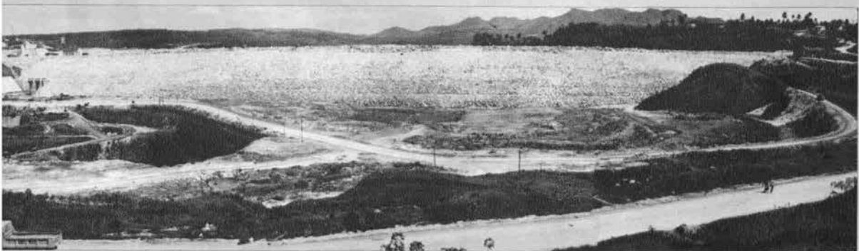
▲完成間近のカランカテス・ロックフィルダム上流側
