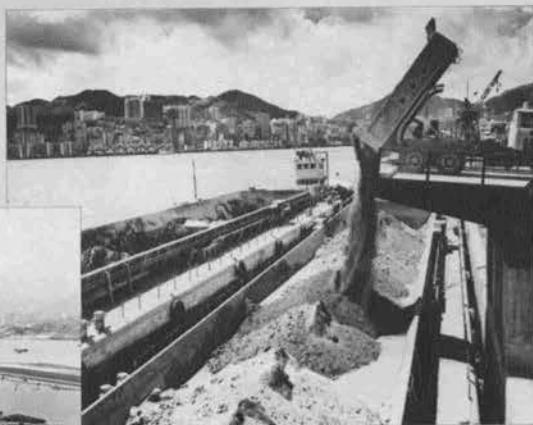
▲積込桟橋から土砂積込中の 1,000 \text{m}^3 土運船
