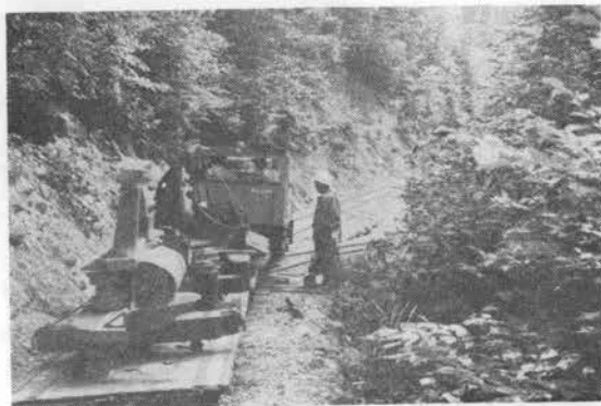
写真-2 分解して軌道を利用して現場に搬入される掘削機械
