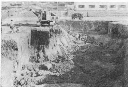
写真-2 1,300 kW および 2,400 kW 巻揚機の基礎掘削
