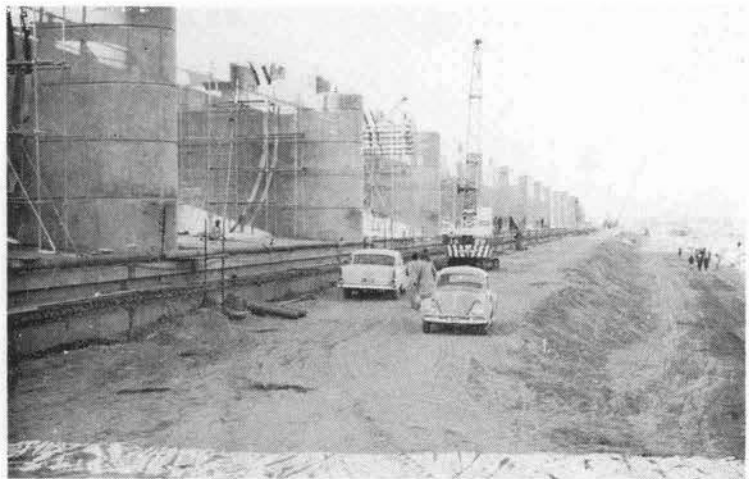
写真-1 西パキスタンでの水門据付工事
