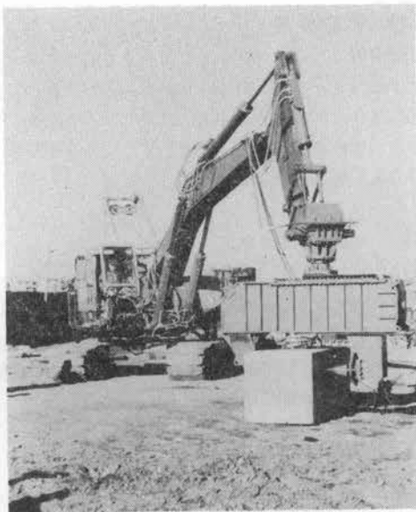
写真-1 コンクリート無騒音破壊機
