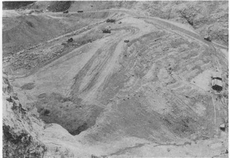
写真-1 七倉ダム地点
