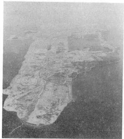
写真-10 昭和 48 年 6 月末現在工事状況
