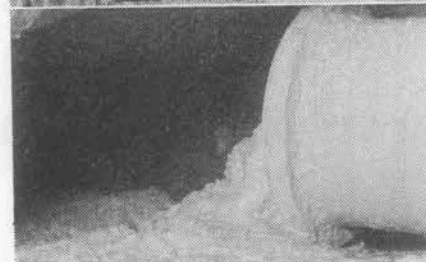
●側壁コンクリート打設最後のせめの状況
