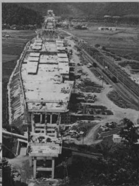
新岩国（仮称）駅高架橋▶ 軟弱地盤であり、一部盛土を施工している。 右側は軌道基地であり、手前で交差している 鉄道は岩日線である。
