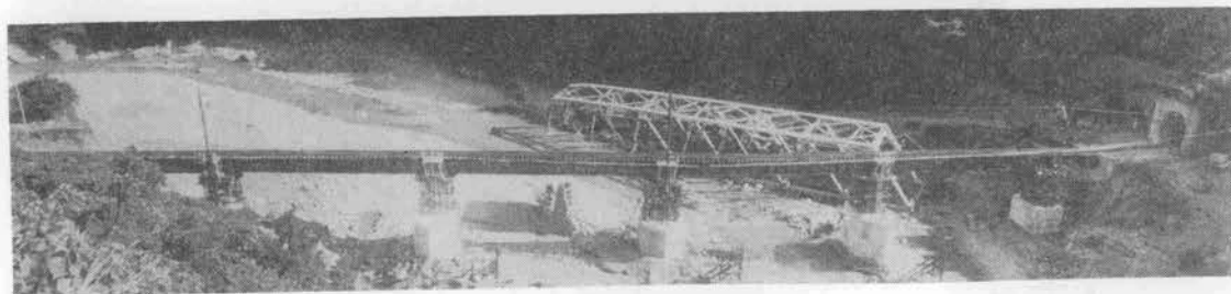
写真-3 上流方より見た仮橋梁
