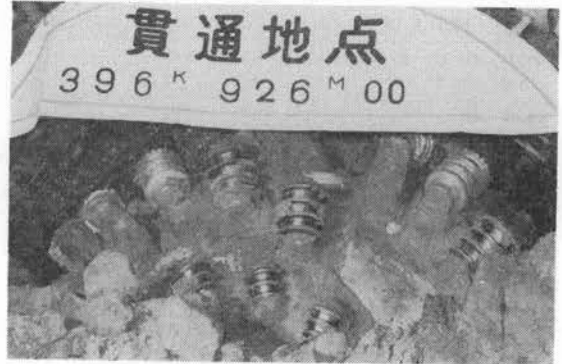
写真-4 貫通点の R.T.M 正面
