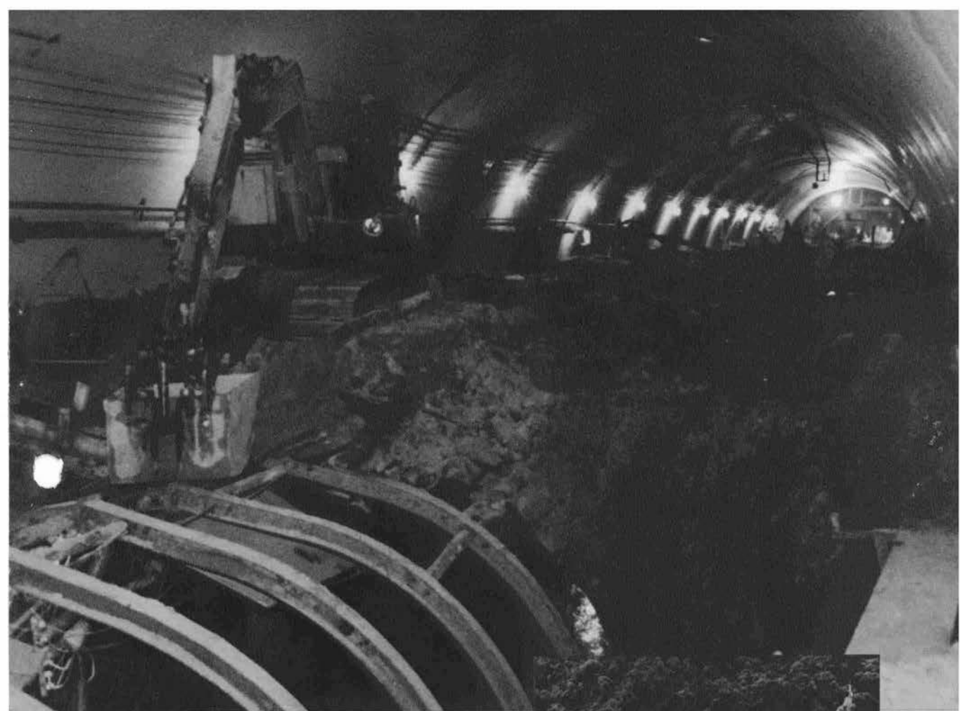
▲殖生トンネル西工区土平抜掘ならびに大背掘削 手前の支保工は底設導坑用のものである。
