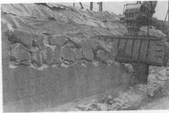
写真-3 塩浜現場における擁壁破壊試験
