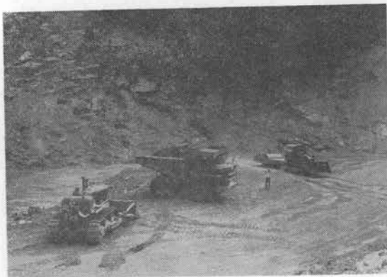
写真-2 ダンプによる運搬
