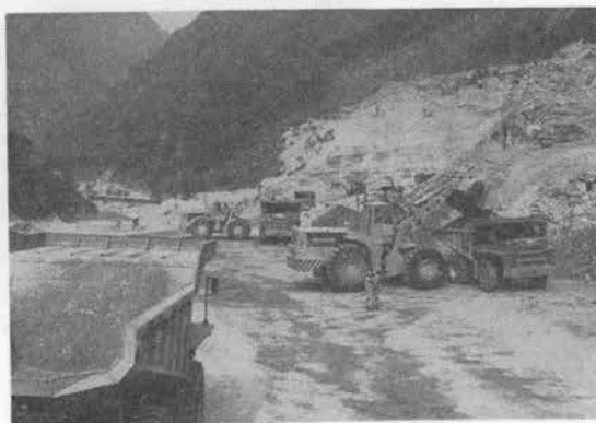
写真-3 ホイールローダによる積込み
