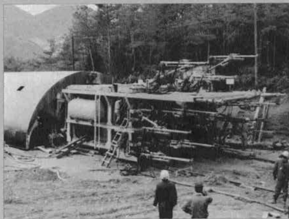
▼第2右田トンネル 上半掘削用11ブームジャンボとスチールフォーム
