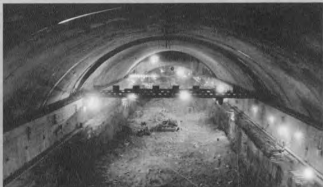
▲地下発電所の掘削（まずアーチ部の巻立を完了、2t 仮設クレーンで資材を運搬する）
