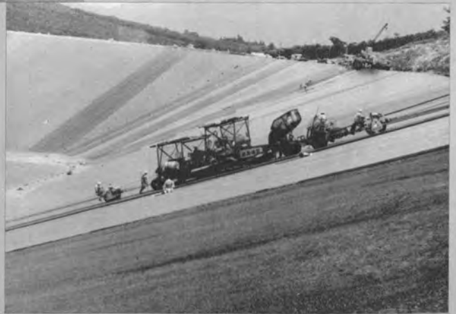
▲斜面部上層の施工（左より1次転圧用振動ローラ、ウインチデッキ、フィニッシャ、ダンパ車、先行レーンの2次転圧用振動ローラ）
