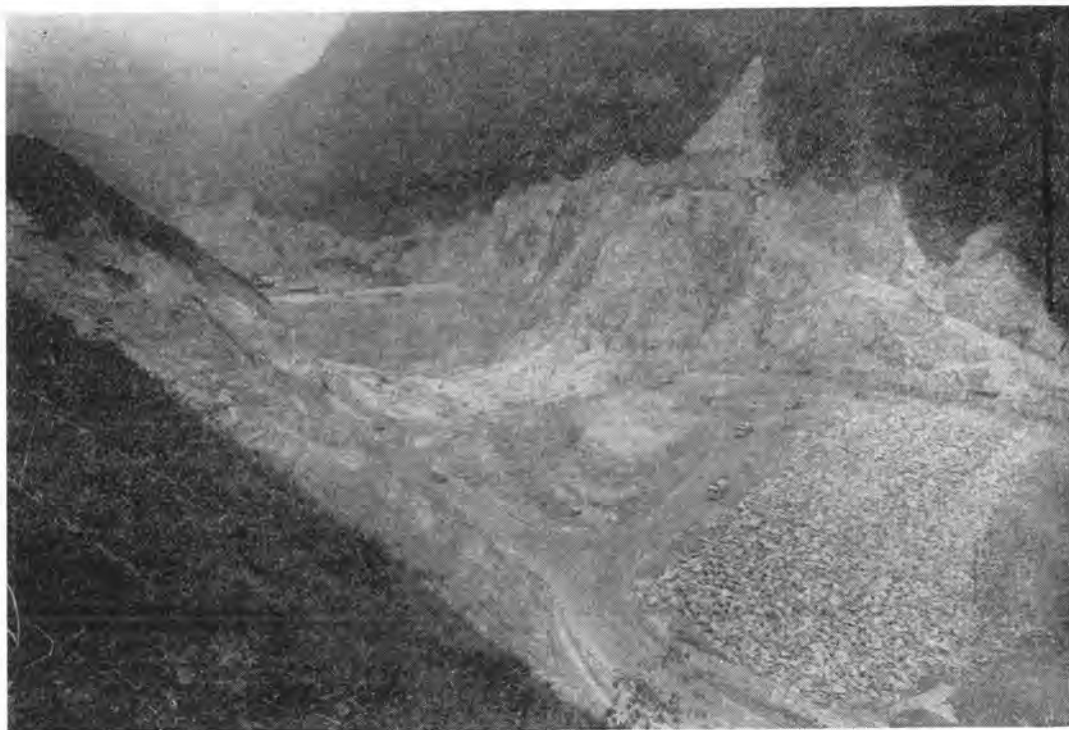
写真-2 七倉ダム工事状況
