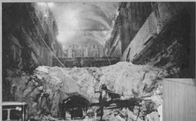
▲地下発電所ドラフト部の掘削 （下段中央導坑）
