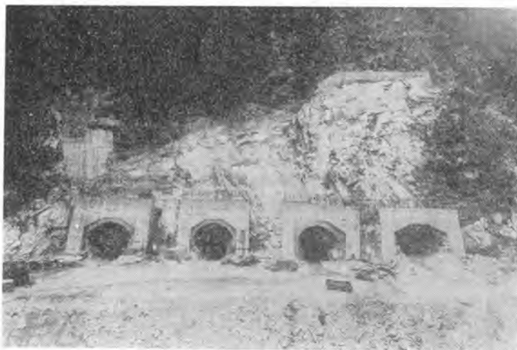
写真-4 新高瀬川発電所放水口部施工状況
