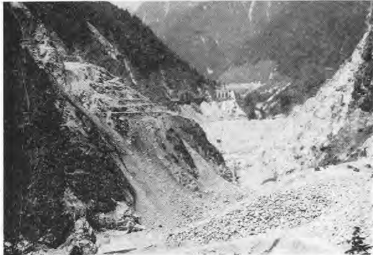
写真-1 高瀬ダム工事状況
