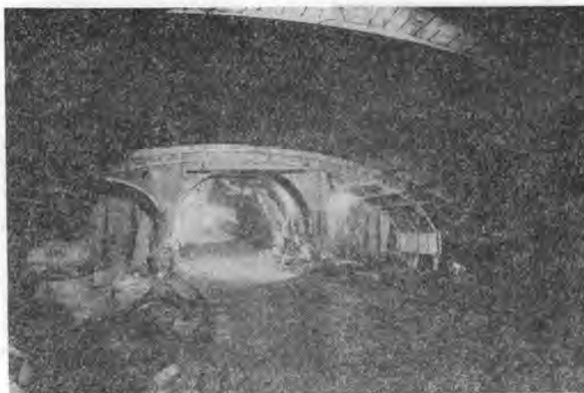
写真-3 新高瀬川発電所アーチ部施工状況
