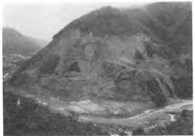
写真-2 岩屋ダム工事現況(ダム右岸)
