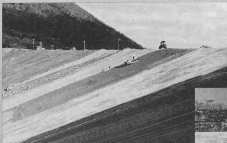
▼ブルドーザによるトランジションまき出し
