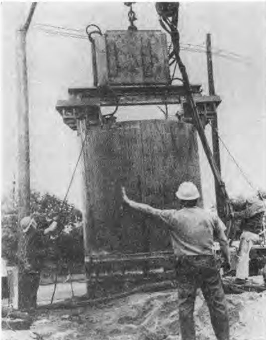
パイルドライバをケーソンに設置するには 5~10 分を要し、打込みは 2 分以下で完了する。
