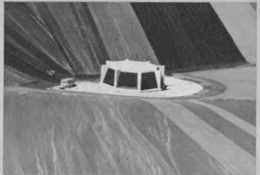
▲完成後の取水口で、周辺の池底だけはセメントコンクリートできている。
