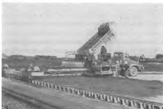
写真-2 標準形ボックススプレッダ (サイドフィーディング)
