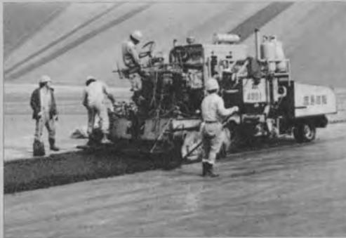
▲底面部中間層の舗装作業
