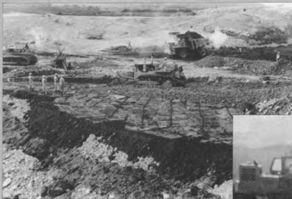
▲サンドイッチ工法による ダム本体の盛立作業
