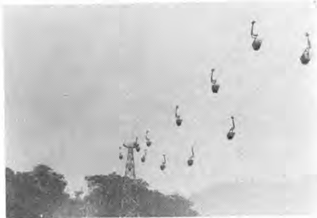
写真-1 索道による運搬状況
