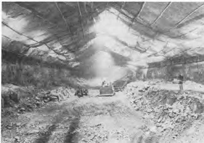
写真-3 地下発電所本体掘削状況(昭和 48 年 7 月末)
