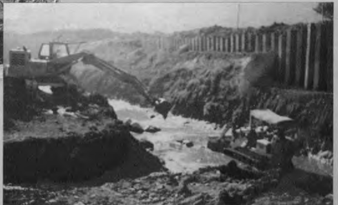
▼湿原側余水吐構造物基礎の掘削
