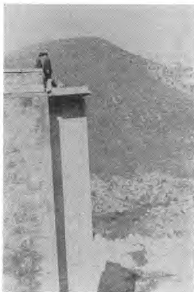
陥落したアーチ橋
