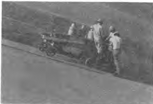
写真-3 スキーザによる斜面部表面保護層の塗布
