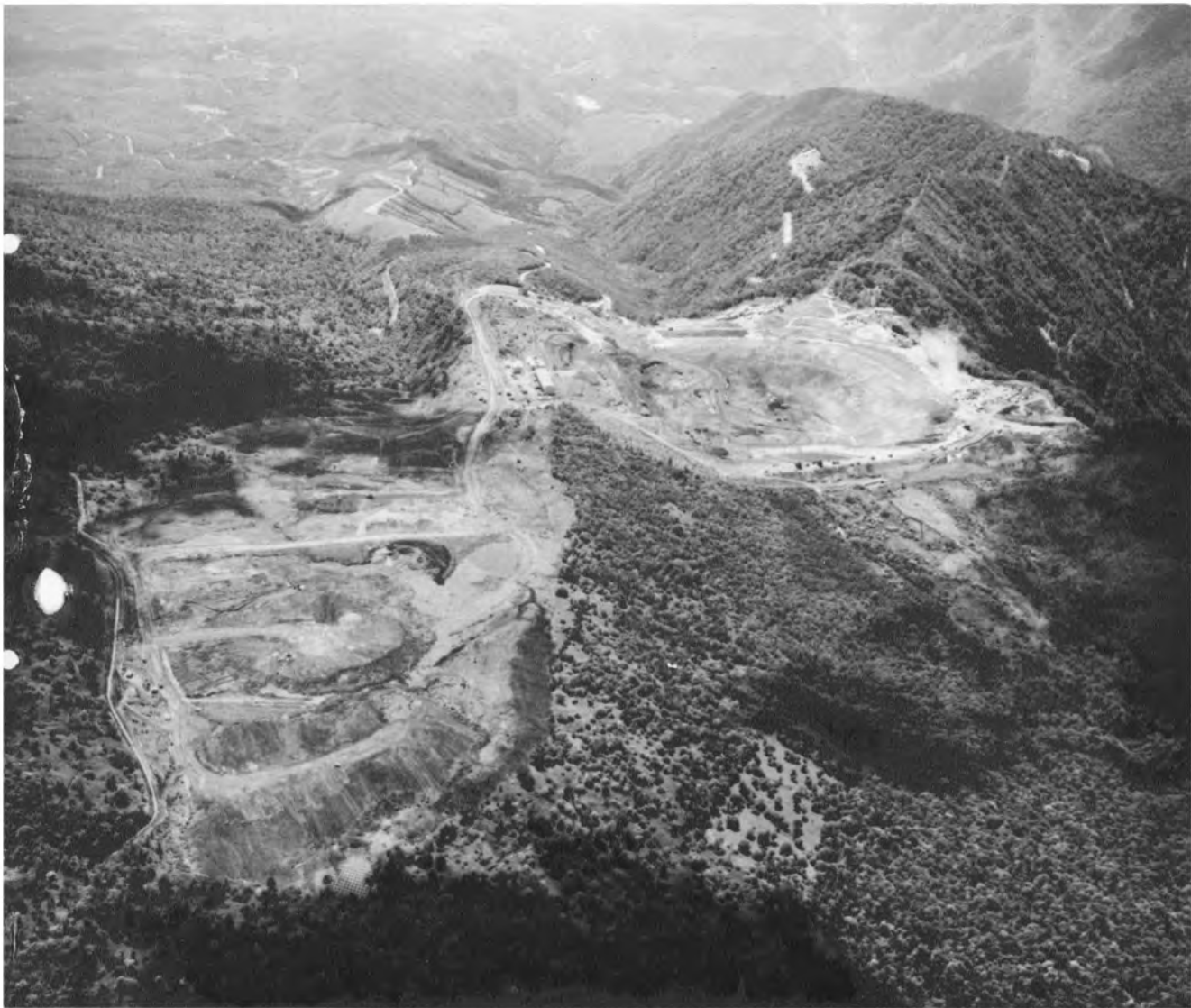
▲工事最盛期の土捨場および掘削中の貯水池全景 上流側は一部アスファルト舗装を開始、下流側は盛立中である。
