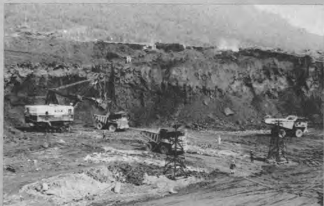
▲左岸上流湾曲部の土砂掘削
