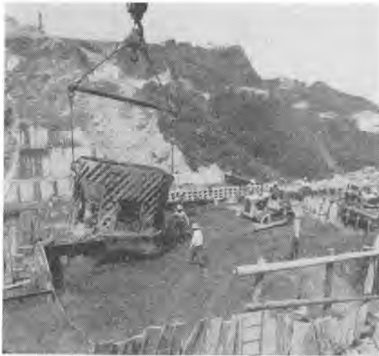
写真-2 コンクリートの打設状況
