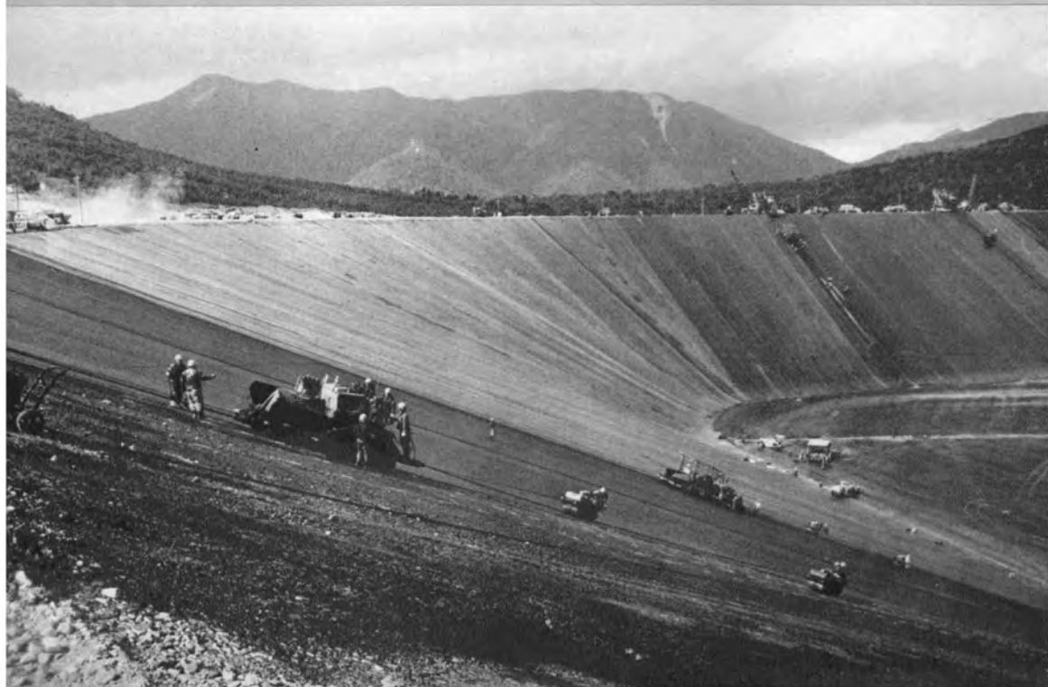
▼バインダ層の施工
