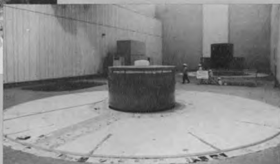
▲1号および2号発電機周囲のコン クリート打設（前方は1号風洞コ ンクリート、手前は2号バレルコ ンクリート）
