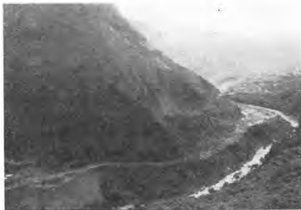
写真-3 岩屋ダム工事現況(ダム左岸)
