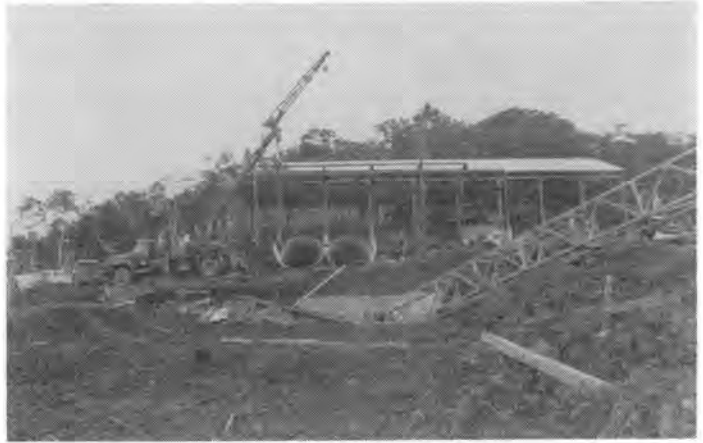
写真4 荷卸し停留場据付状況
