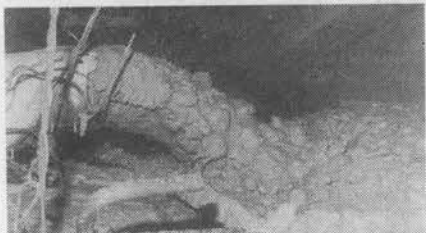
●アーチ内コンクリート打設に於ける連続吐出状況
