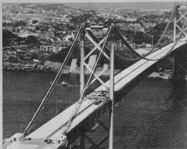
▲床版コンクリートの打設が完了した関門橋
