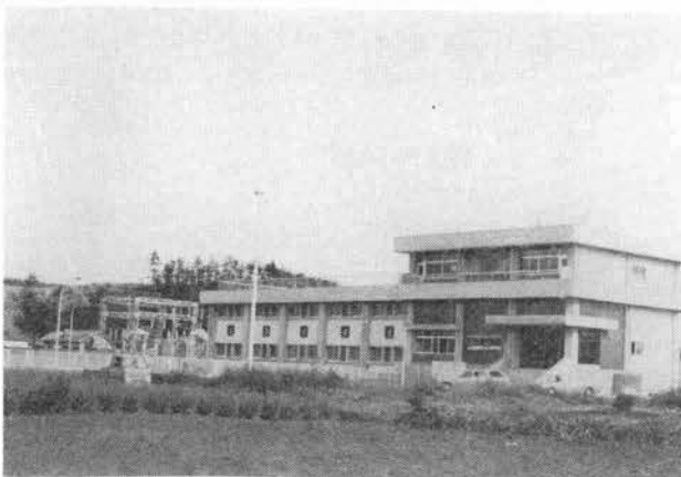
写真-2 船戸揚水機場
