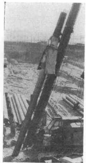
写真-4 ディーゼルハンマに取付けた消音器
