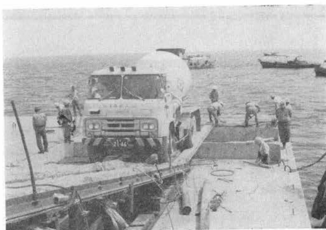
西防波堤延長工事(ケーソン蓋コンクリート打設)
