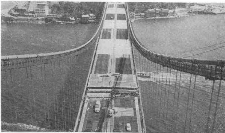
写真-5 床版コンクリートの打設
