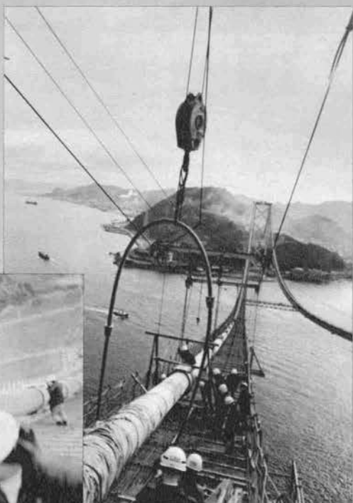
▲ケーブルバンドの溝にハンガー ロープを架設する
