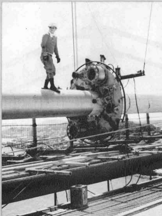
◀ラッピングマシンによるラッピング工事
