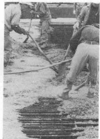
写真-7 継手部の打設
