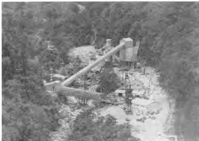
写真-1 万太郎谷工区坑外設備
