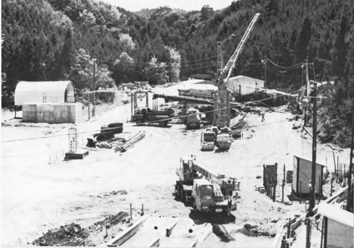
▲ 榛名トンネル (14,350 m) 御蔭工区坑外設備
