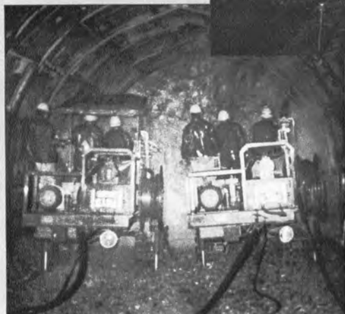
▲大清水トンネル保登野沢工区 (3,600m) 2ブームクローラジャンボによる 斜坑 (483m) せん孔作業
