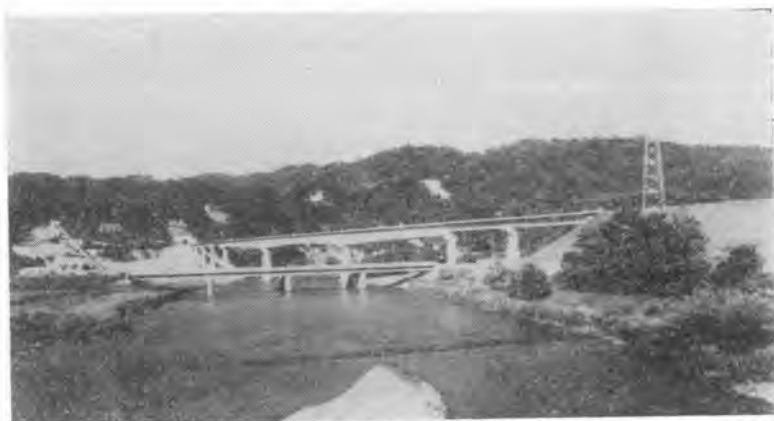
写真-1 夕張川橋梁
