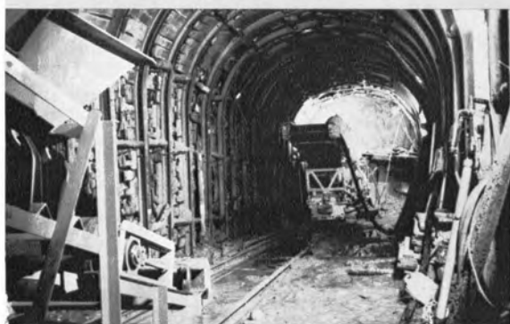
▼六日町トンネル (5,020m) 寺尾工区 サイロット導坑の切羽付近
