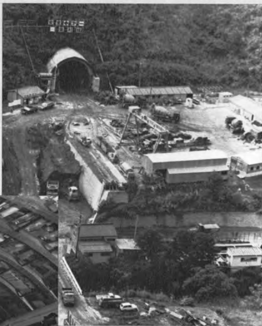
▲魚沼トンネル(8,624m)北工区 坑口付近
