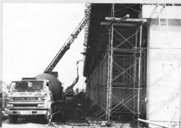
▲ 人見地区壁式高架橋 (l=95 m) 生コンクリートの搬送 (大宮始点47 k 000 m 付近)
