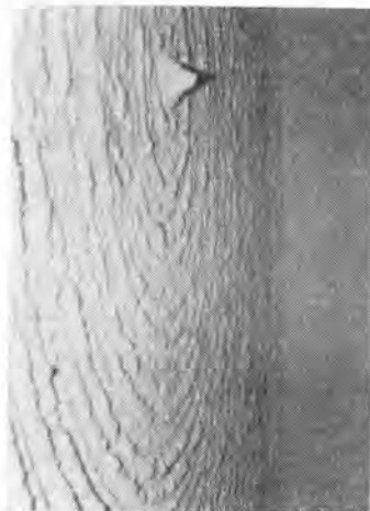
写真-4 凝灰岩の切羽掘削面
