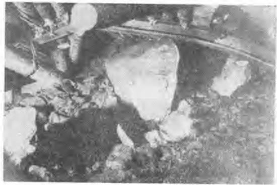
写真-5 安山岩破碎帯の状況
