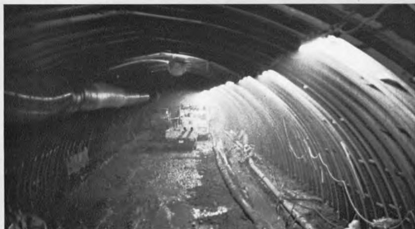
▲湯沢トンネル (4,440m) 北工区上部半断面部作業現場
