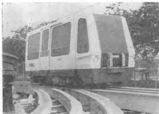
写真-2 新形式の VONA と分岐器 通動用、定員 30 人（座席 11、立席 19）
