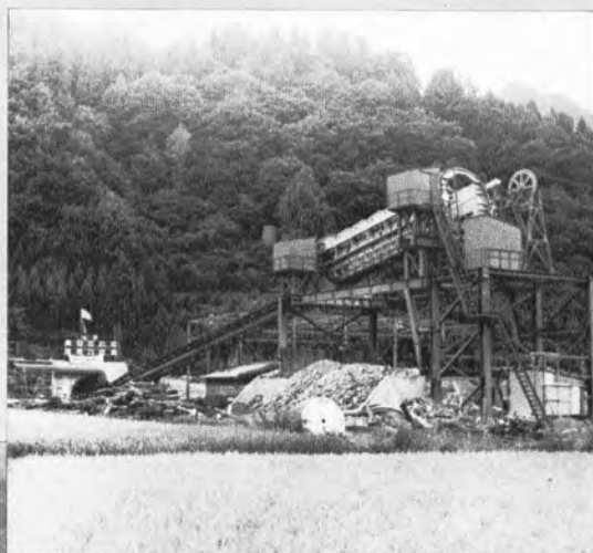
▲大清水トンネル松川工区 (3,300m) 松川斜坑 (632m) 坑外設備
