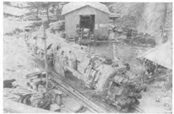
写真-9 T.B.M 350 G-1 本体引出し状況
