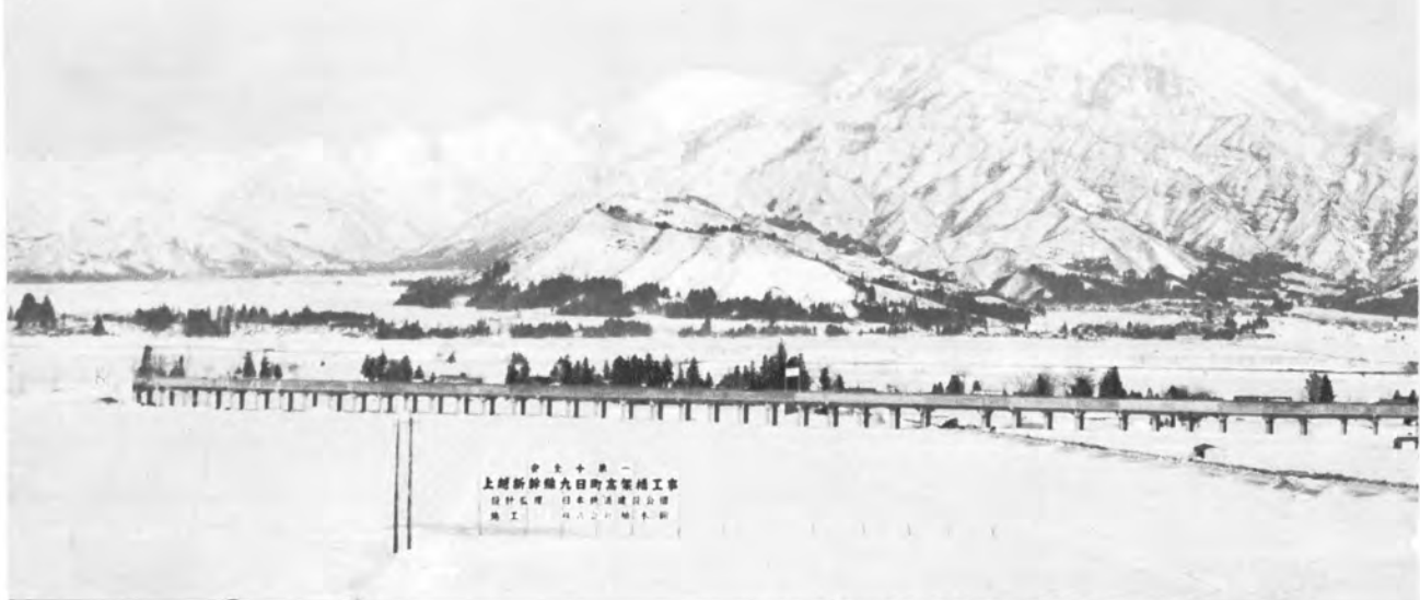
▲九日町高架橋（上越新幹線第1号の複線2柱式RCラーメン高架橋）大宮始点176k773m～177k747m 雪害対策実験線区
