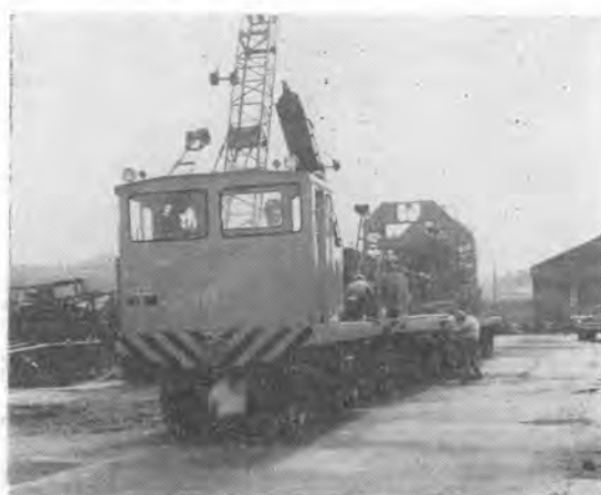
写真-5 工場内で組立中のスラブ軌道運搬車
