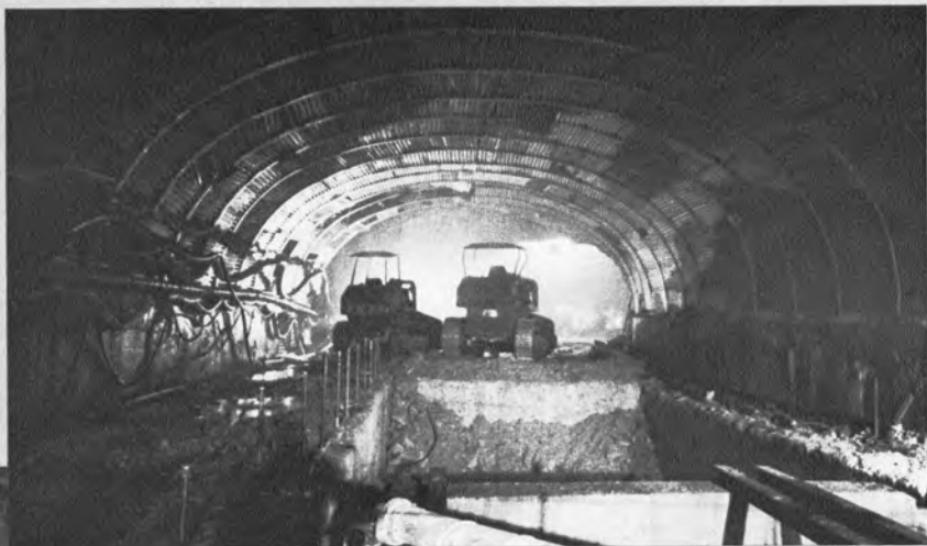
大清水トンネル万太郎谷工区 坑底のずりびん▶
