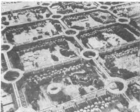
写真-4 G.A. ジェリコ：モートビア計画 5階建住棟の屋上を道路とし、地上を人の空間に解放した案で、モデル敷地はチームズ河川敷
