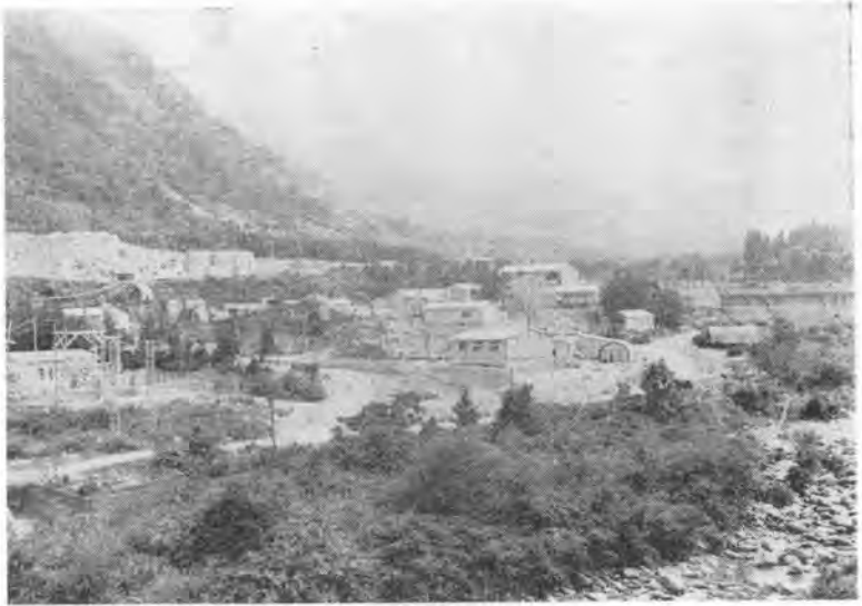
写真-2 仙の倉工区坑外設備
