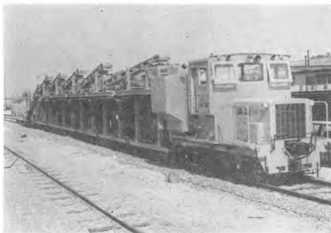
写真-6 移動式スラブミキサプラント装置
