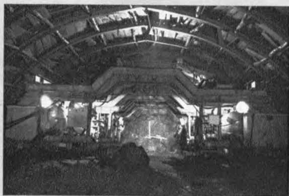
▲大清水トンネル仙の倉工区 上部半断面切羽付近 (ドリルジャンボ後方より)
