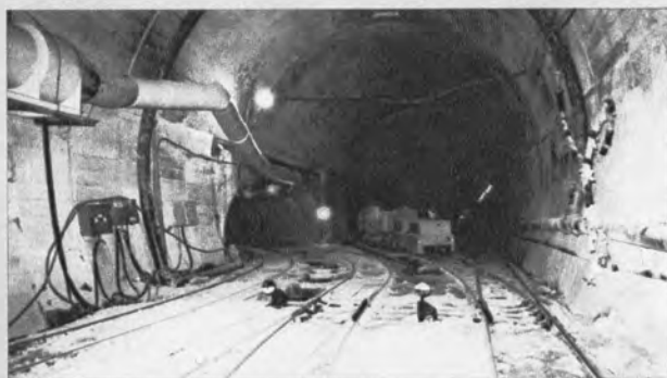
▲月夜野トンネル (6,470m) 森原工区 森原横坑と本坑 (サイロット工法) との交差部付近
