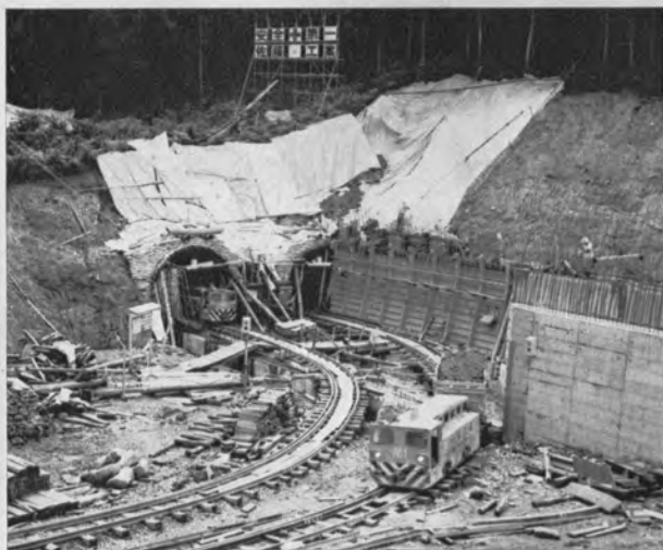
▲六日町トンネル北工区 サイロット工法と全断面 開削工法の境界付近 (大宮始点175 k 000 m)
