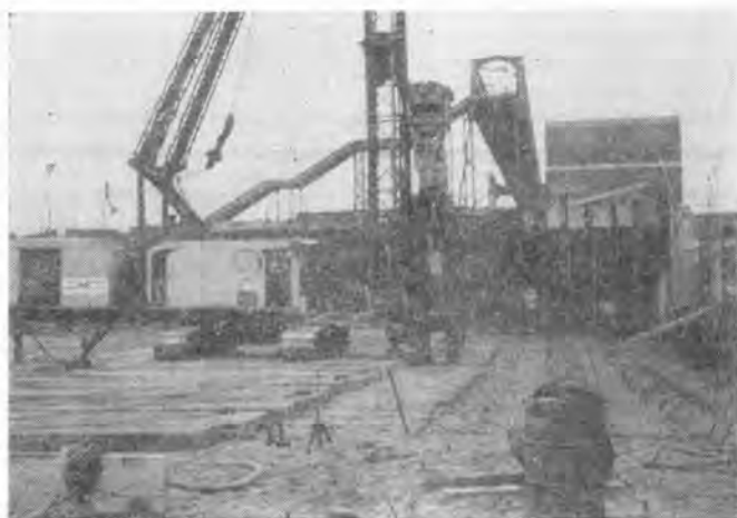
写真-1 施工状況
