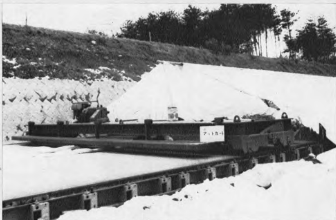
◀三角屋根テント車最後尾のマットカ ートで、このマットで湿潤養生に入 る。
