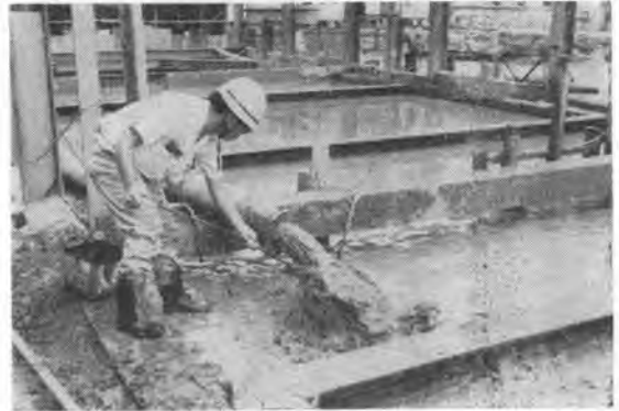
写真-3 泥水ピット
