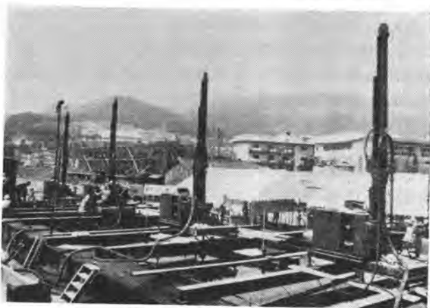
写真-4 大規模注入状況 プラントから送られたモルタルはこの写真に示す型わく上の注入管引上げ装置を通じて骨材中へ送り込まれる。
