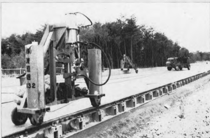
◀翌日作業のための型わくとレールの 設置に用いるピン打ち機械
