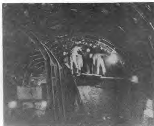
写真-1 中央道恵那山トンネル導坑掘削
