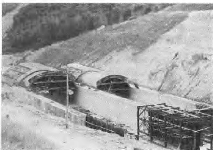
写真-2 中国道美祿～小月間根越峠のアーチ形コンクリートボックス
