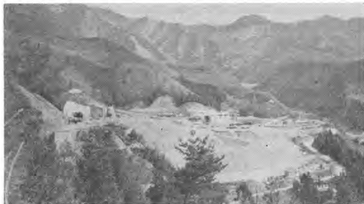
写真-1 本線トンネル西坑口(左側中央)
