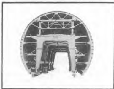
新幹線全断面スチールフォーム
