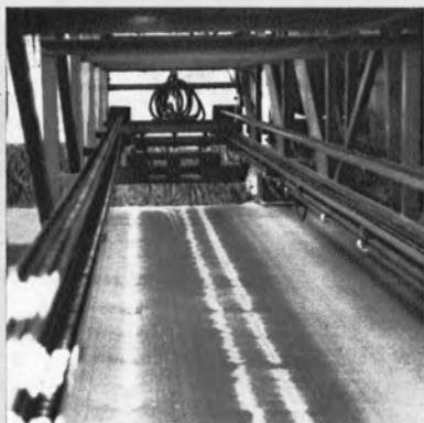
▲被膜養生用ビニール乳剤散布機（千葉機械工業製） 向う側に見える三つのノズルからビニール乳剤が噴射され、 粗面仕上げの終わったコンクリート面に被膜をつくる。
