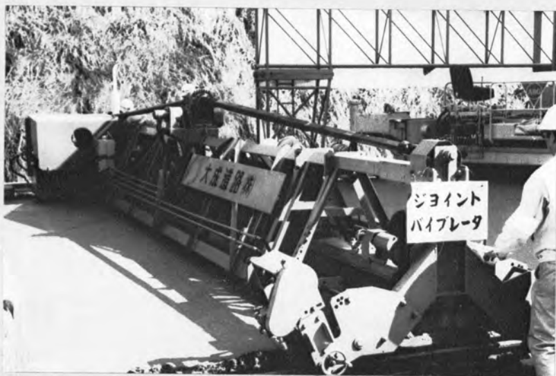
▲振動目地切り機（西ドイツABG社製FVD460） 重量2.5t、4,100rpm、振動するスチール板で打込目地のアスペ スト板を挿入するすき間をつくる。
