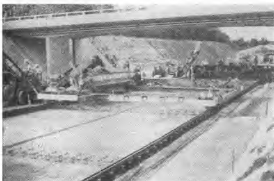
写真-3 ABG 社製ボックススプレッダによる下層コンクリートの敷きならし
