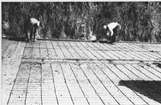
▲鉄網の敷設と端部3本の縦筋にD13の補強筋を緊結する作業状況で、縦目地の入る中央部分は20cmのすき間があいている。
