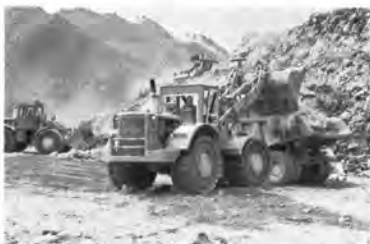
黒川ダムでロック材積込み中の988クッショントラックローダ
