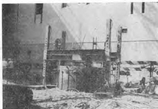
写真-6 油圧スラストジャッキによるスタンドパイプの引抜き
