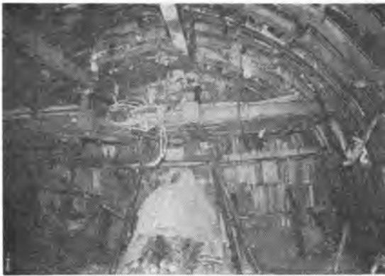
写真-11 斜坑の全面鏡張り
