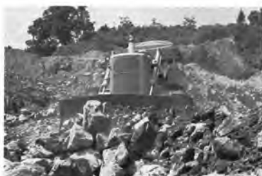
黒川ダムで稼働中のD8Hブルドーザ
