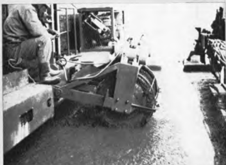
▲タイバーインストラー (特殊電機製) 円筒についた溝を利用して1m長さのタイバーをコンクリート中に押し込む。
