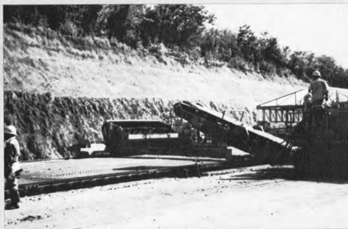
上層用コンクリートベルトブレッサ▶ 川崎重工製、機関いすゞDA220、 重量約10t、50.5PS/1,600rpm、 ベルトのコンクリート供給量最大 350m 3 /hr 向うに見えるのは上層用ボックスス ブレダである。
