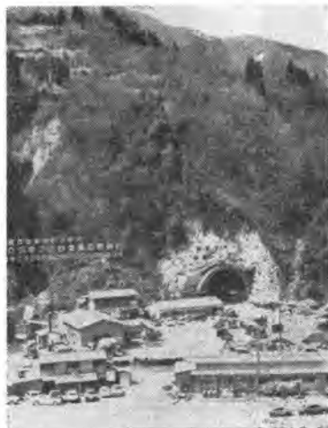
写真-2 本線トンネル東坑口
