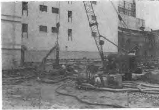
写真-1 S 300 機による掘削
