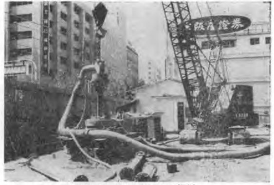
写真-2 L-2S 機による掘削
