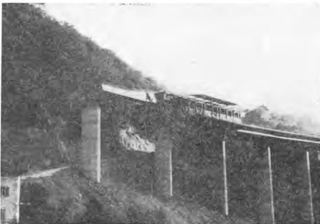
写真-4 Brenner 橋移動つり支保工
