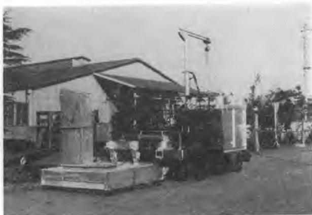
写真-5 直接加熱式ロードヒータ（日本舗道製、自走式）
