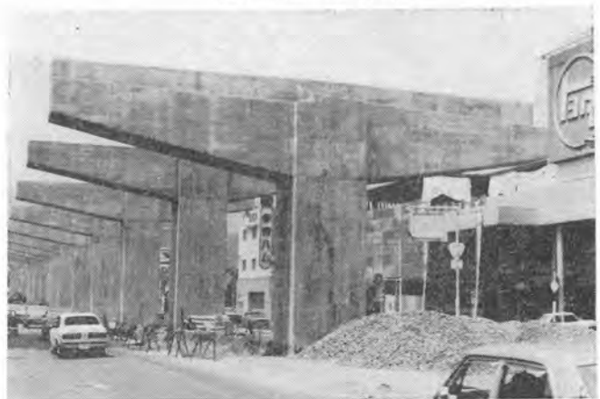
写真-6 回転を完了した橋脚はり
