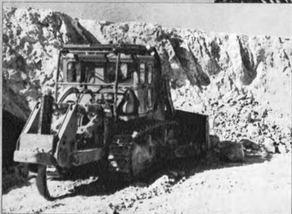
▼D355Aブルドーザによる 切羽の整理作業
