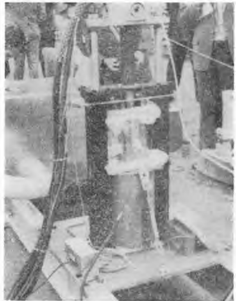
写真-4 シュブテレーネを圧入装置で地盤に押込む実験の状況
