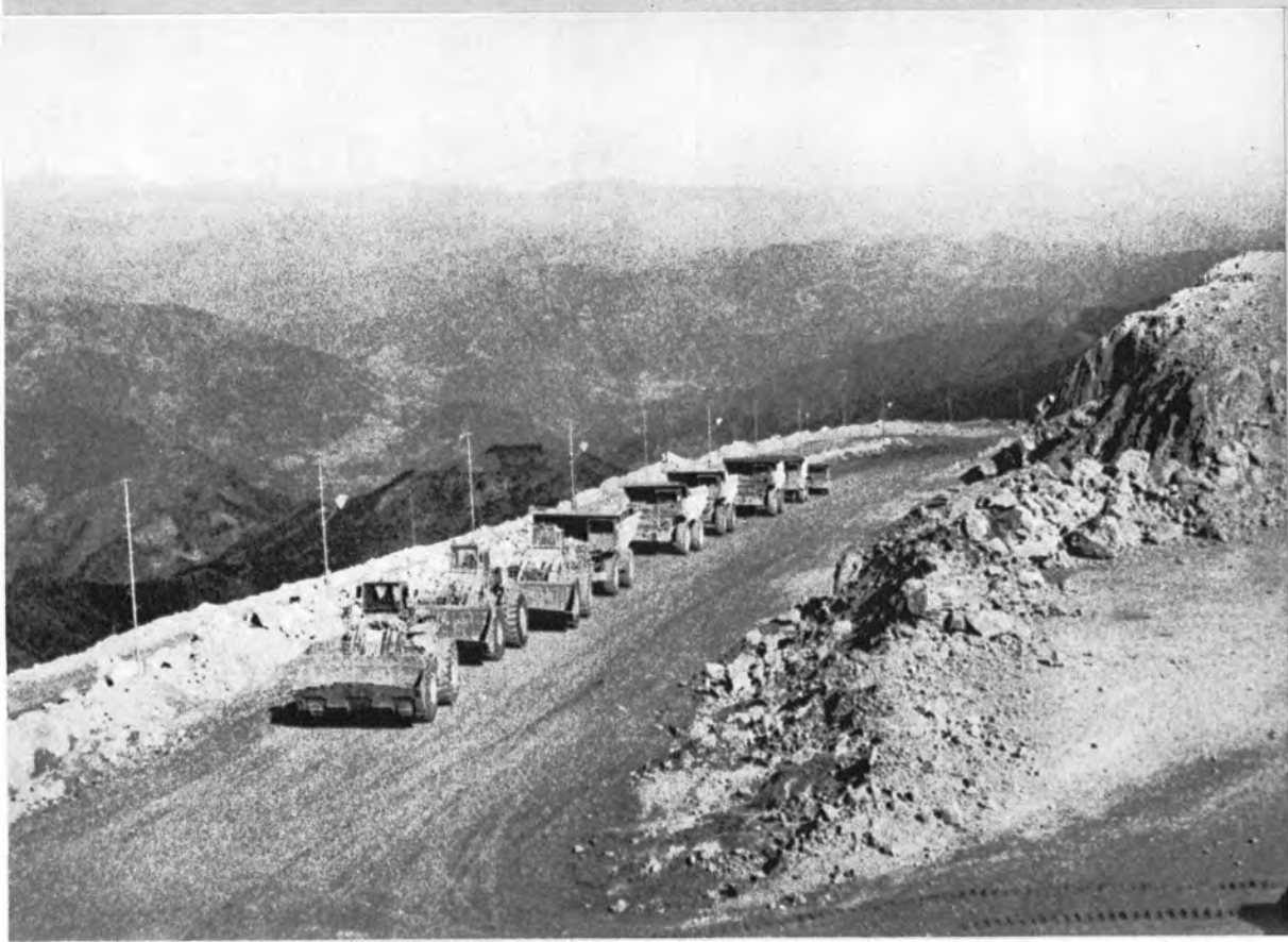
▼ 切羽に進入するため粗鉱運搬道路を通過する大形重機
