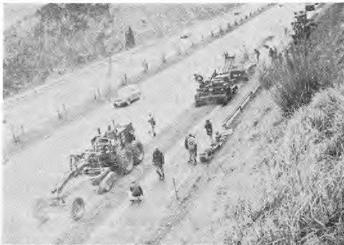
写真-4 高速道路における施工例（ロータリカッタおよびローダ）
