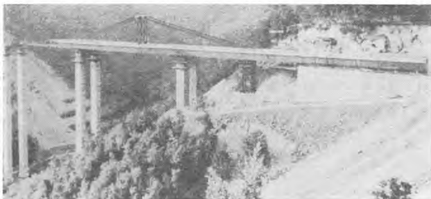
写真-6 Semorile 橋 (押し出し工法)
