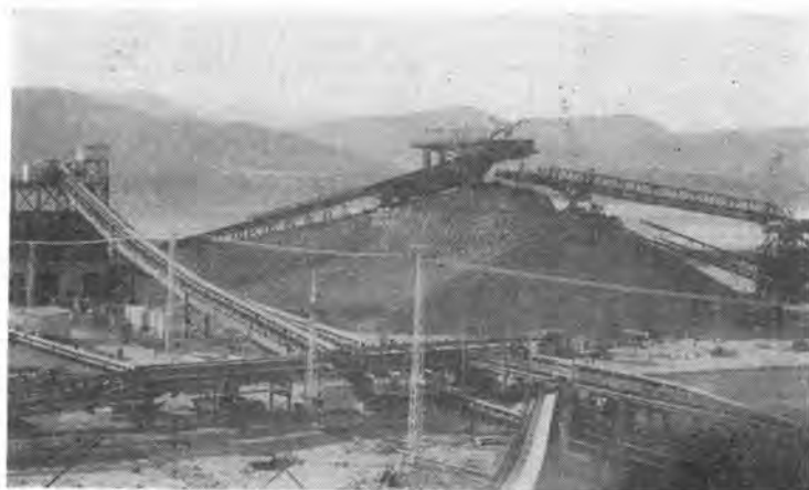
写真-3 右岸より MC 6ab ベルトコンベヤの最初の築堤を見る
