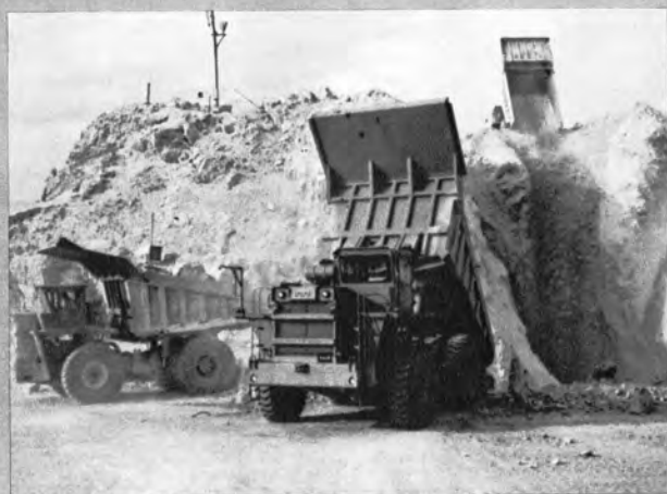
▲ 立坑投入口におけるダンプトラック
