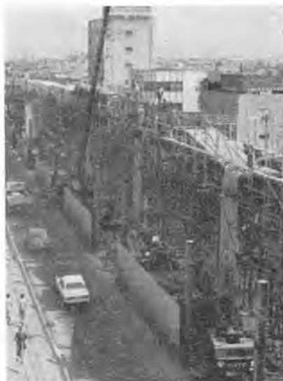
写真-2 はり製作状況
