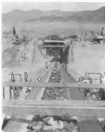
写真-2 P-1 の投入ホップ引出しベルトコンベヤ
