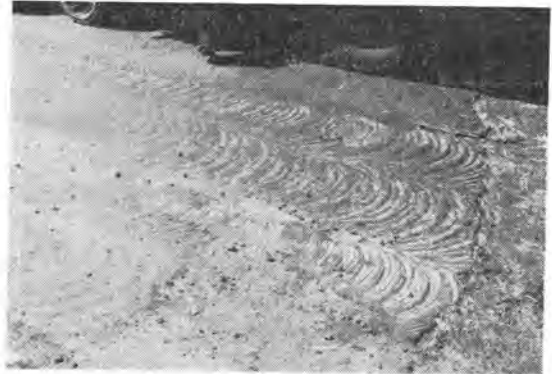
写真-3 平面フライスカッタで切削後の表面
