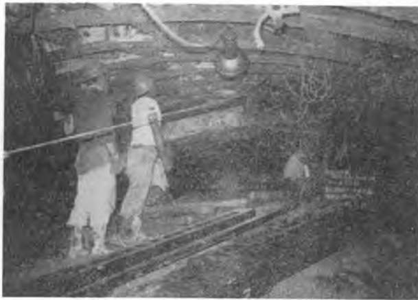
写真—4 新しいメッセル矢板の設置と発進基地
