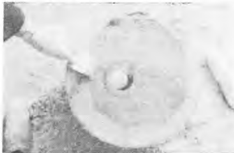
写真-2 軟岩に施工されたスムーズなガラスライニング孔の状況
