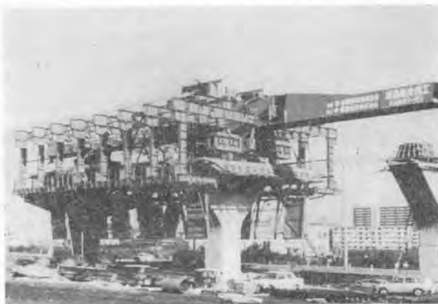
写真-7 首都高速 SSM 式移動つり支保工
