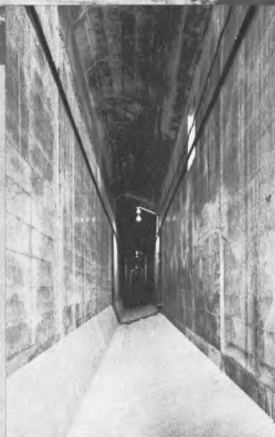
▲エレメント内部のダクト路
