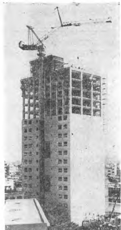
写真-5 施工中のジブスネーク形タワークレーン (K-100 形)
