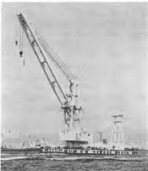
写真-2 50 t/100 t 旋回式クレーン船 (函館ドック)
