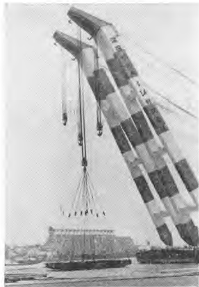
写真-3 3,000 t ぶりクレーン船 (石川島播磨)
