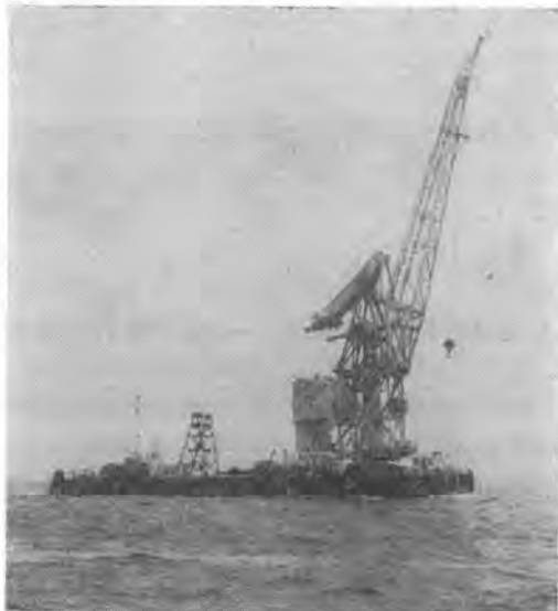
写真一 60t づり旋回式自航クレーン船 (石川島)
