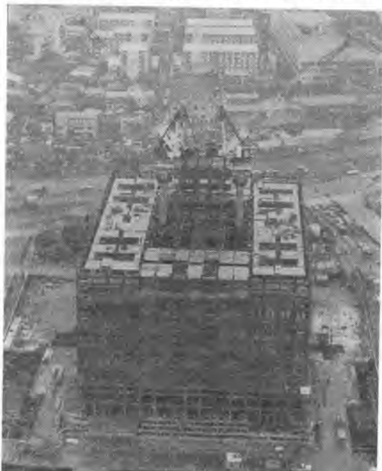
写真-1 超高層ビル工事で使用中のタワークレーン (K-350H)
