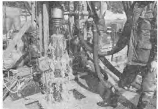
写真-1 OD 機によるさく孔作業
