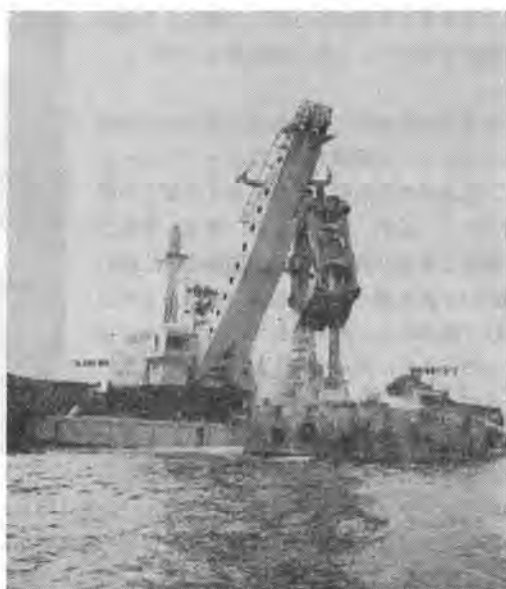
写真-2 浚渫作業中の大形グラブ浚渫船
