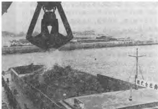
写真-4 大形グラブ浚渫船による硬土盤浚渫作業
