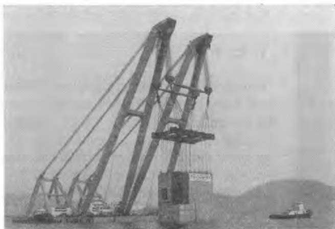
写真-4 3,000 tブリクレーン船(住友重機械)
