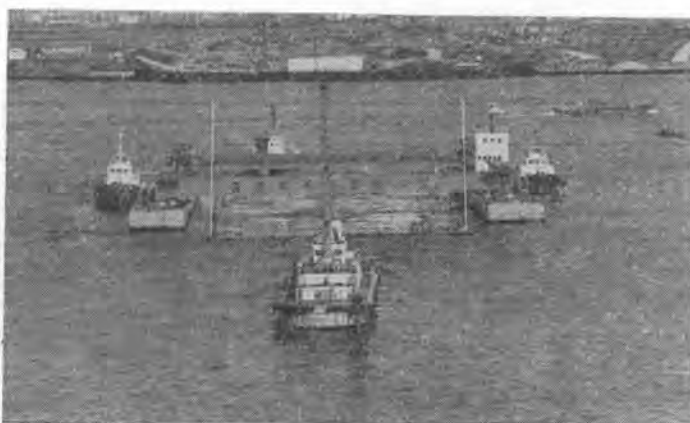
写真-1 沈設作業中の沈設バージ
