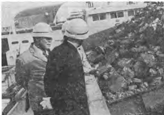
写真-3 大形グラブ浚渫船で浚渫した岩盤
