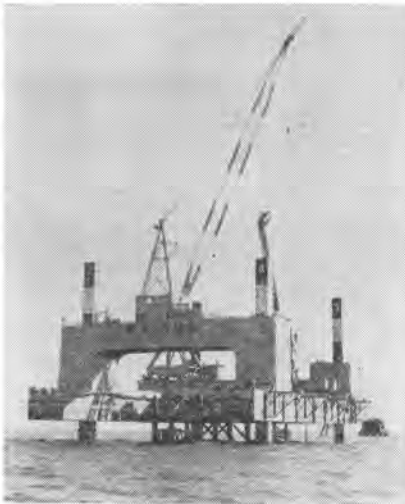
写真-2 特殊自己昇降式海上足場 SEP KAJIMA
