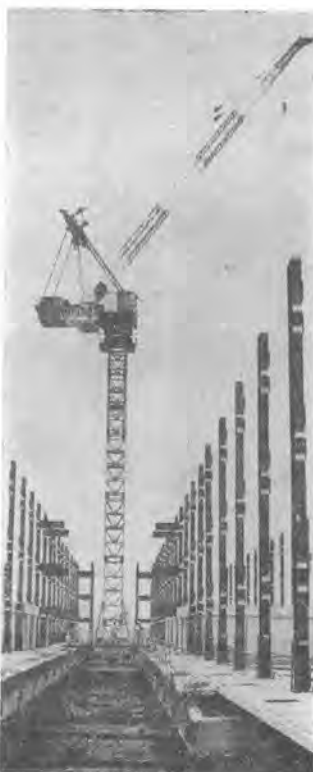
写真-3 施工中の走行式ジブ起伏形タワークレーン
