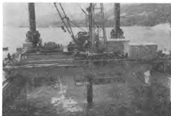
写真-3 MSEP-1 によるさく孔作業
