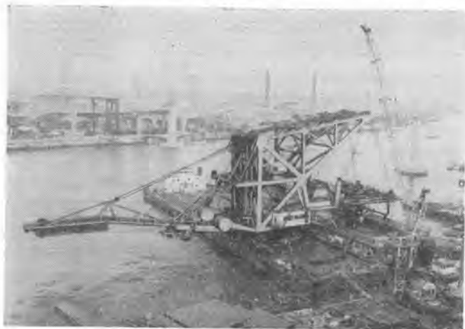
写真-1 揚土作業船“神揚”
