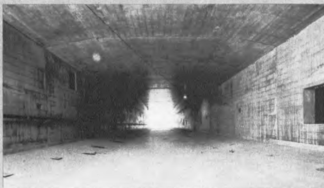
▲ドック内で完成したエレメント内部（車道）
