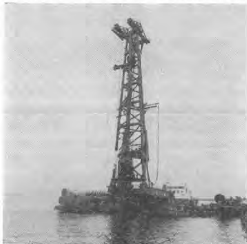
写真-1 第十大成丸による \phi 2,500 \times 145 m 鋼管くいの打込み
