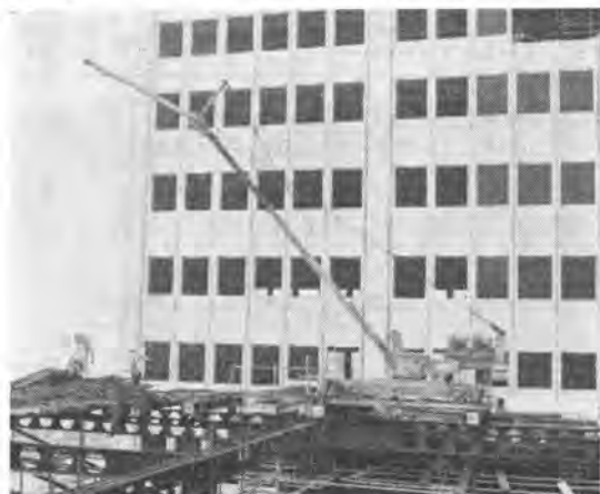
写真-9 施工中のジブクレーン (E-16 形)
