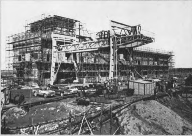
◀ 走行用クレーンおよび建家工事
