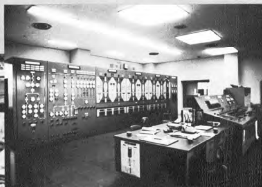
▲ポンプ場操作室
