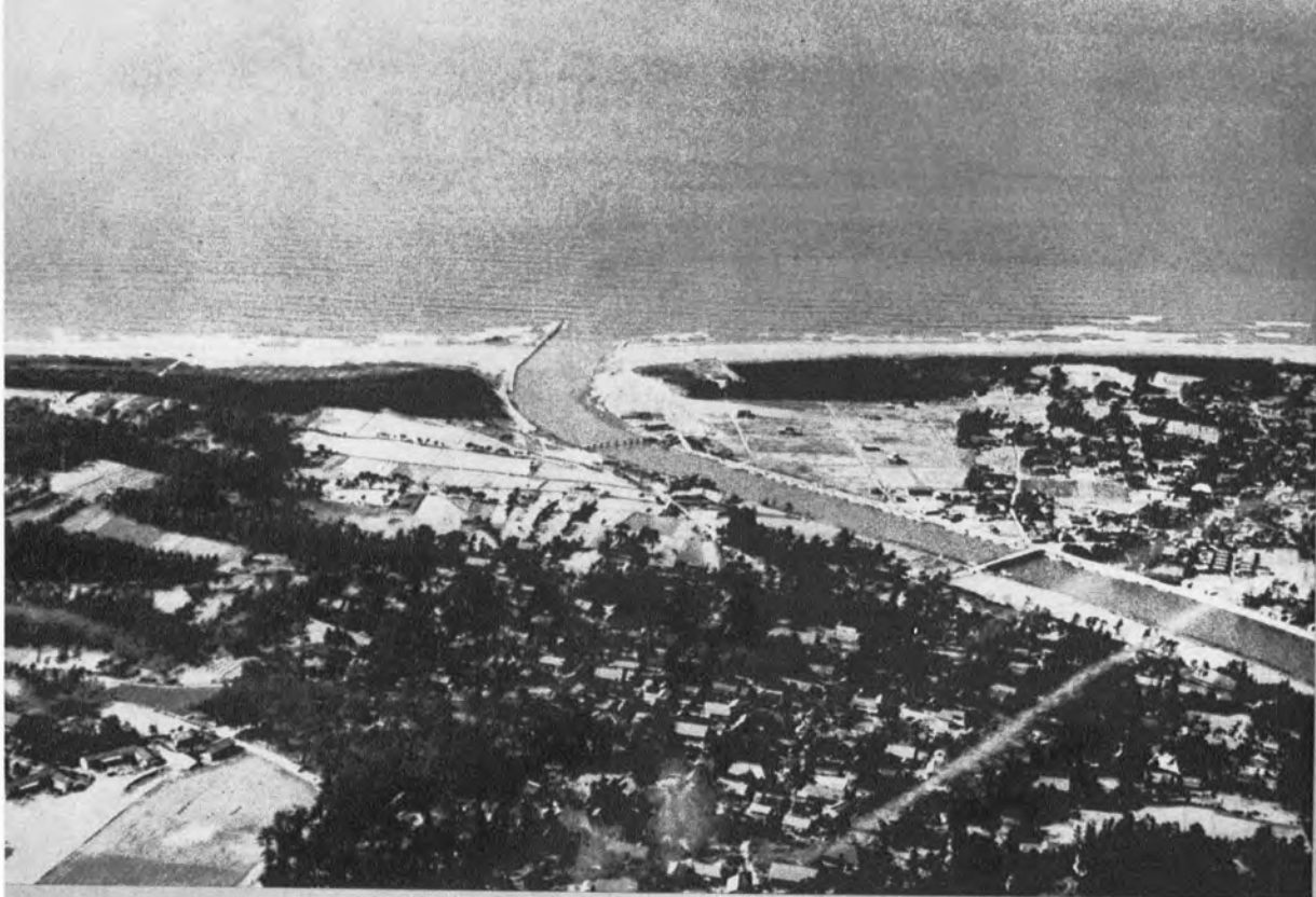
▲着工前の全景
