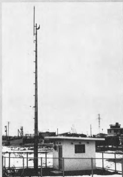
▲ 排水制御施設雨量観測所
