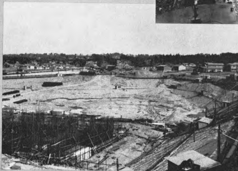
▲機場基礎工事（ウェルポイント3段）
