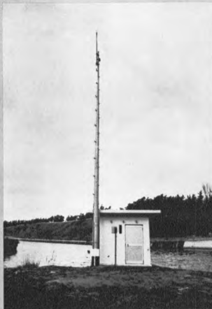
▲ 排水制御施設水位観測所
