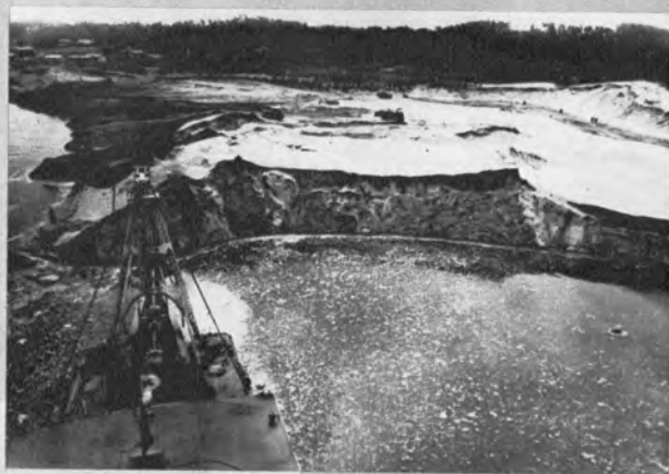
▲機場基礎掘削工事
