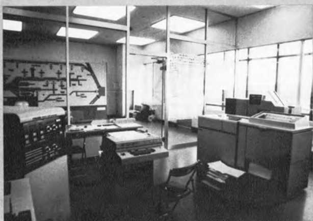
▲ 排水制御用コンピュータ室と操作室
