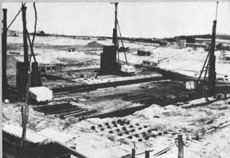
ポンプ場の囲矢板基礎工法▶
