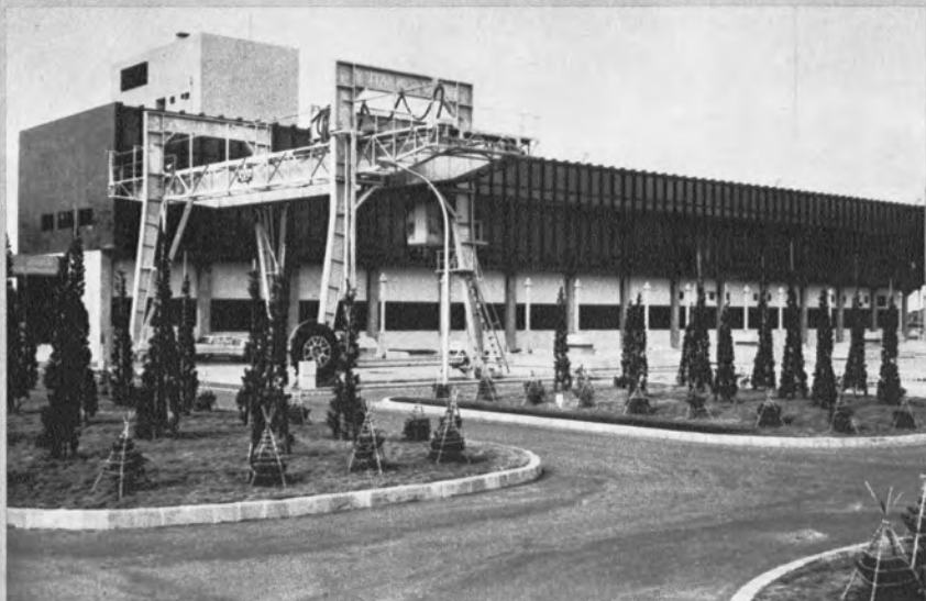
◀ 屋外走行クレーンと 機場前庭
