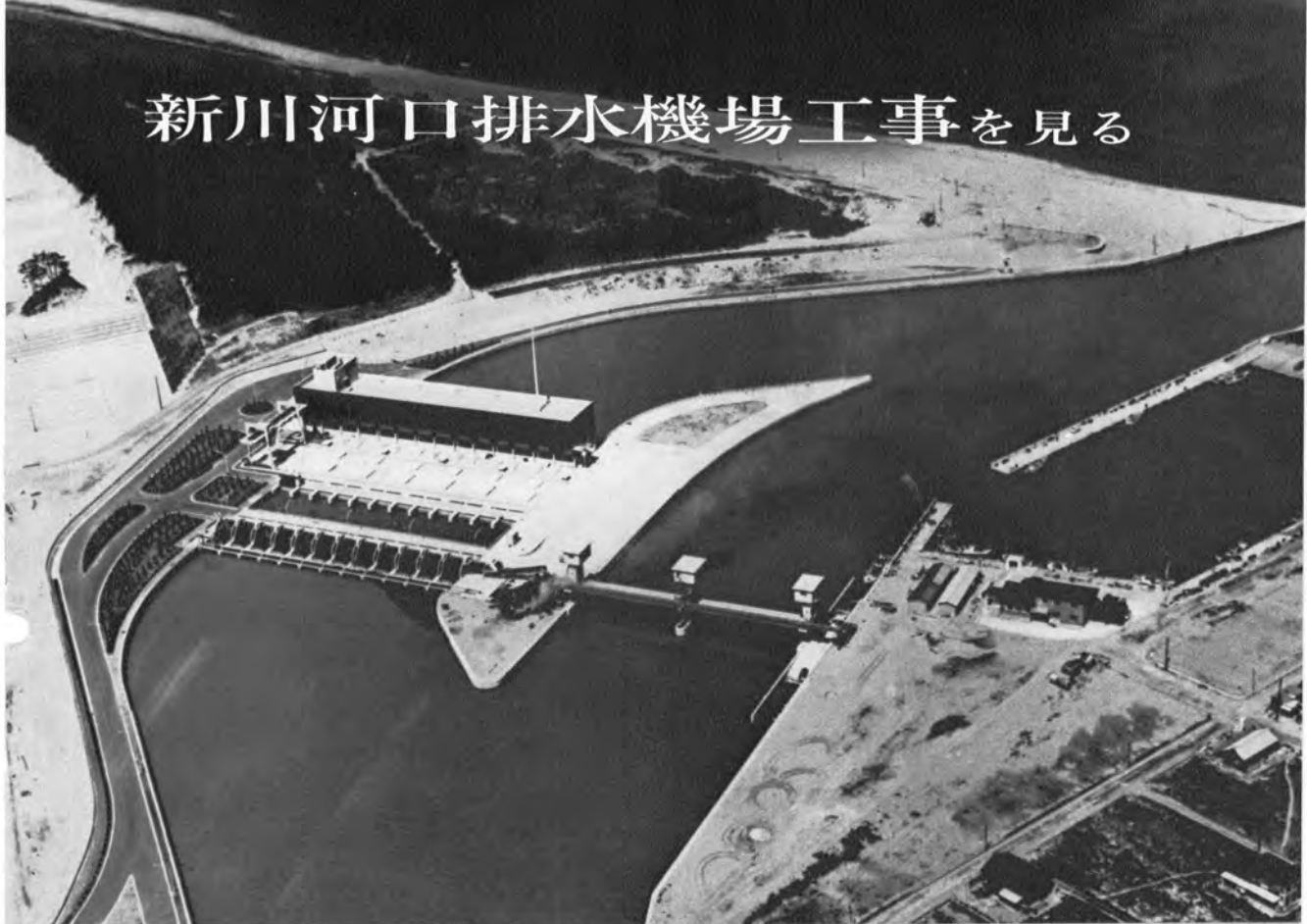
▲河口機場と自然排水樋門
