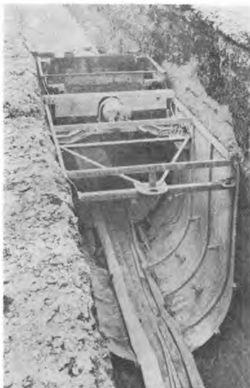
中央がスリップフォーム、その後方が打設された排水管、手前が膨張前のインフレイトフォーム
