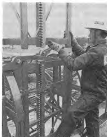
写真—19 ラック式工事用エレベータのマストの継足し作業（マストジョイント）
