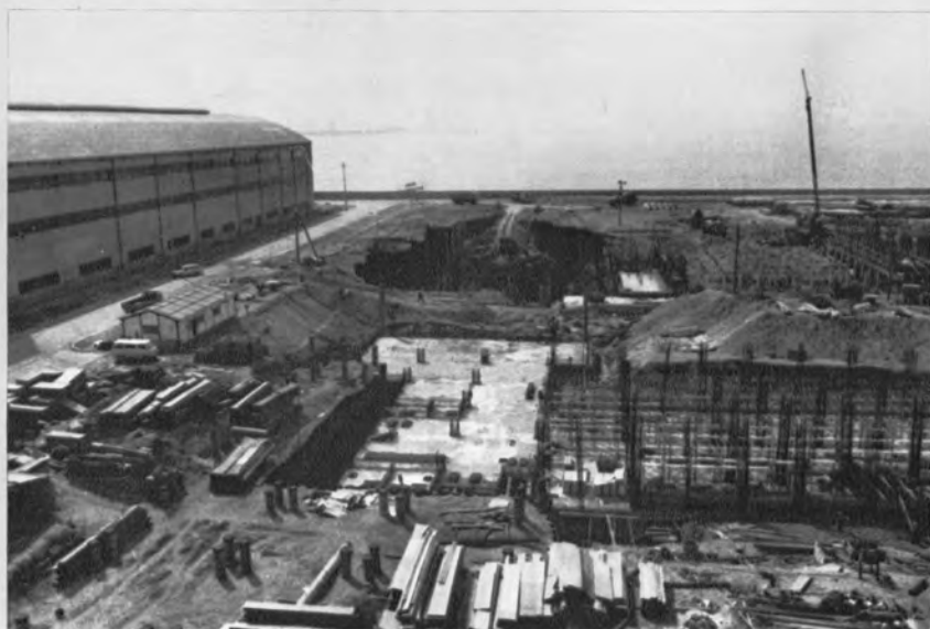
▲終末処理場工事現場全景ー丸亀市ー
