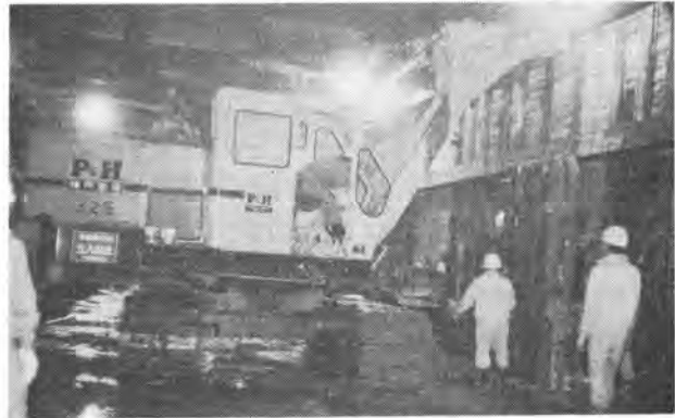
写真-3 HB 掘削機
