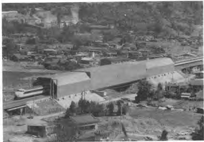
写真-5 新幹線騒音対策・葛川橋梁防音覆い工事
