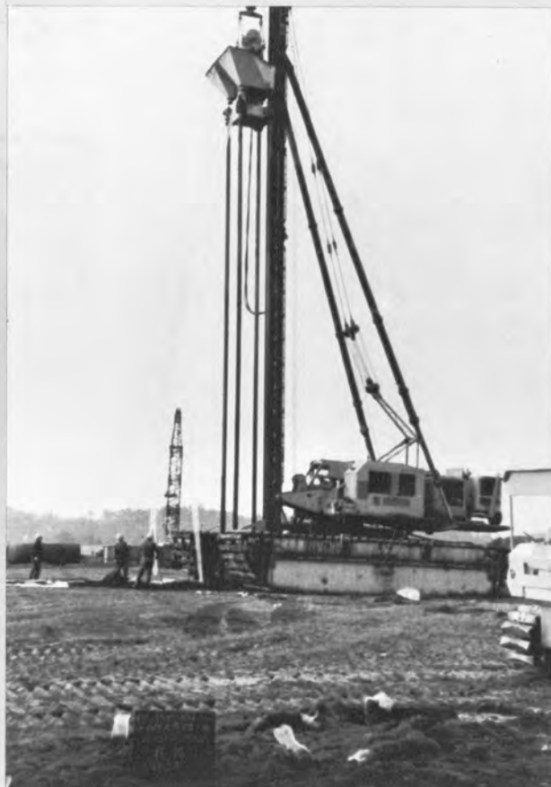
バックドレーン工法による砂の打込作業▶ —東松山市終末処理場—
