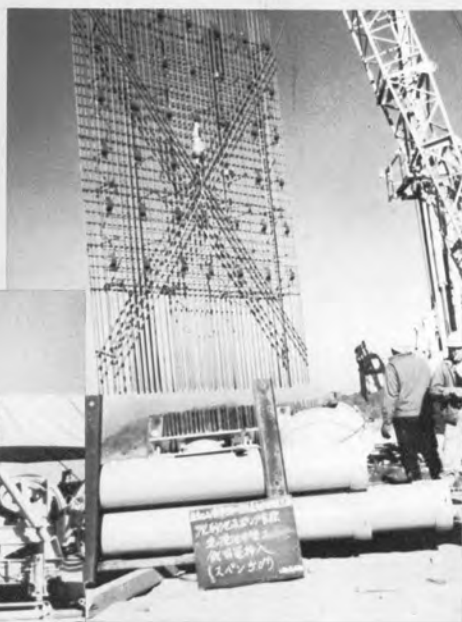
▲連続地中壁工鉄筋挿入 (スパン 5 m) —東松山市終末処理場—
