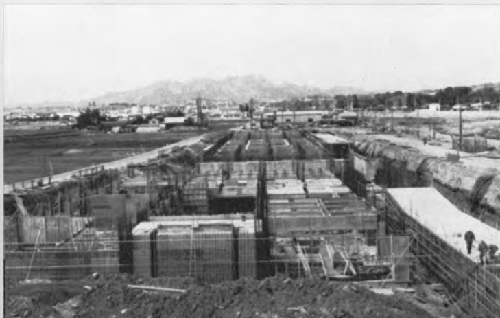
手前より沈砂池、ポンプ井、最初沈殿池、エアレーションタンク、最終沈殿池 ー鹿沼市黒川終末処理場ー▶
