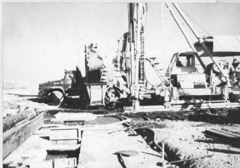
▲連続地中壁打設のためのエルゼ掘削機による掘削作業 —東松山市終末処理場—
