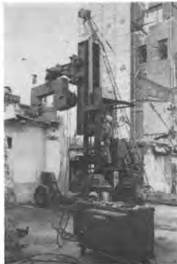
写真-10 壁・柱破壊機の作業状況
