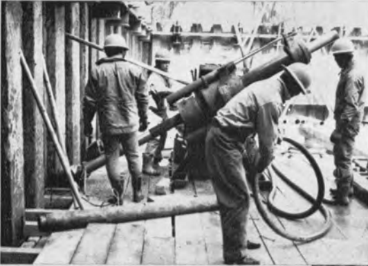
▲ 終末処理場のアースアンカー ボーリング作業 — 蒲都市 —
