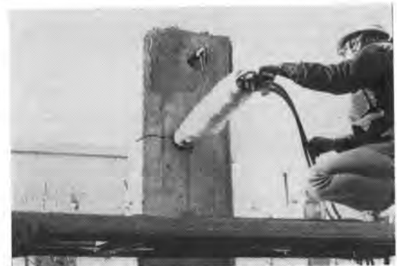
写真-7 油圧式ロックスプリックによる柱の破壊
