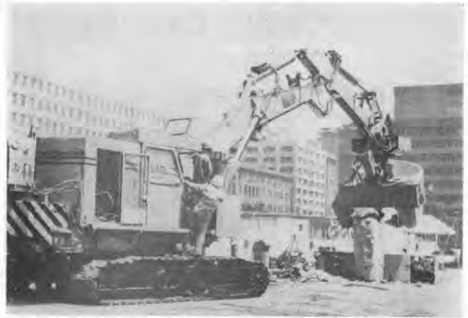
写真-4 国鉄形油圧式コンクリート破壊機の作業状況
