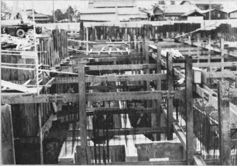
◀ 中継ポンプ場の地下部分工事 — 蒲都市城山 —
