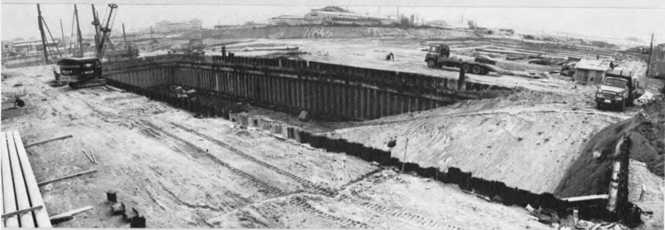
▼ 沈砂池、ポンプ井工事の仮設工で、 左後部は最初沈殿池 — 蒲都市終末処理場 —
