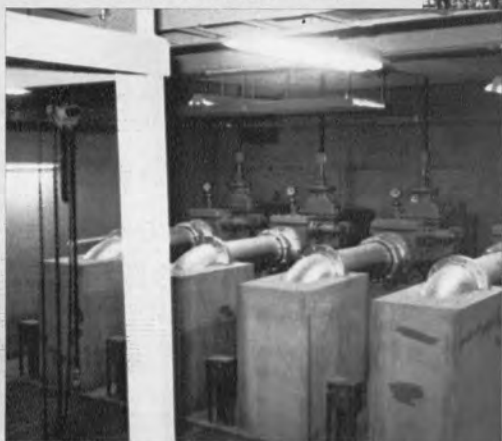
▼300mm水中汚水ポンプ室内 ー川越市月吉中継ポンプ場ー
