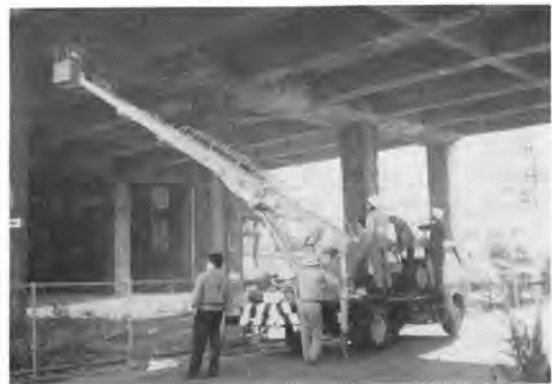
写真-2 はしご車による点検作業
