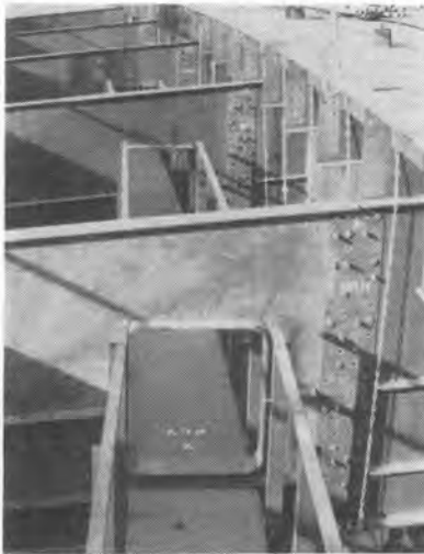
写真-3 検査通路 (架設中)
