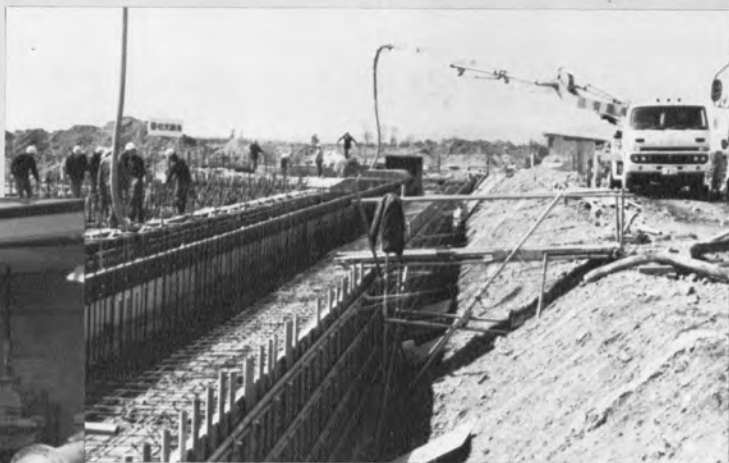
▲最終沈殿池のコンクリート打設作業 ー小山市終末処理場ー
