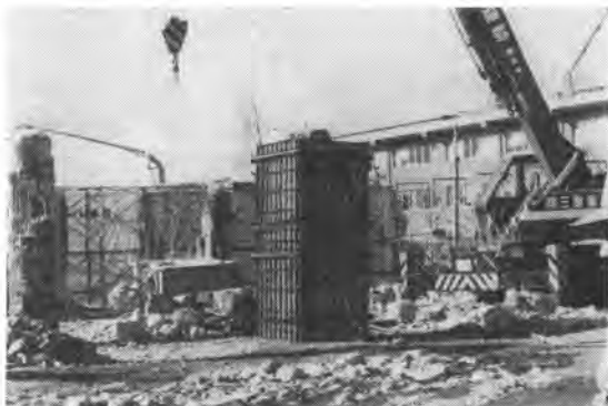
写真1 防音壁の外観
