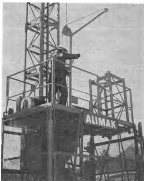
写真-18 ラック式工事用エレベータのマストの継足し作業（マスト荷役）
