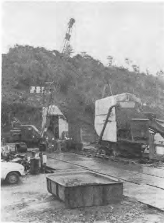
写真一 鉄筋かごつり込み中のOWS掘削機(左)とSoletanche掘削機(右)で、手前にあるのが排土コンテナ
