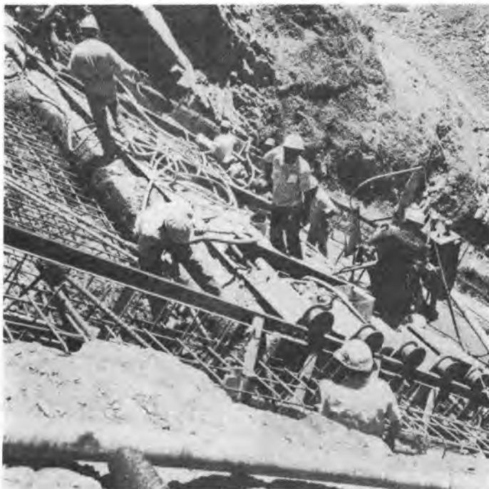
スリップフォームによる急斜面上でのコンクリート打設
