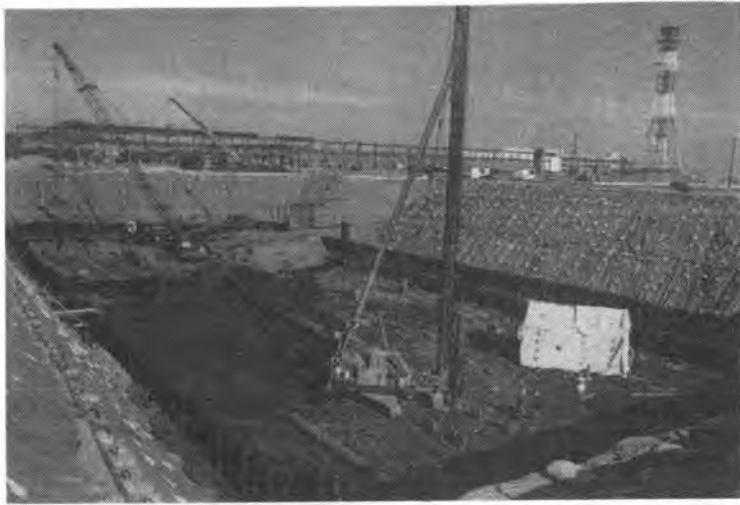
写真-2 スクリーン・ポンプ室掘削完了
