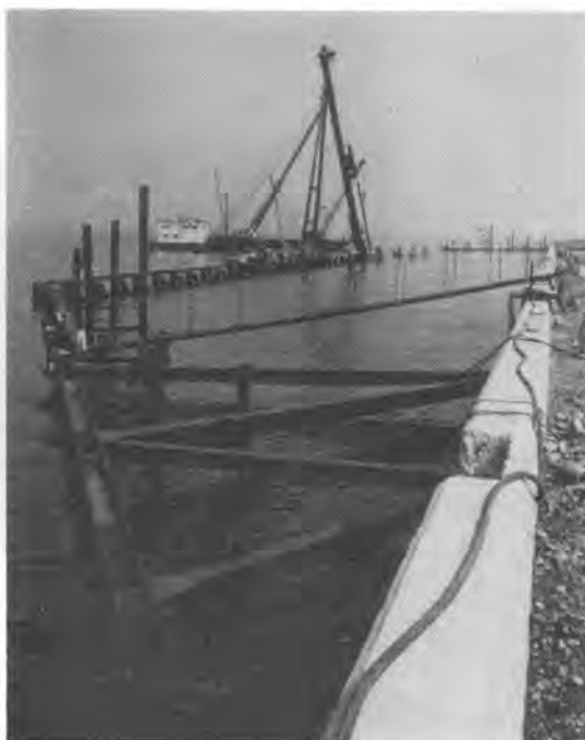
写真-1 カーテンウォールくい打ち状況
