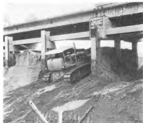
写真-3 ブルドーザによる撤去作業
