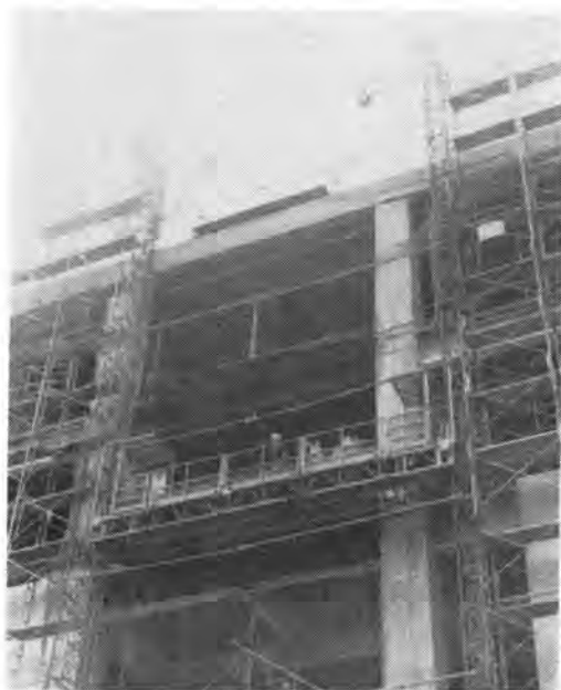
写真-20 使用中の長物エレベータ (HSL-1200 D 形)
