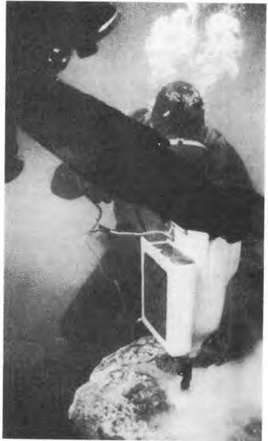
海深 33 m で使用中の 水中せん孔用油圧さく岩機
