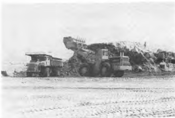
写真-2 ダンプとタイヤショベルによる撤去作業
