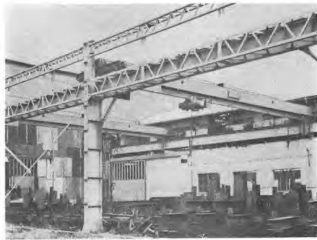
写真-21 使用中の電動ホイスト（ローヘッド形）
