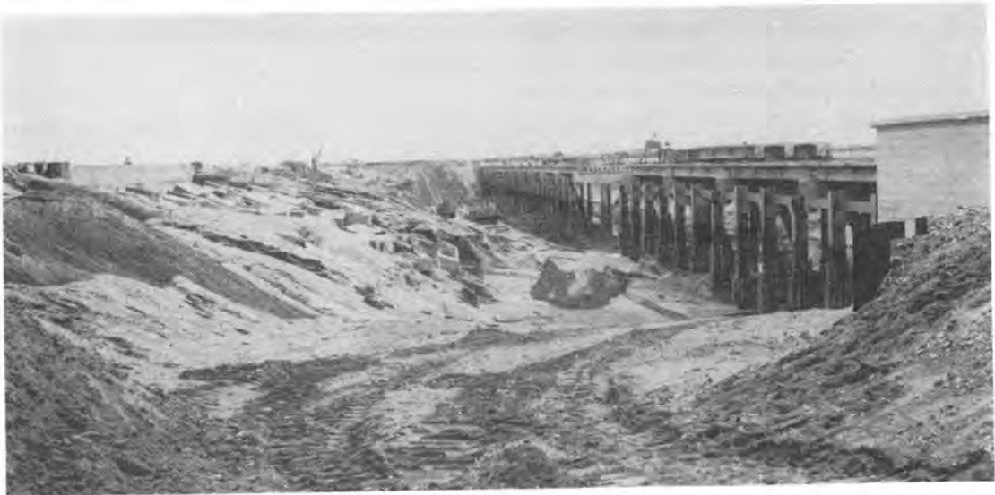
写真-1 防波堤の撤去状況
