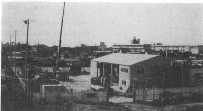
写真-1 ヘドロ処理パイロットプラント
