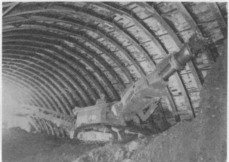
写真-3 ロードヘッダ 三井三池製作所 MRH-S 45, 45 kW (上越新幹線浦佐トンネル, 延長 2.0 km, 上部半断面掘削, 五洋建設施工)
