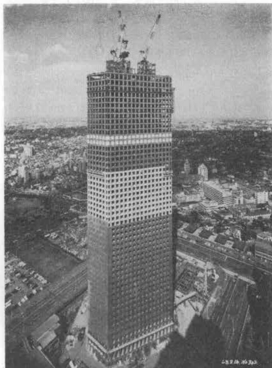
写真-1 工事中の新宿住友ビル
