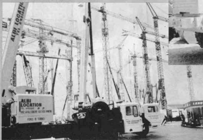
▼ 林立するタワークレーン・ハノーバーメッセ
