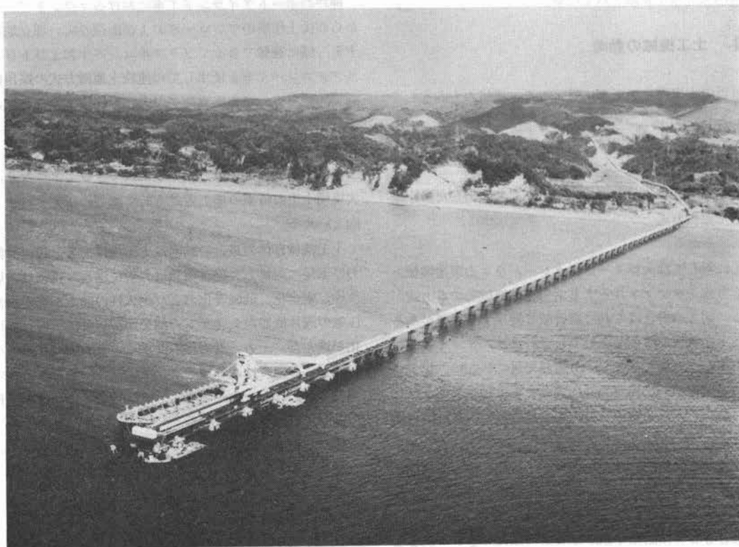
写真-1 海に伸びる大土工コンベヤおよびシップローダ(時間5,000 m^3 の積込能力)―千葉県浅間山工事―
