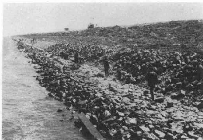
写真-6 Markerwaard 築堤石張り工事 (オランダ)
