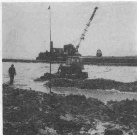
写真—5 Markerwaard 築堤工事 (オランダ)
