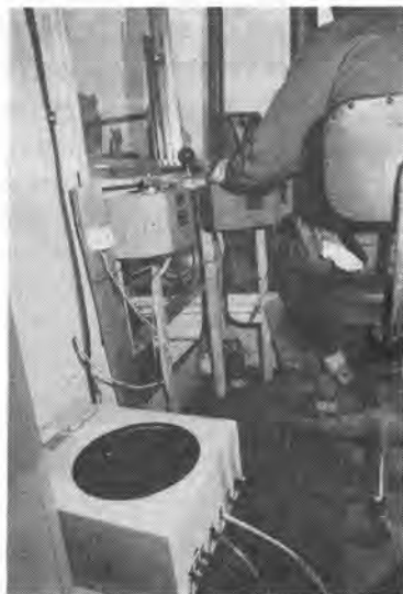
写真-5 運転室内に設置された A.B.L 装置
