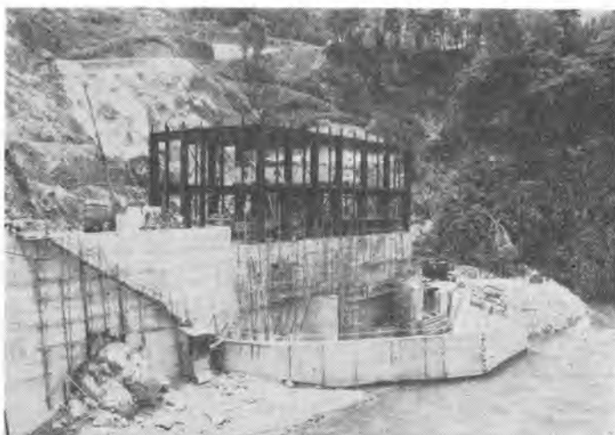
写真—4 新成発電所発電所工事状況（昭和 49 年 5 月）
