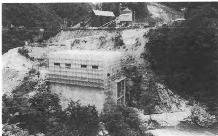
↑ 写真-1 新椿原発電所発電所地点 全景（昭和 49 年 5 月）
