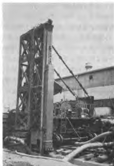
写真-11 TM 掘削機
