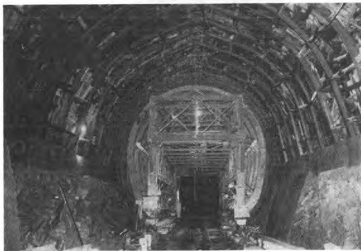
← 写真-2 新椿原発電所圧力導水路 トンネル巻立状況（昭和 49 年 6 月）
