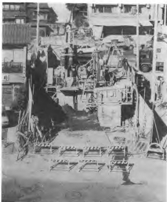
写真-1 市街地における汚水処理（地下連続壁工事）
