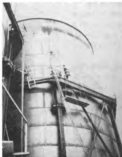
写真-6 リフトスラブジャッキ
