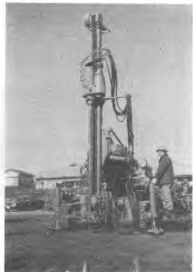
写真-21 ザルツギッター AB-403 せん孔機
