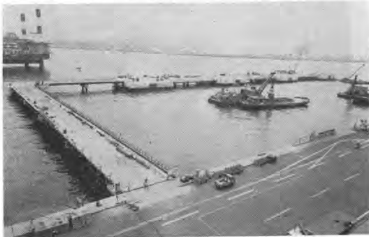
写真-1 浮きドック係留棧橋
