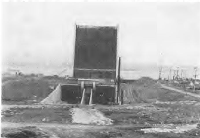
写真-1 沈埋トンネルの現況(大井側)
