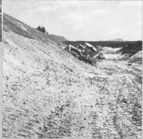
▼ ブルドーザによる切土のり面 の施工(のり面こう配 1:1.5)
