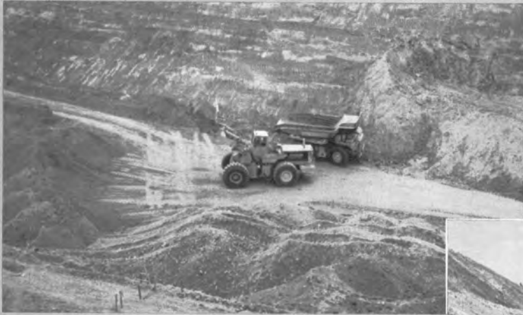
▼ ブルドーザによる切土のり面 の施工(のり面こう配 1:1.5)
