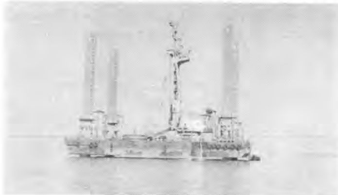
写真-2 SEPによるくい打ち
