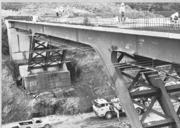
▶ 鋼構造のオーバブリッジ
