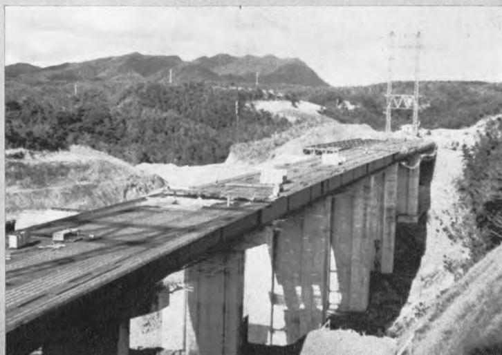
▶ 床版にIBグレードを使用している湖辺底橋の架設状況
