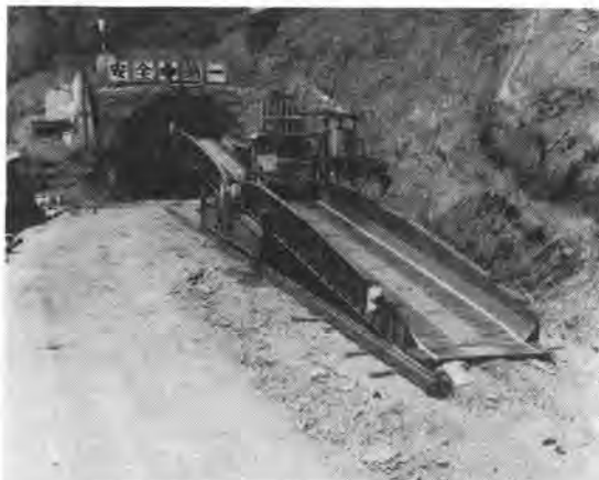
写真-1 移動式橋梁(斜路)
