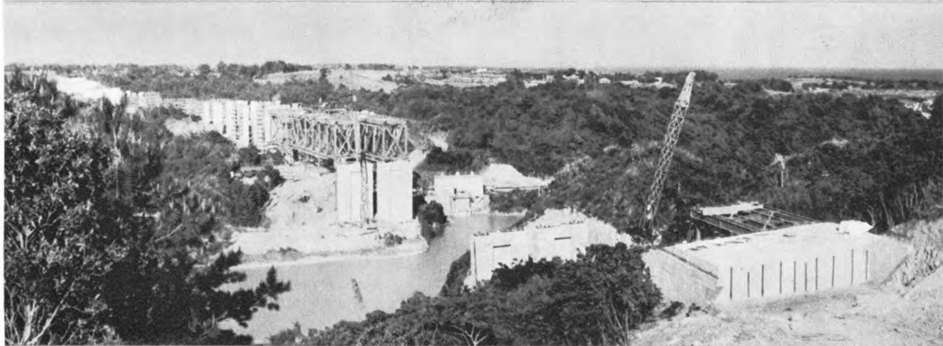
▲ 金武ダムにかかる億首高架
