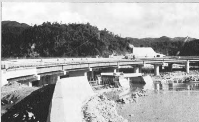
◀ 海面を締切って構築された許田 高架橋
