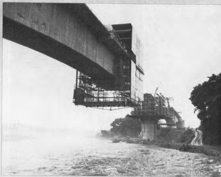
▲ 第2阿武隈川橋梁で、中央径間 105 m を有し、世界最長の PC 鉄道橋となっている。
