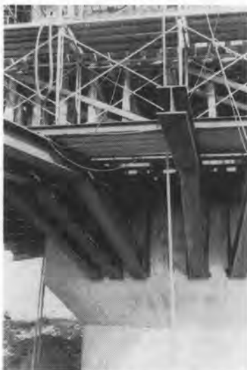
写真-3 柱頭部ブラケット
