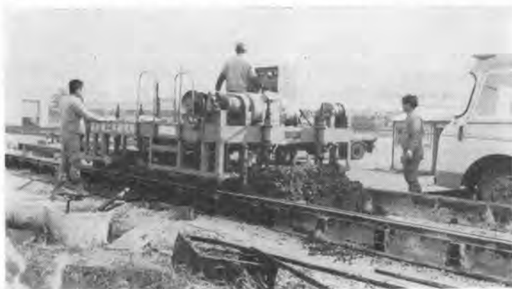
写真—1 コンクリート舗装版の締固め試験
