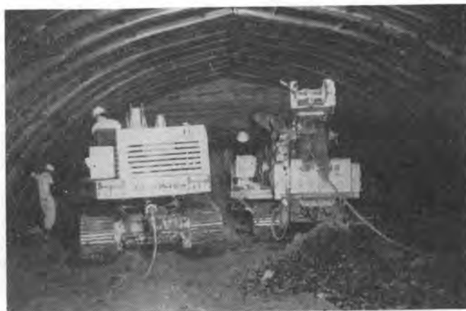
写真-5 第1左山トンネルでのCL-101による上半掘削
