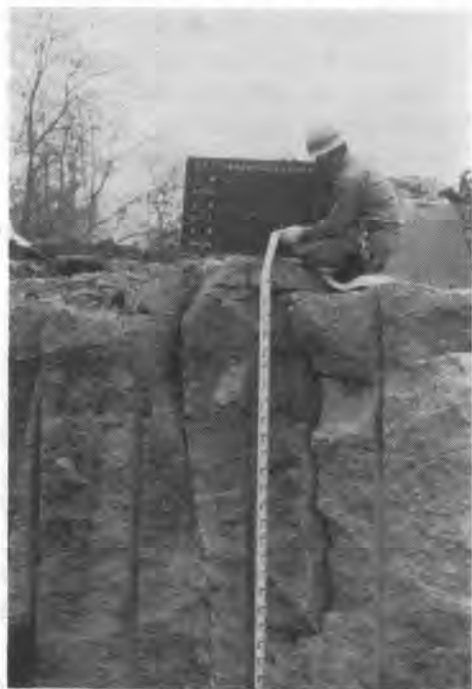
写真-2 プレスブリット工法断面
