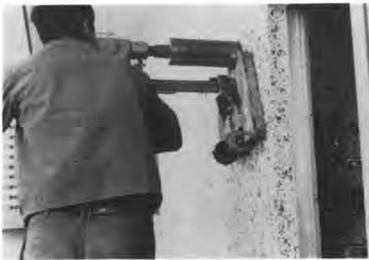
写真-3 ダイヤモンドビット付さく孔機
