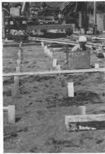
写真-2 打設された PVC ドレーン
