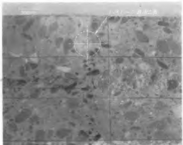
写真-2 コンクリート版横断面の粗骨材の配列状況
