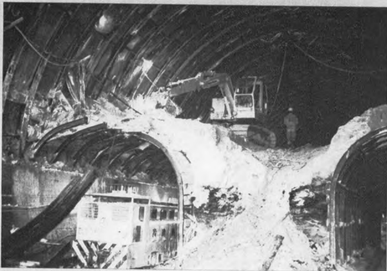
◀上太田トンネルの大背の掘削状況で、トンネルはサイロット工法により掘削された。
