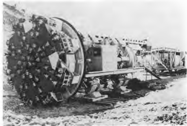
写真-1 岡トンネルで使用された R.T.M φ5.0 川崎ジャーバ
