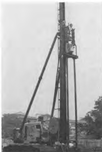
写真-1 PVC ドレーンの打設
