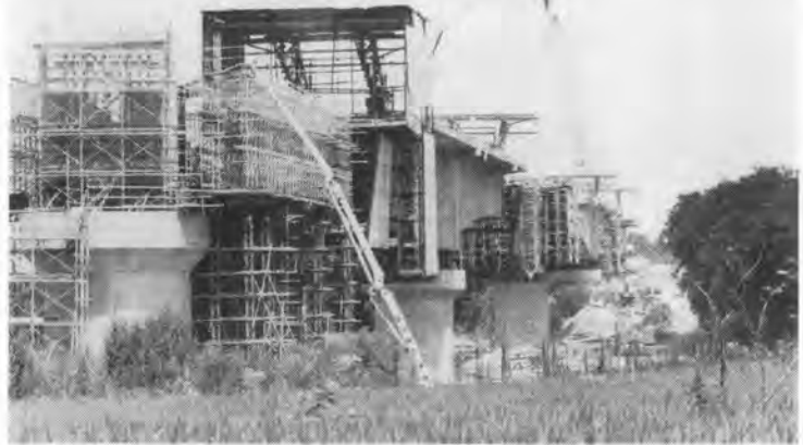
写真-1 工事中の阿武隈川橋梁
