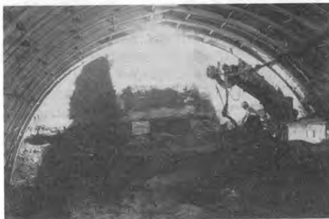
写真-6 大又トンネル（その1）394 k 220 m付近でのFL-R 23による上半掘削
