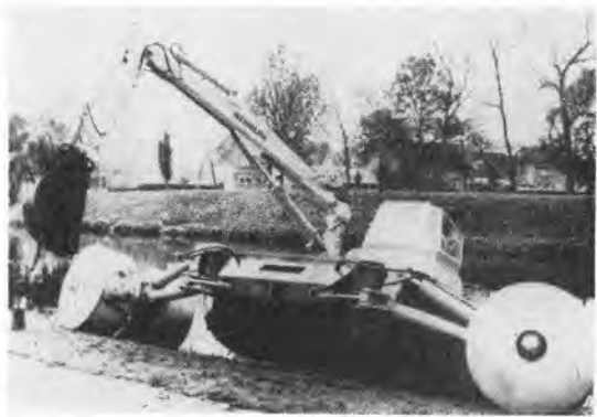
写真-2 不整地走行掘削機
