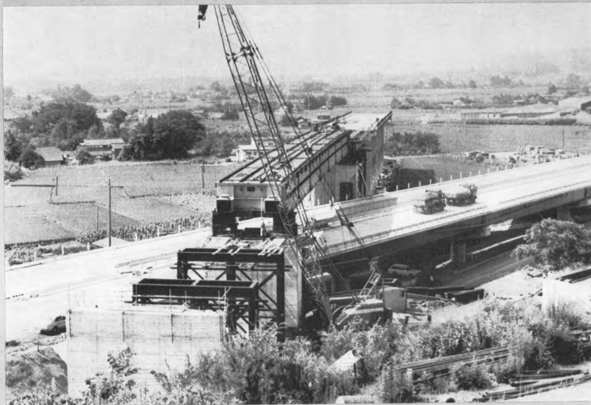
▲ 東北縦貫高速道路を跨ぐ山崎架道橋で、中央径間 70 m の合成げた橋梁である。蔵王トンネル入口より東京方を望む。
