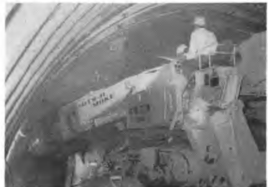
写真-3 MRH-S90 による上半掘削
