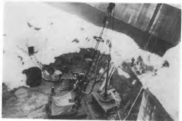
写真-1 掘削機の運転状況
