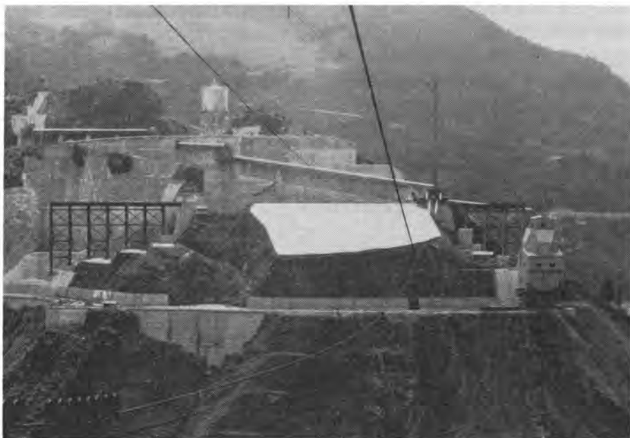
写真-3 20t ケーブルクレーン（移動塔側）
