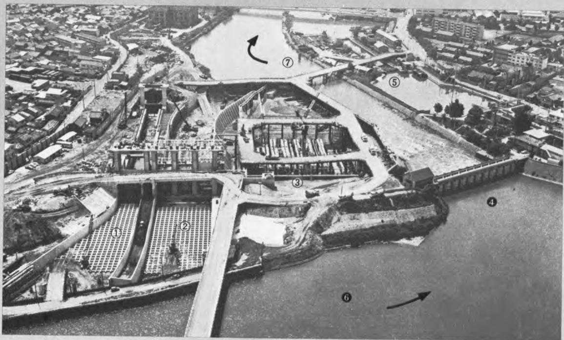
▲ 毛馬水閘門工事現場の全景 ①新毛馬閘門 ②新毛馬水門 ③毛馬排水機場 ④現毛馬洗堰 ⑤現毛馬第2閘門 ⑥本川 ⑦大川
