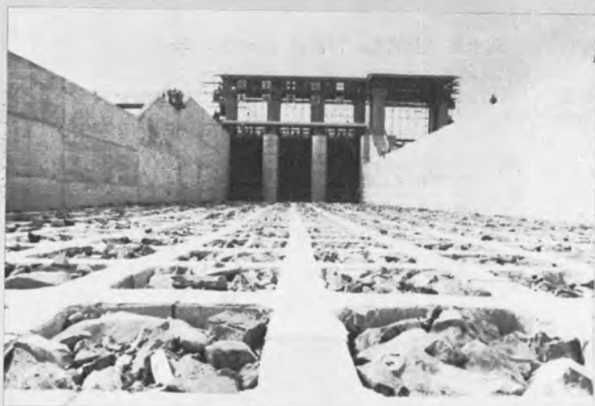
◀ 下流側より見たほぼ完成した新毛馬水門 (3 @ 7 m, 制水ゲート高 10.97 m)
