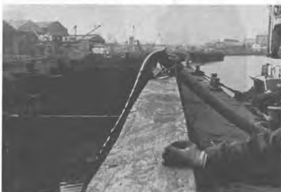
揚泥(含泥率93.5%)状況
