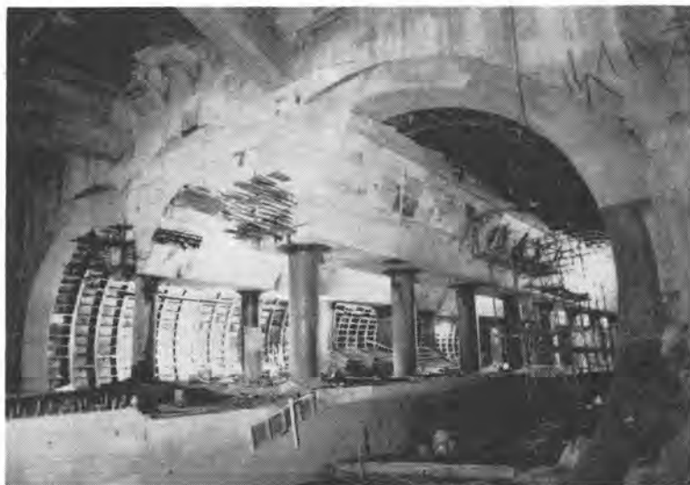
写真-1 完成したシールド駅躯体
