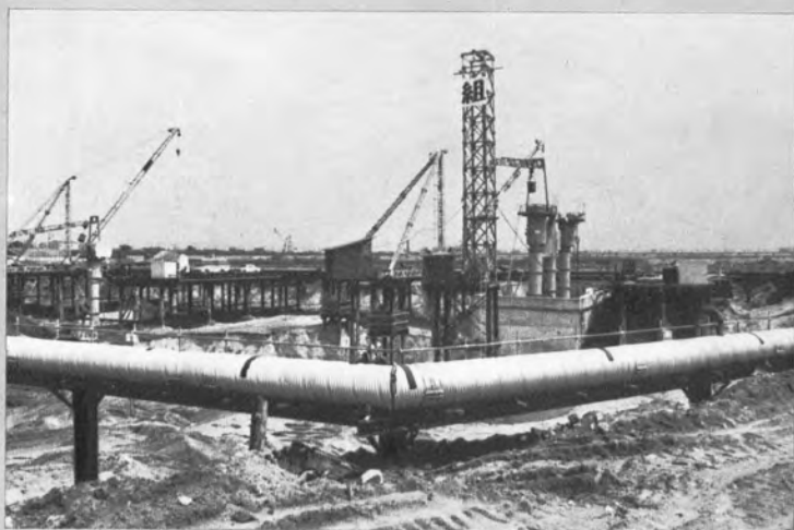
◀ ディープウェルによる排水工
