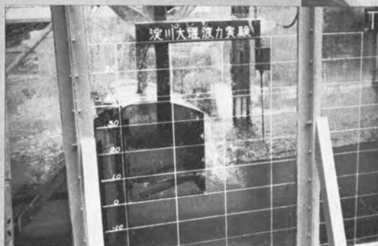
▲ 調節ゲートの波力水理実験
