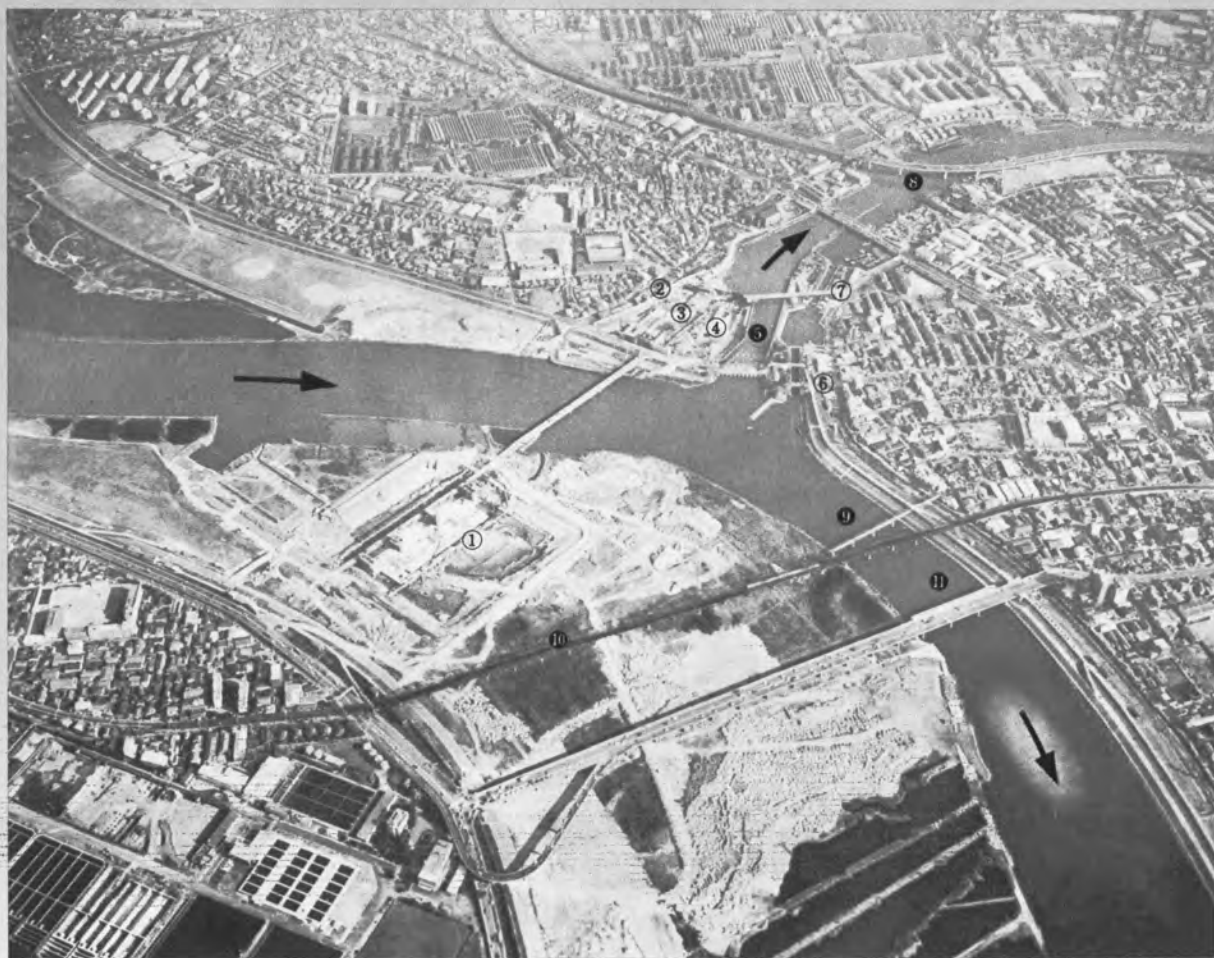
▲ 上空より見た淀川大堰建設現場全景
