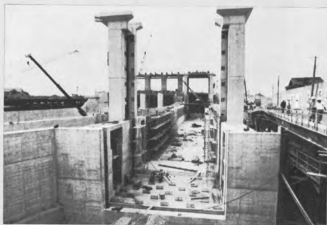
▲ 新毛馬閘門の閘室施工状況 (閘室寸法 11.35 m × 107 m)
