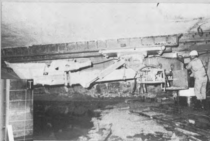
▲ ケーソン内部を掘削する小形掘削機で、ITVを使用して安全管理を実施した。
