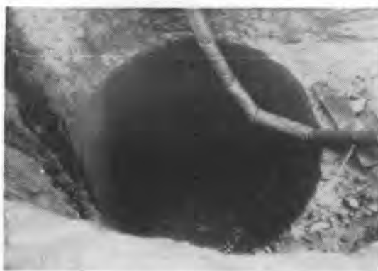
写真—4 孔壁仕上り状況
