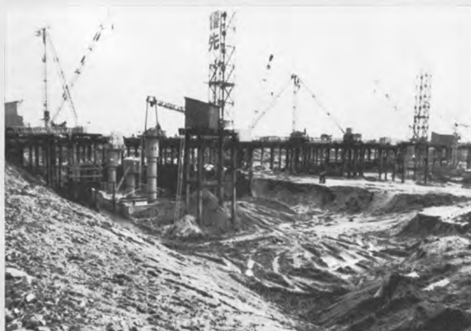
▲ 淀川大堰建設現場工事初期の掘削状況
