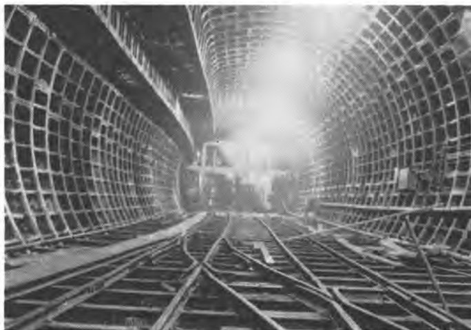
写真-2 円形シールドトンネルの施工
