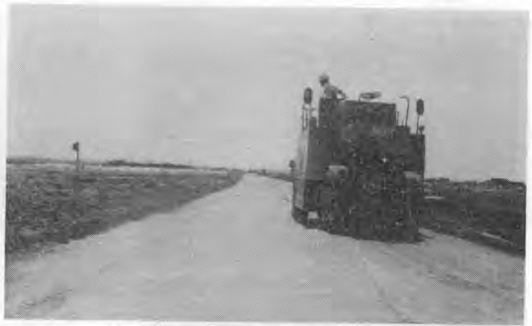
写真-6 タイヤローラによる仕上げ転圧
