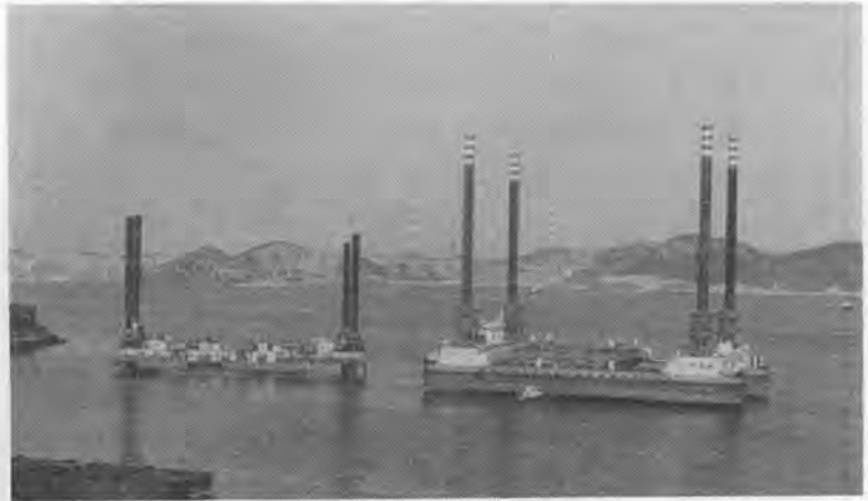
写真-3 工事用 SEP “せと” (左) と “たまの” (右)
