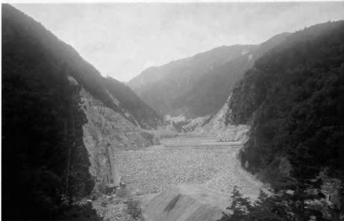
形式 ロックフィルダム ー長野県ー 高さ 176m 高瀬ダム 堤体積 1,140万m 3
