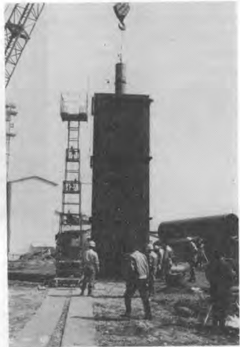
写真-3 鋼管杭協会で行なった全閉形防音カバーによるくい打ち実験
