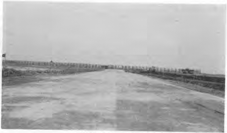
写真-7 石灰処理完成路床
