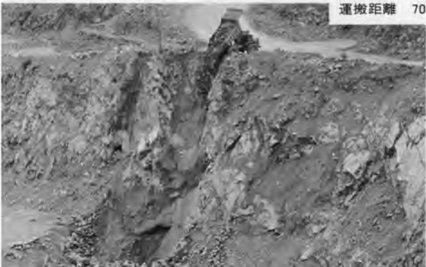
▲ ホッパー口へダンプする 769B ダンプトラック
