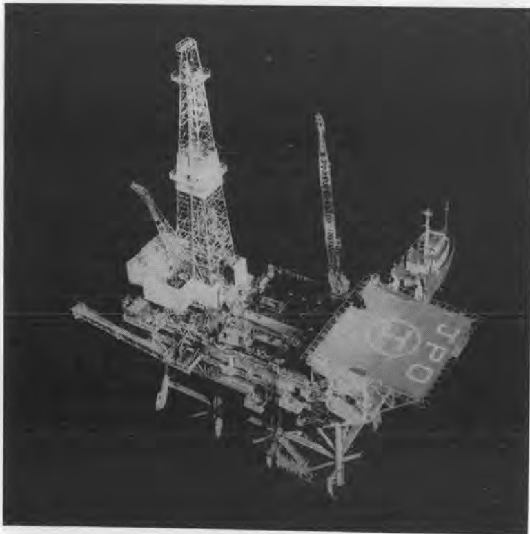
写真-1 阿賀野沖の石油さく井用足場
