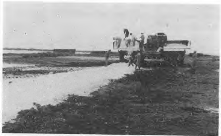
写真-3 ソイルライマによる石灰運搬・散布
