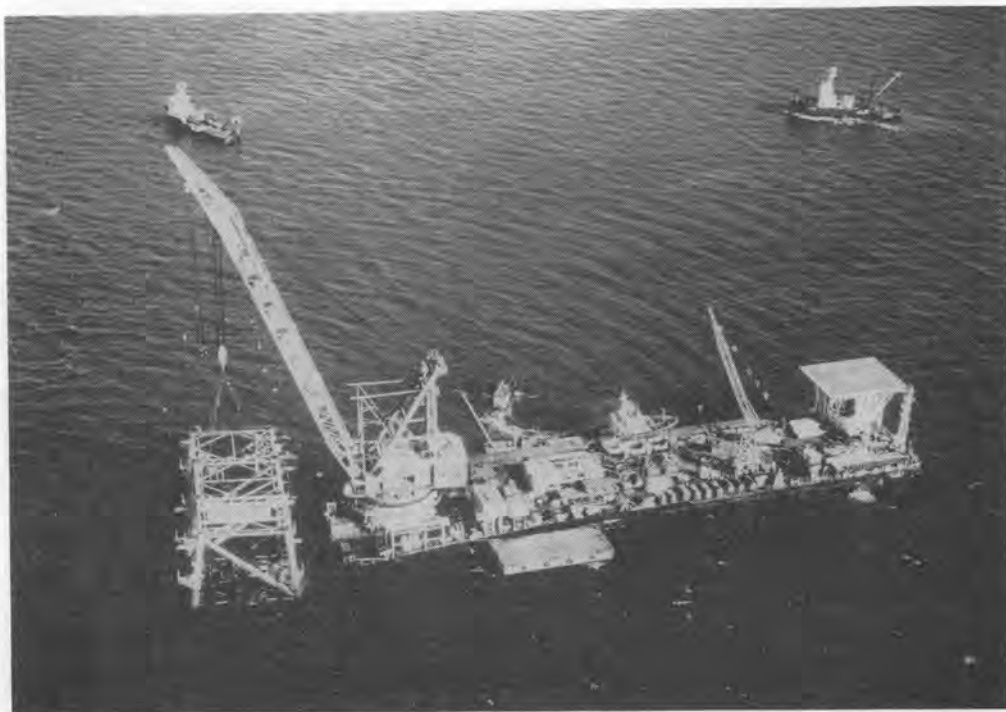
写真-2 ジャケット据付中のレイバージ“くろしお”
