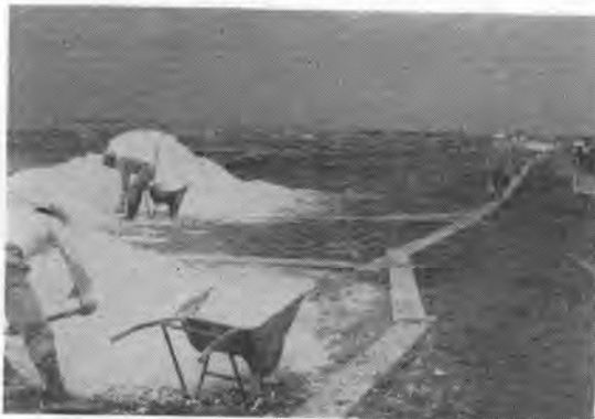
写真-2 人力による石灰運搬
