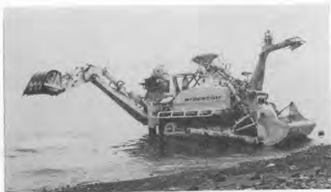
写真-5 水中ブルドーザ (パワーショベルが装着してある)
