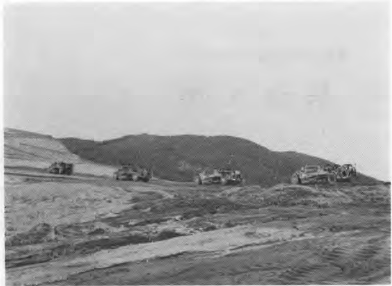
→ 写真-6 大量の大形モ ータスクレーバが投 入された土取り現場
