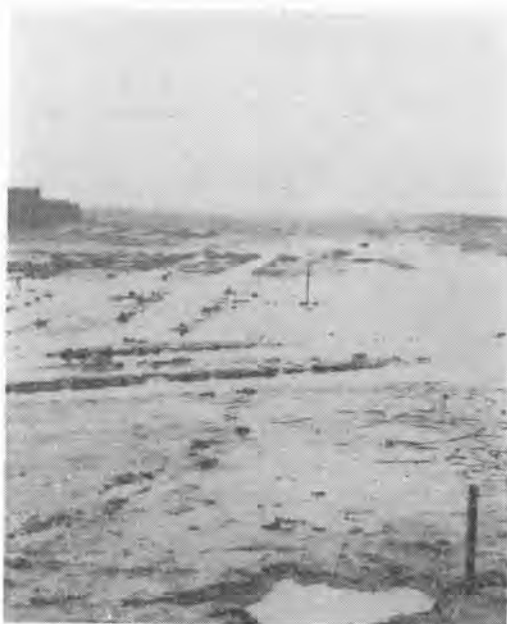
写真-1 施工現場の状況
