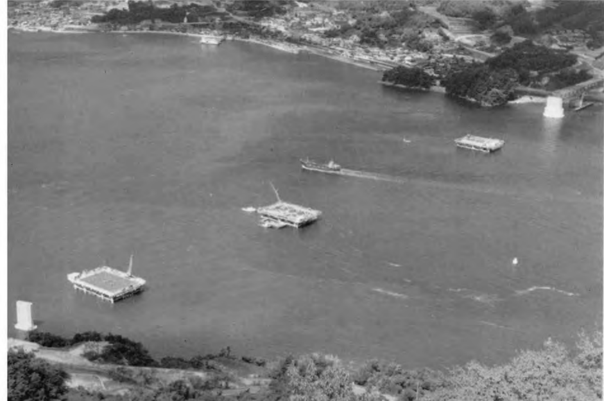
大島大橋 形式 上部：3径間連続トラス1等橋 下部：多柱式基礎 山口県 橋長 1,020m 幅員 6.5m
