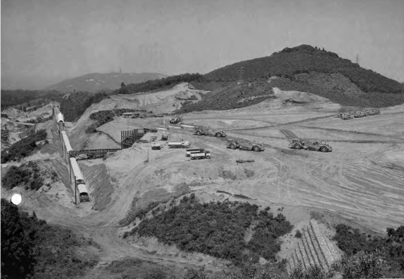
浅間山土砂採取 目的 埋立造成用土砂採取 総土量 8,000万m 3 ー千葉県ー
