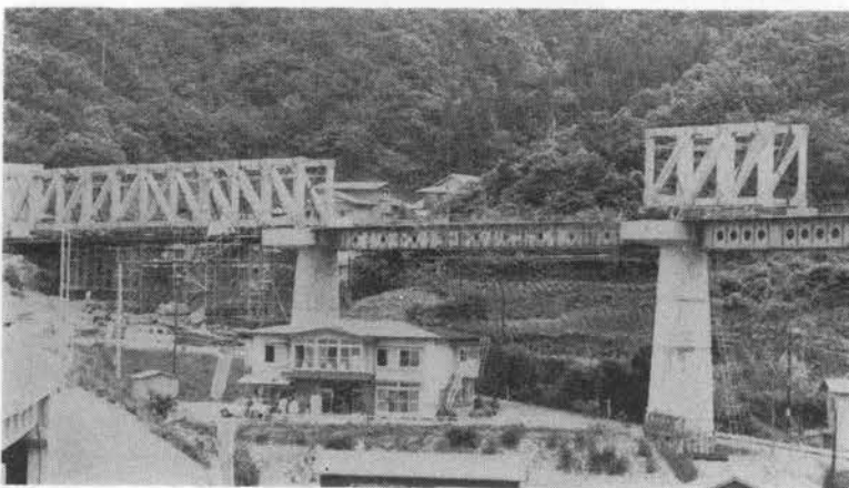
写真-4 引出し状況 (第7径間終了)
