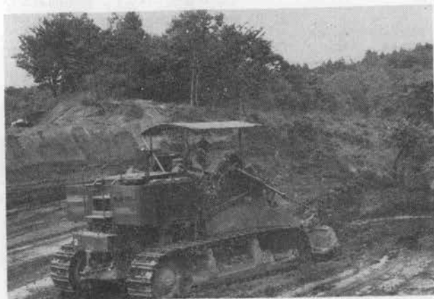
写真-2 はぎとり工事
