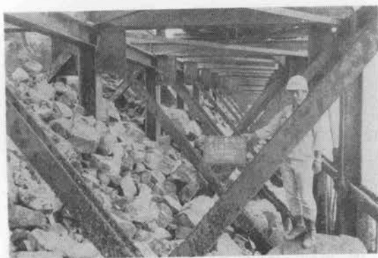
写真-8 荒止め完了後の鋼製わく内の捨石状況
