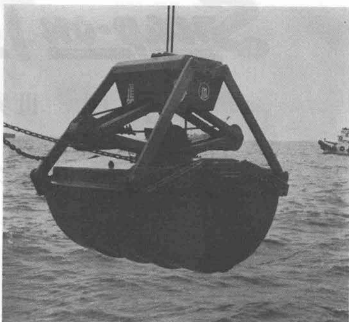
作業中のヘドロ用MNPバケット
