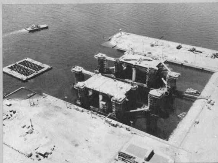
▶ メインデッキの搭載状況
