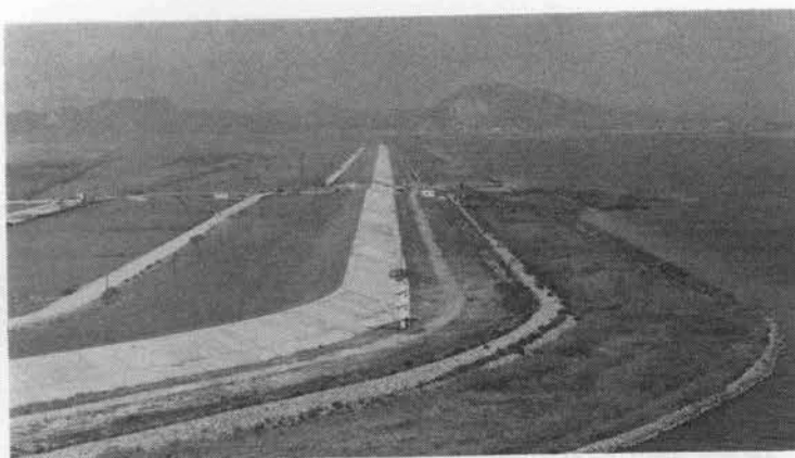
写真-2 完成した干拓堤防
