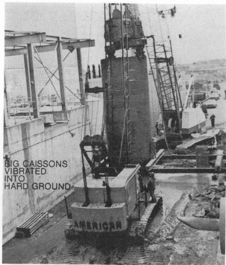
← タンデム式バイブロハンマ による大口径ケーソンの打込み
