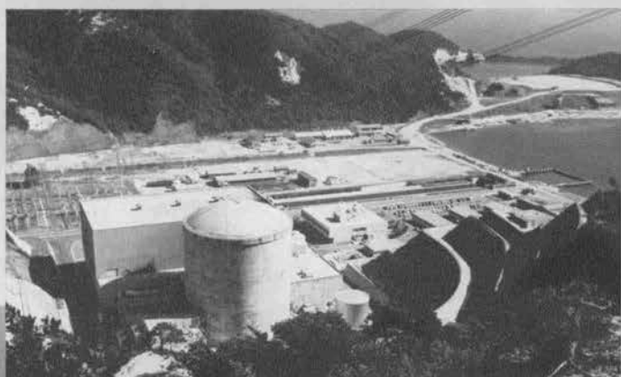
△ 敦賀原子力発電所 (出力 357,000 kW) —日本原子力発電(株)—
