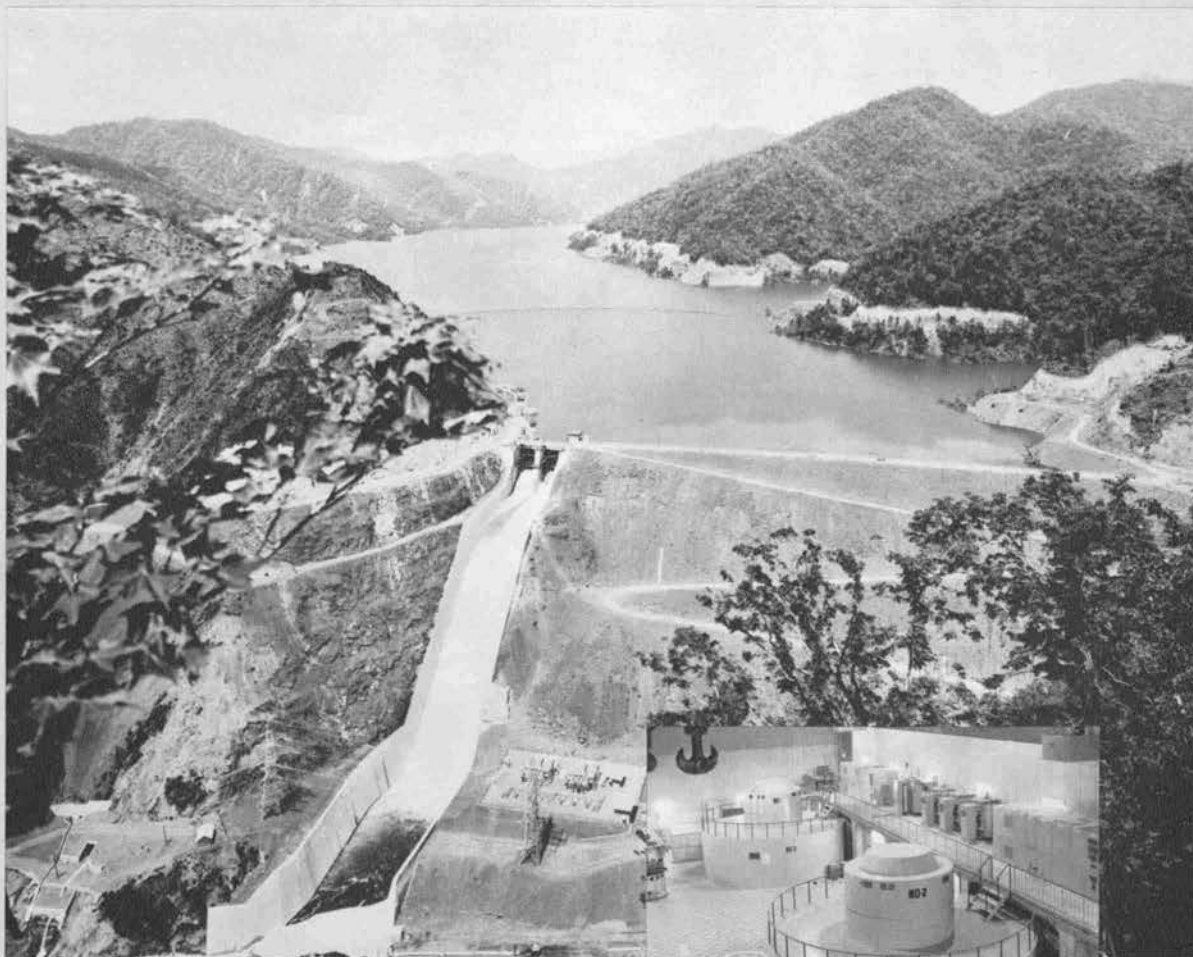
△ 新冠揚水発電所 (出力 200,000 kW) —北海道電力(株)—
