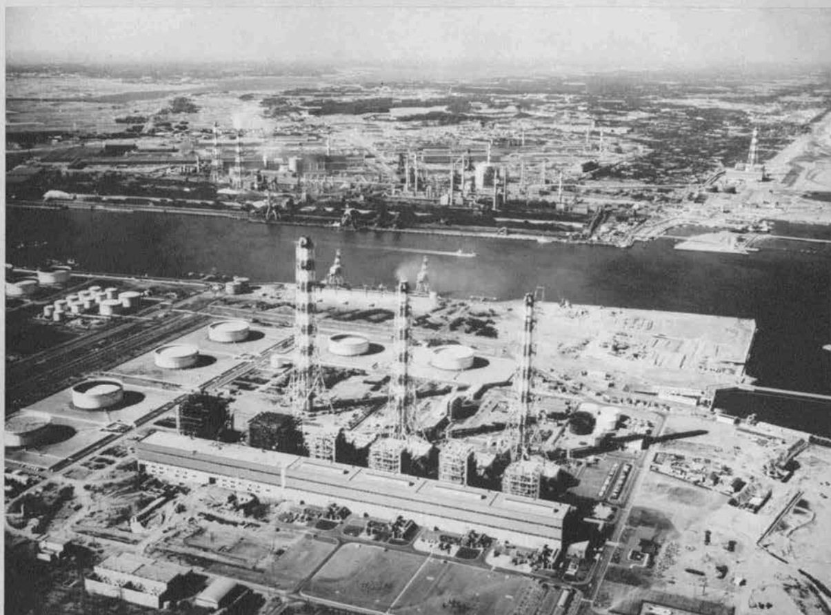
△ 鹿島火力発電所 (総出力 4,400,000 kW) —鹿島共同火力(株)—
