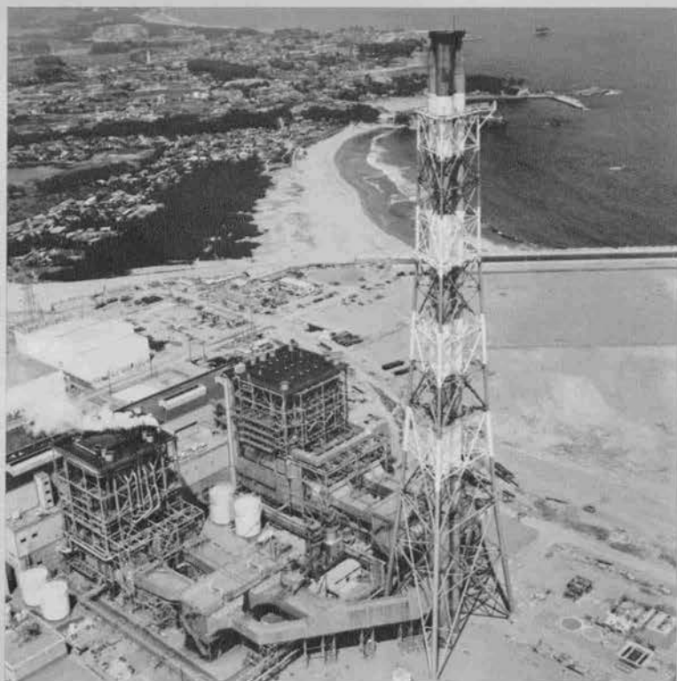
▷ 新仙台火力発電所 (総出力 950,000 kW) —東北電力(株)—
