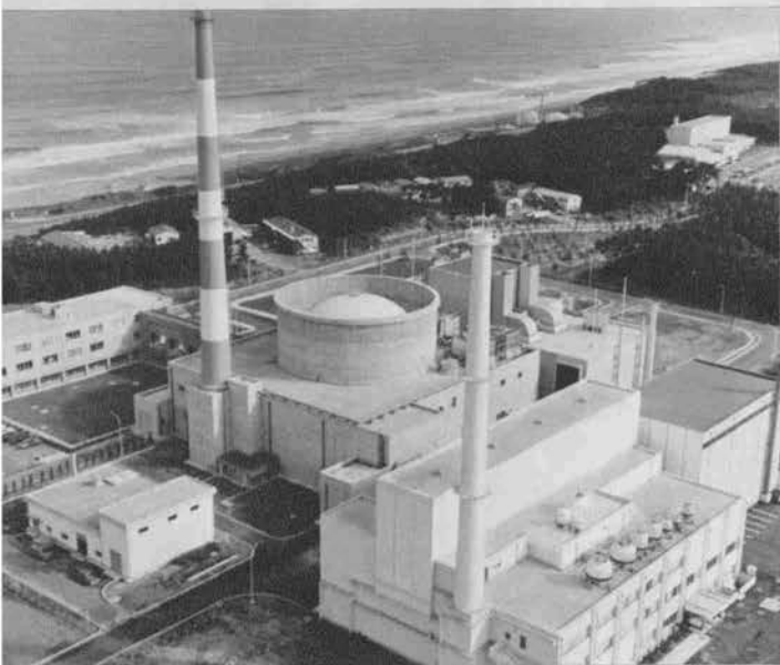
△高速実験炉“常陽”—動力炉・核燃料開発事業団—
