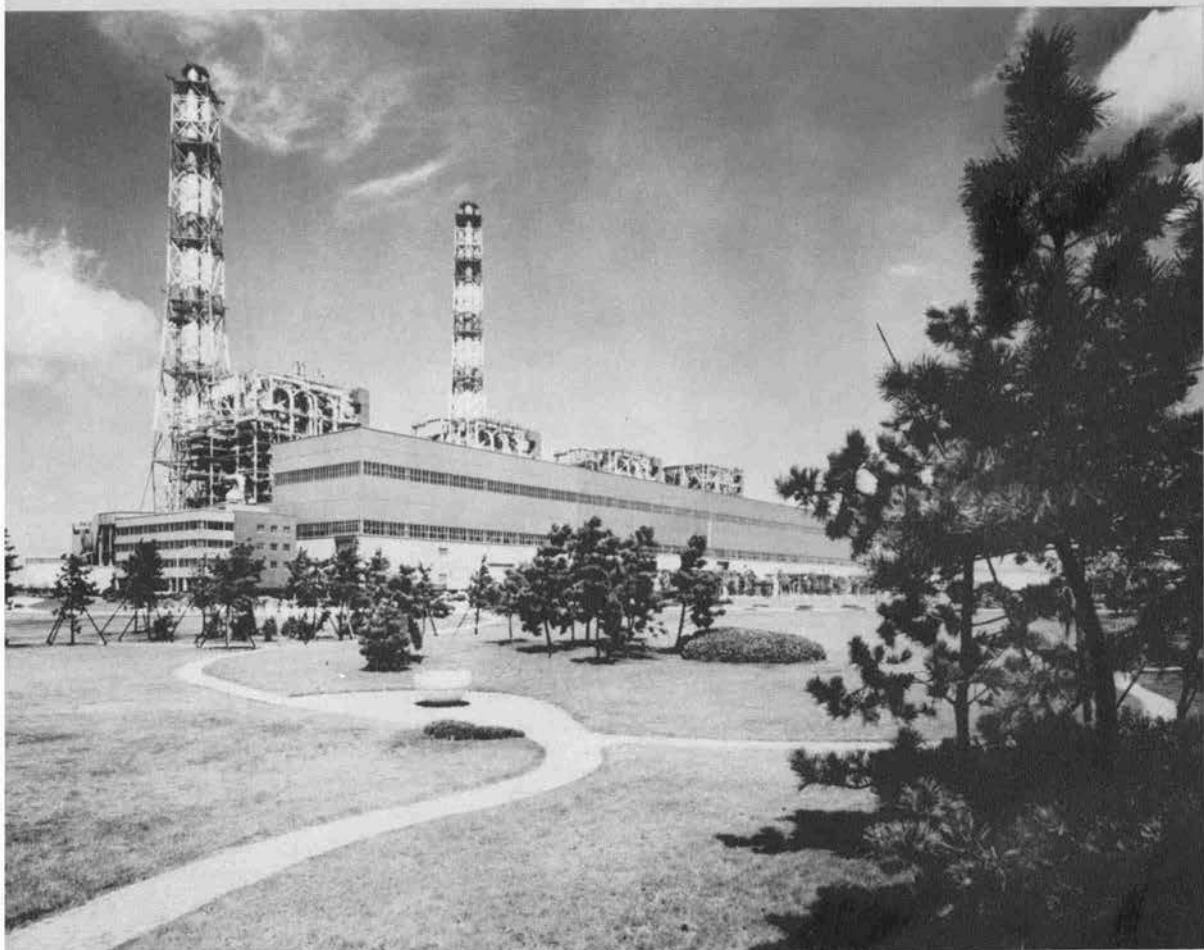
▽ 姉崎火力発電所 (出力 2,400,000 kW) —東京電力(株)—
