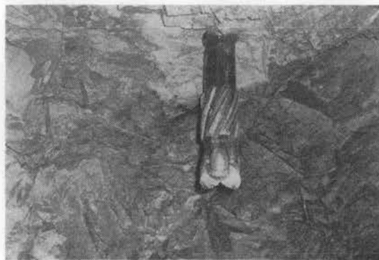
写真-9 パイロット孔貫通状況
