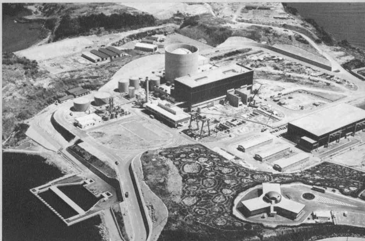
△ 玄海原子力発電所 (総出力 1,118,000 kW) —九州電力(株)—
