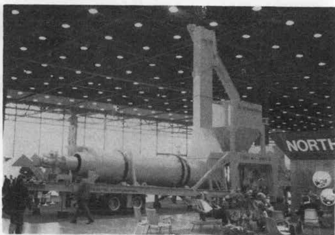
Allis Chalmers-Stan Steel のドラムミキシングプラント (90 t/hr)
