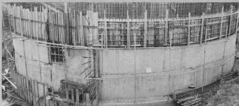
◀ 発射管制棟の工事 —昭和48年9月—
