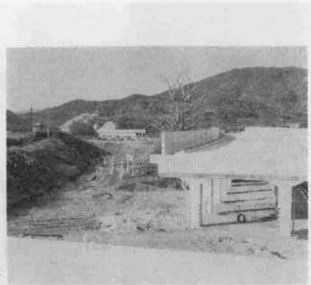
写真-6 紀勢本線佐和～道成寺間線増工事 (日高川橋梁付近)
