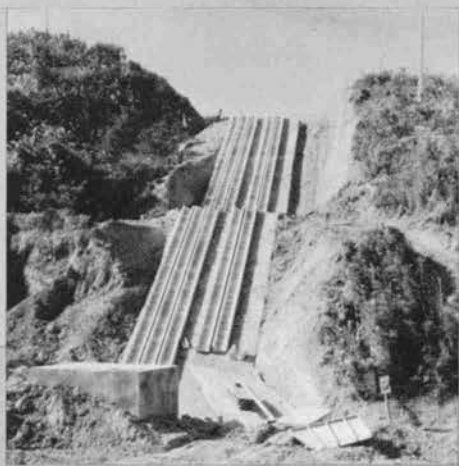
◀ 電線路の建設 -昭和48年11月-
