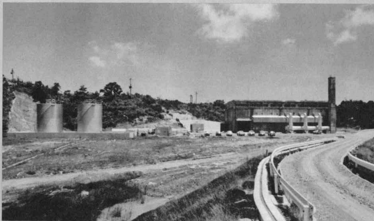
▲ 大崎発電所 一昭和49年6月一
