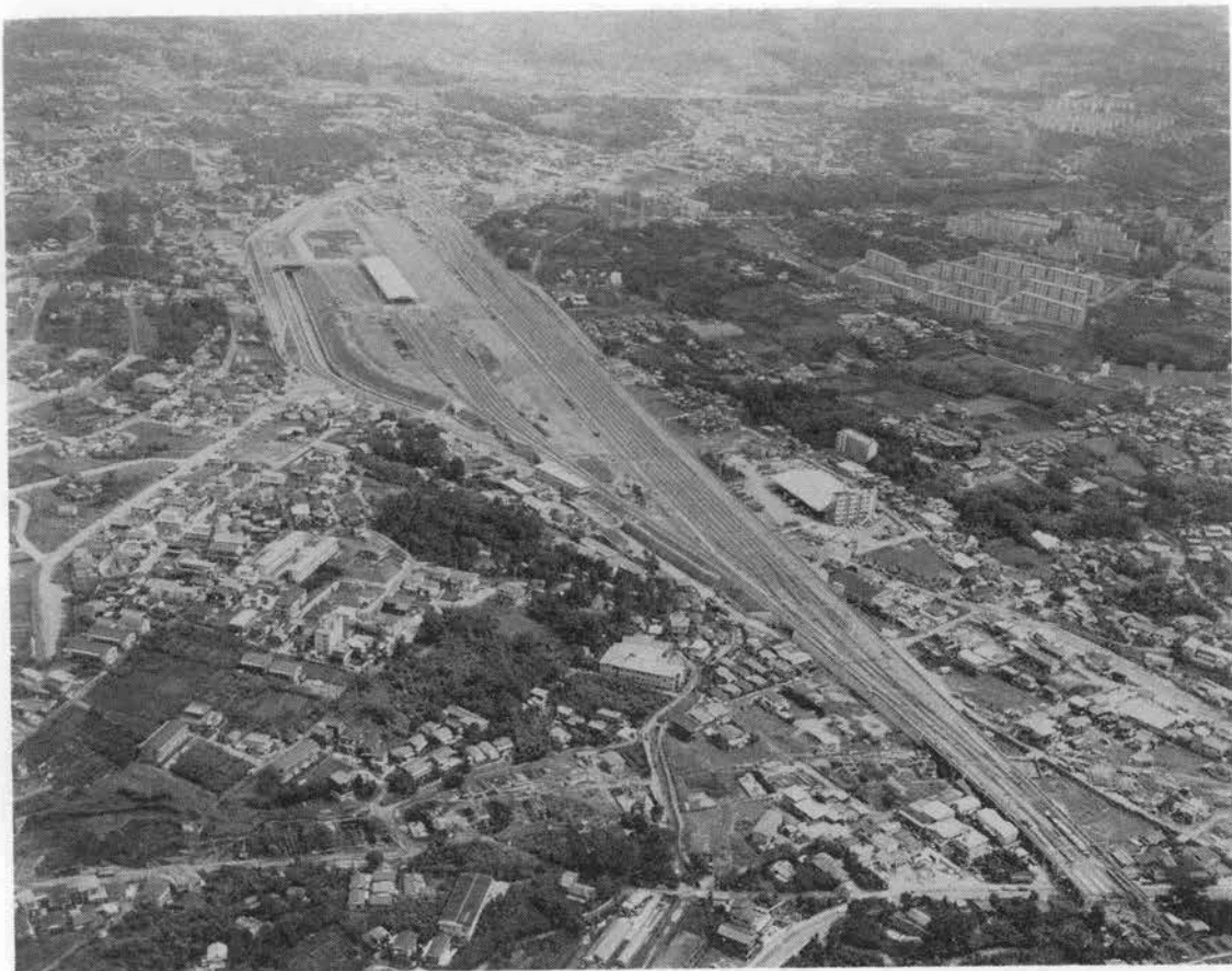
写真-2 完成間近い武蔵野南線梶ヶ谷貨物駅
