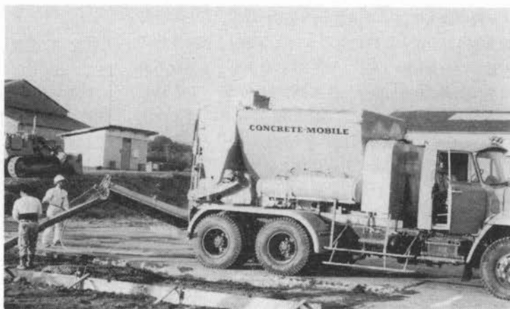
写真-318.1 連続式ミキサの試験状況
