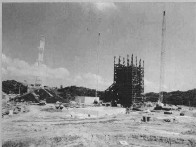
▶ Nロケット整備塔の建設 —昭和49年6月—
