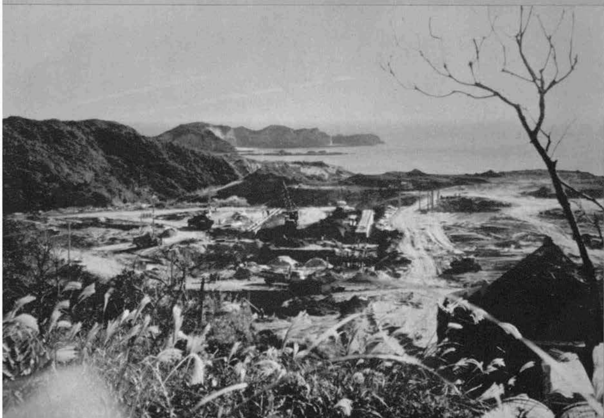
▼ 建設中の大崎射点全景 —昭和48年12月—
