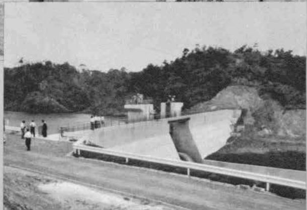
取水堰と貯水池 -昭和49年6月- ▶
