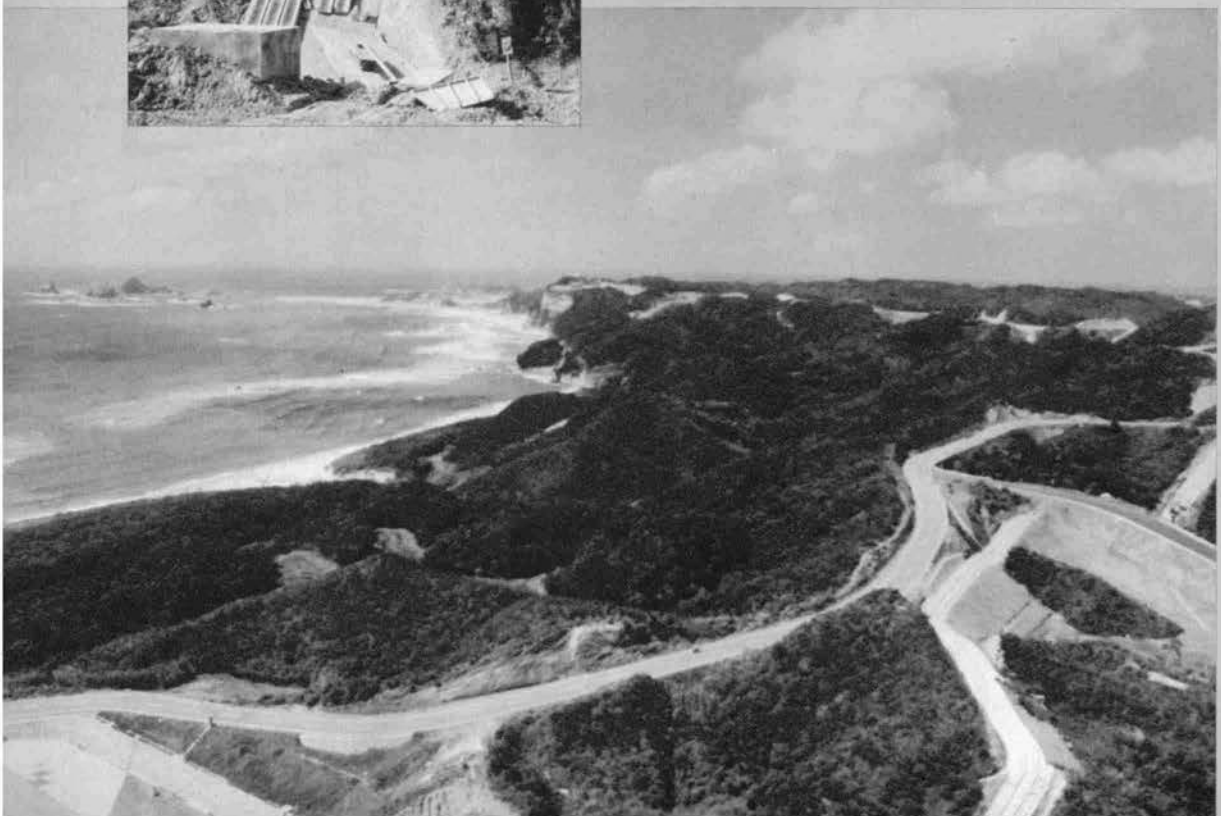
▼ 電線路と道路 -昭和49年6月-
