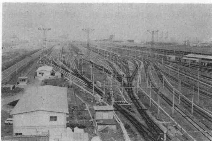
写真-3 大井新幹線車両基地
