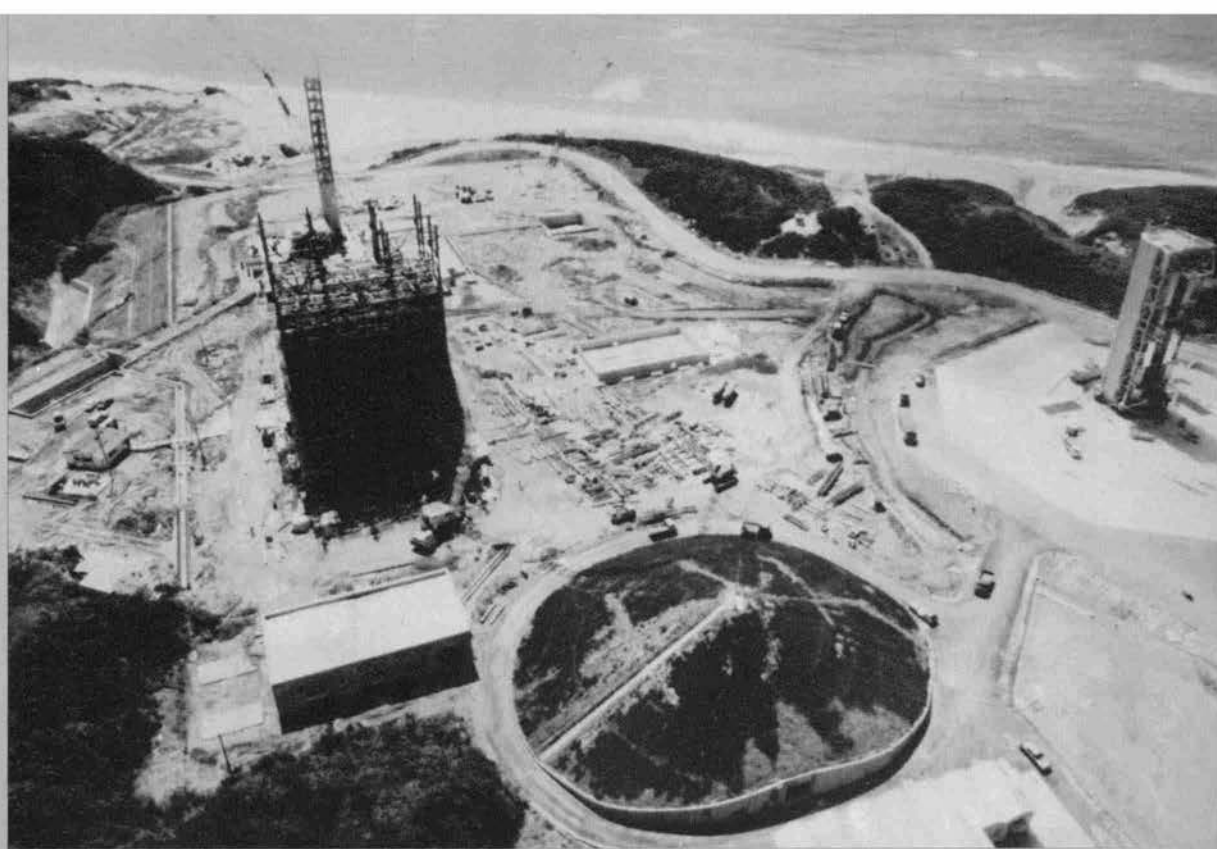
▲ 建設中の大崎射点全景 —昭和49年6月—
