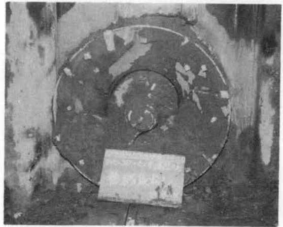
写真-5 立坑に到達した先導管
