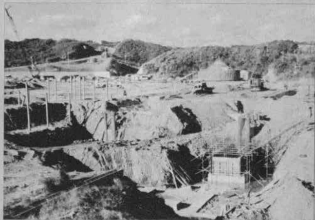
◀ 建設中のNロケット射点 —昭和48年11月—
