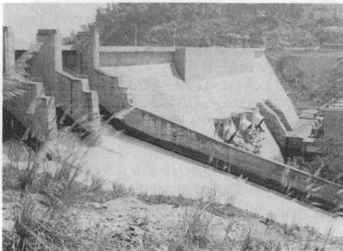
写真-1 多くの協力国(わが国も無償資金を拠出)により建設されたメコン河支流のナムダム水力発電所(ラオス)
