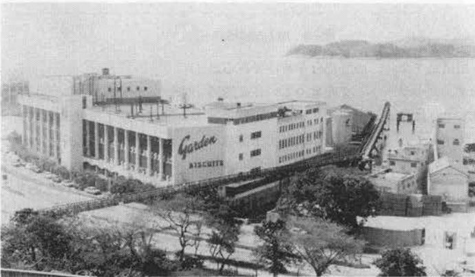
← 写真-5 海上部埋立の土砂を積出すベルトコンベヤ
