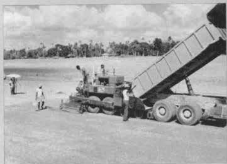
▲ 試験舗装中のフィニッシャと ダンプトラック —ケニア—
