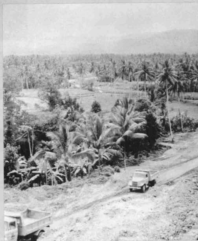
道路建設工事 ▶ —北セレベス—
