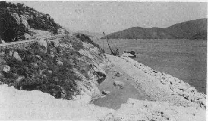
← 写真-6 現在道路を海側に付替える部分の防波堤築造状況
