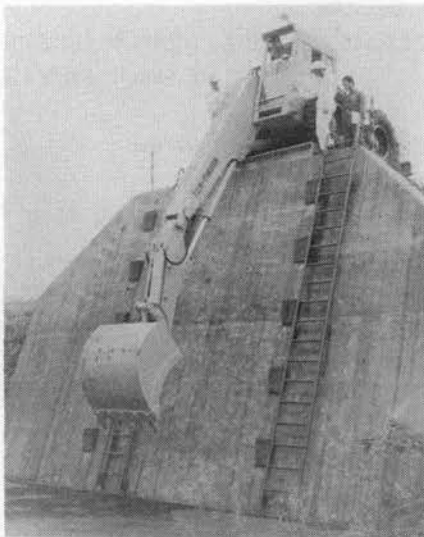
写真-320.1 作業範囲の測定
