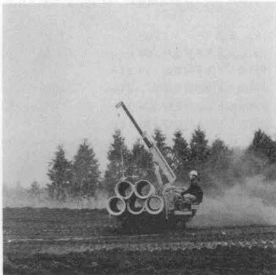
写真—319.1 運搬作業試験状況
