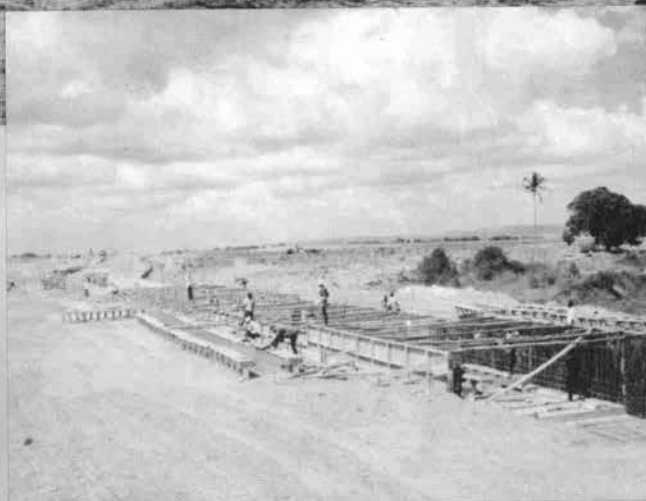
排水路工事 ▶ —ケニア—
