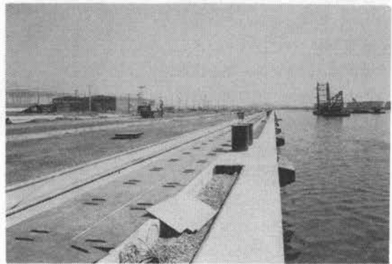
写真-4 No. 2 岸壁延長部
