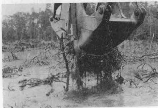
写真-1 16m 3 グラブによるマングローブ根木の掘起し
