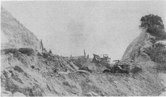
← 写真-4 岩切り部分で活躍する重機械
