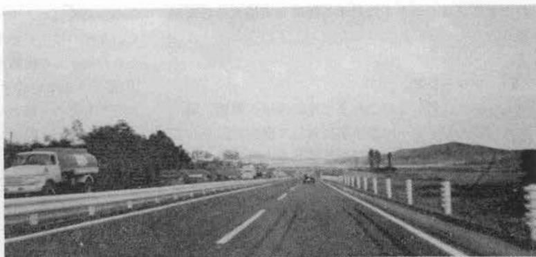
写真-1 ソウル～釜山間高速道路建設事業（韓国）
