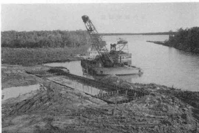
写真-2 完成間近の鋼矢板岸壁と仮航路
