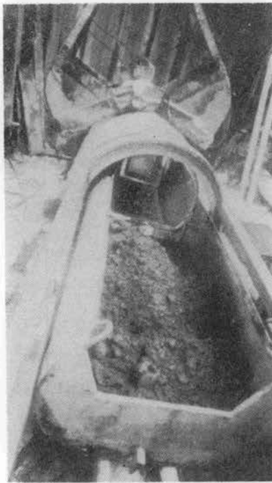
← 写真-2 運搬バケットに土が積まれてピットに運ばれた土はグラブバケットで排土される。
