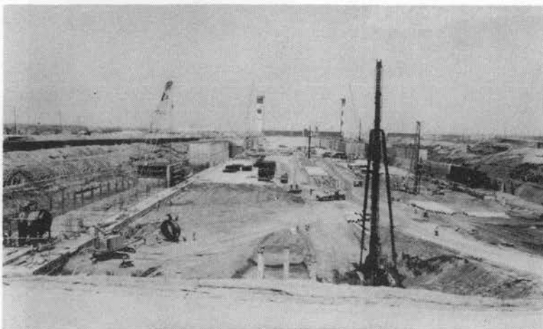
写真-2 施工中のドック（渠口より見る）
