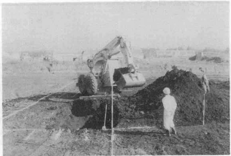
写真-320.3 つぼ掘り作業状況
