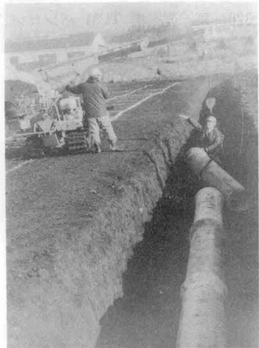
写真—319.2 運搬敷設作業試験状況
