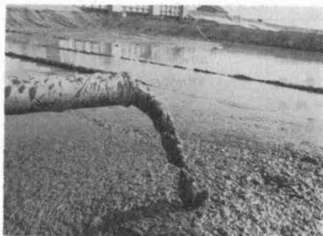
写真—2 送泥状況
