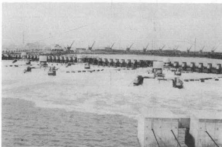
写真-2 促進酸化池でのエアレータの運転状況 (背後は揚陸基地のクレーン)
