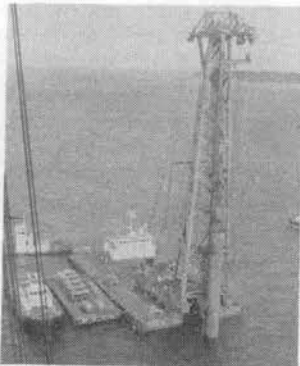
写真-4 主接岸ドルフィンくい打込み (第十大成丸)
