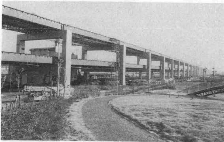
写真-1 工事完了した高架橋
