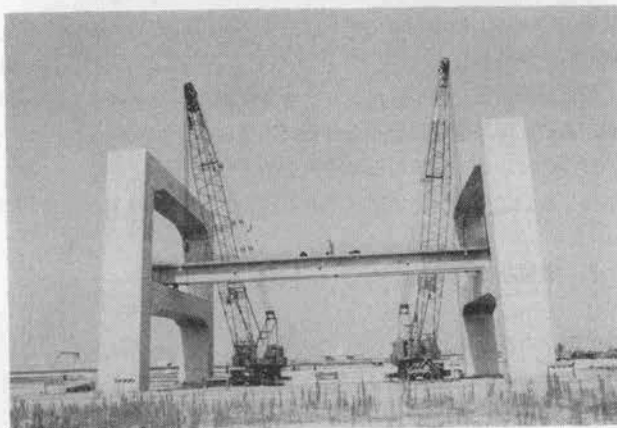
写真-6 トラッククレーンによるPCげたの架設
