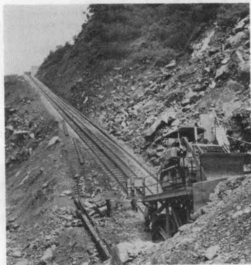
写真-4 インクライン (砂防ダム用)
