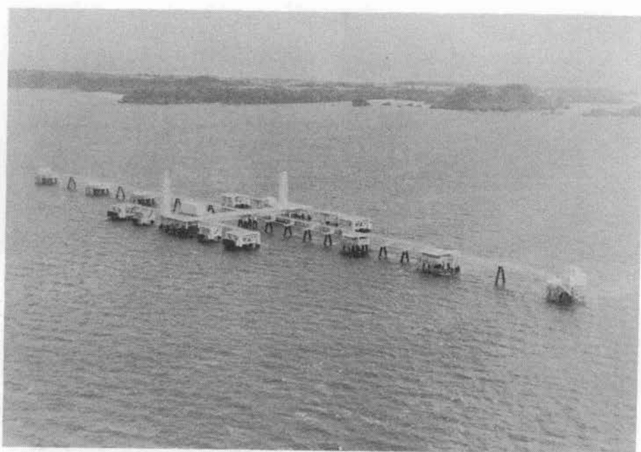
写真-17 完成した沖縄 CTS シーパース
