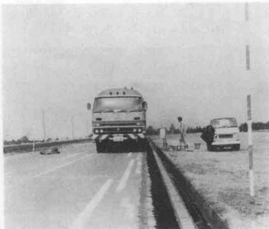
写真—322.1 標準土砂の清掃作業試験状況
