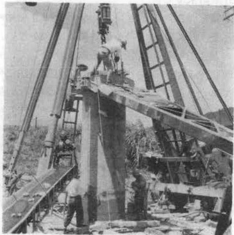
ベノト No.6 型掘削機チューブの溶接
