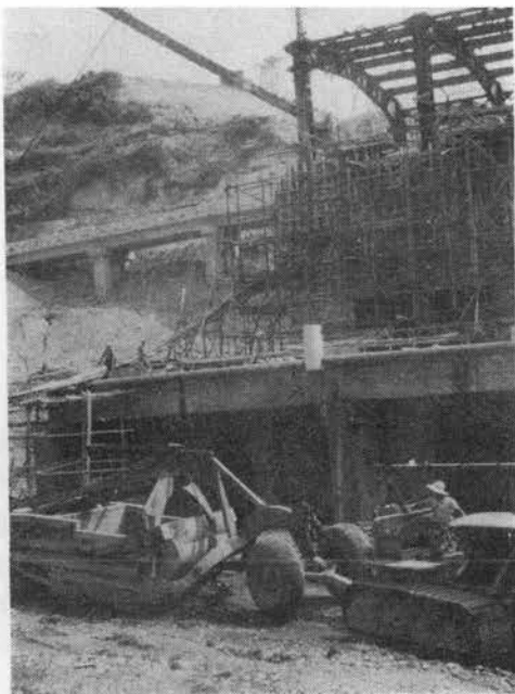
スクレーパによる信濃川・ 小千谷発電所放水路の掘削 →
