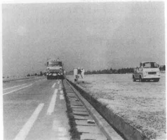
写真—322.2 異形物の清掃作業試験状況
