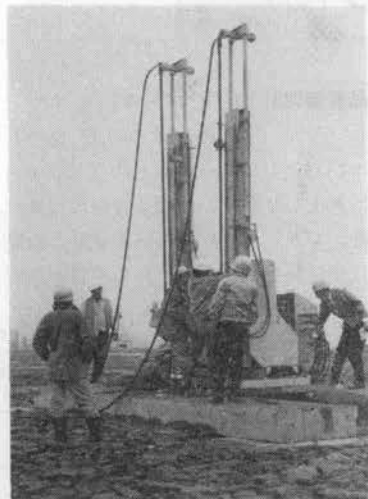
写真-14 超軟弱地盤急速改良機 (2 連式注入機)
