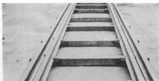
写真-26 鋼製枕木
