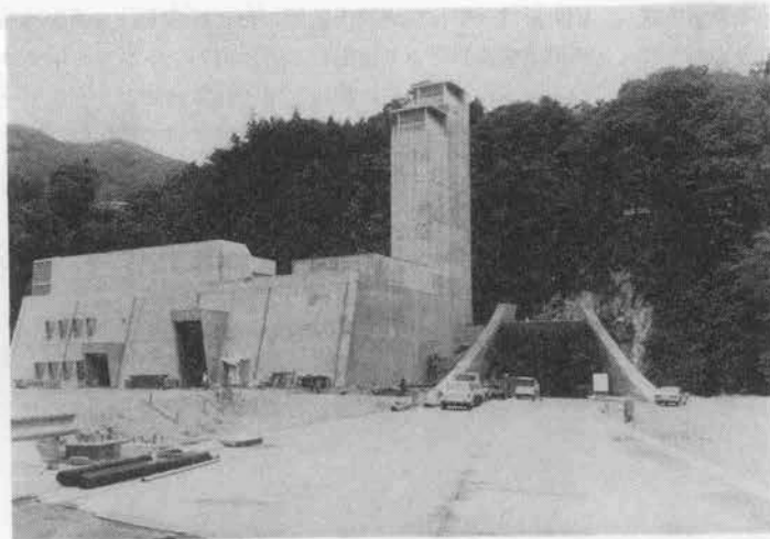
写真-1 恵那山トンネル飯田方坑口（左側の建物は換気所）
