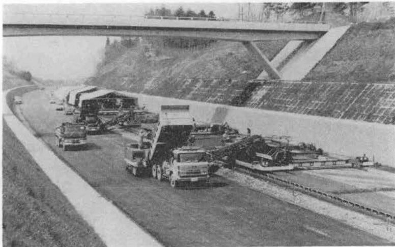
写真-2 施工中の各機械群
