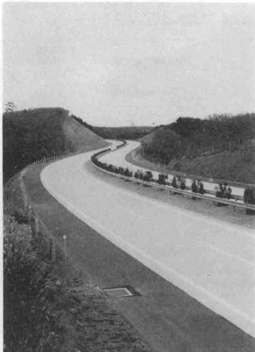
写真-1 完成したコンクリート舗装
