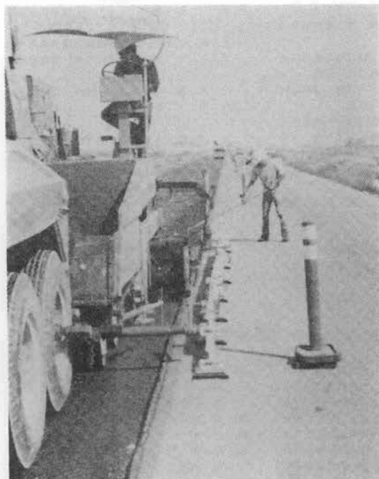
写真-1 フィニッシャにより合材が敷きならされる
