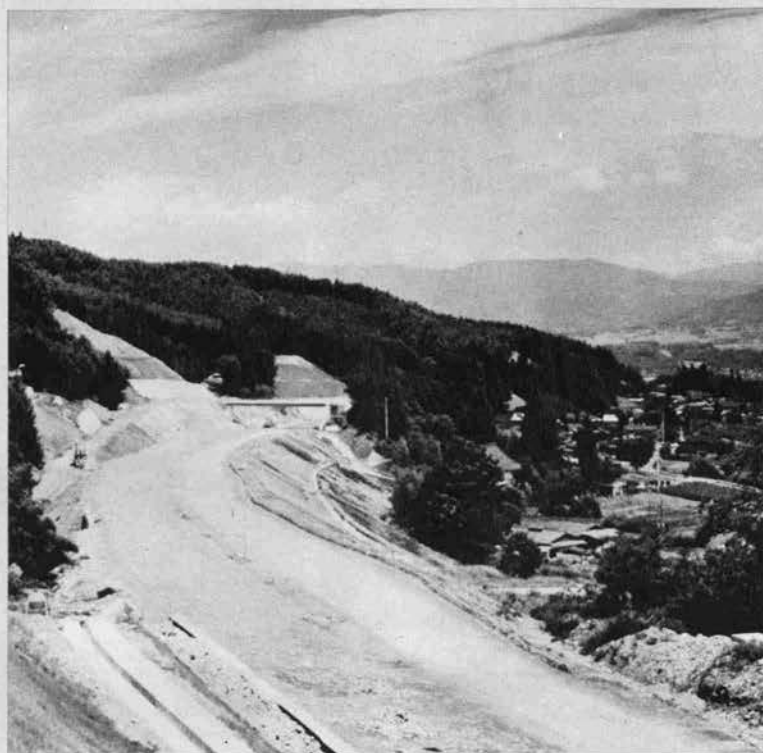
◀ 中央アルプスの山すそを ぬって土工工事が進む (上伊那郡宮田村付近)
