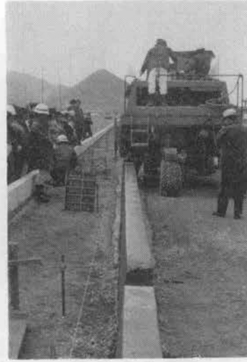
写真-3 ヒューロン機による施工状況および出来形
