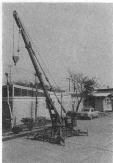
写真-5 パートクレーン O-45
