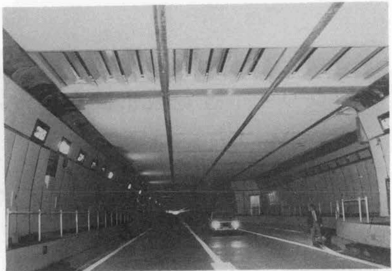
写真-5 網掛トンネルの内部(恵那山トンネルのすぐ東にある延長1,943mの長大トンネルで、右側の拡幅部は非常駐車帯)
