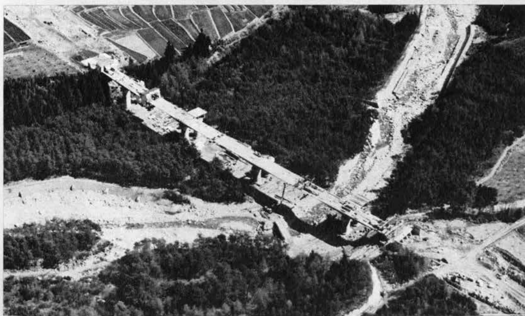
▲ 片桐松川橋 橋長 255.9 m、ディビダ ーグ工法による PC 5 径間連 続箱げた橋である。
