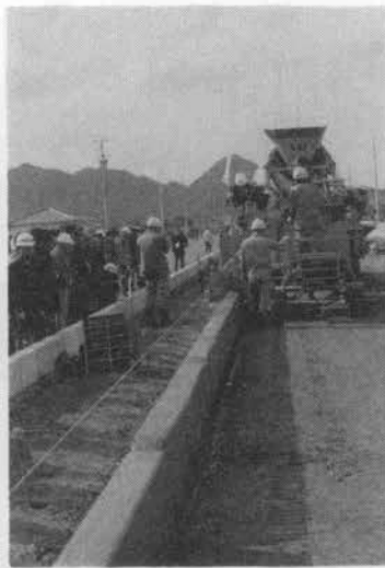
写真-2 パワーカーバー機による施工状況および出来形
