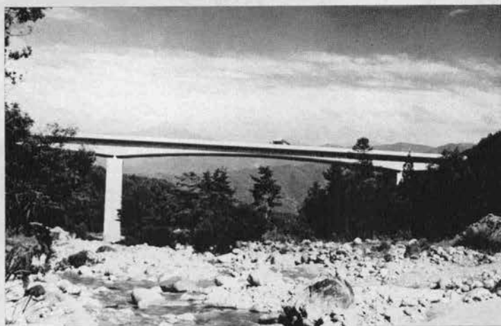
中央アルプスから流れ出す 激流に架る中田切川橋 ▶ 橋長 214.25 m、ディビダ ーグ工法による PC 3 径 間連続箱げた橋である。
